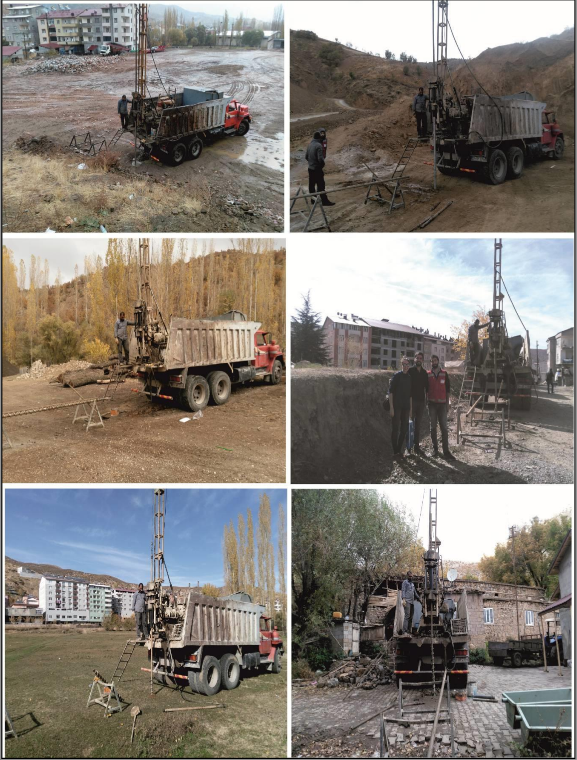
Şekil 3.8. Çalışma alanında yapılan sondajlardan görünüm
