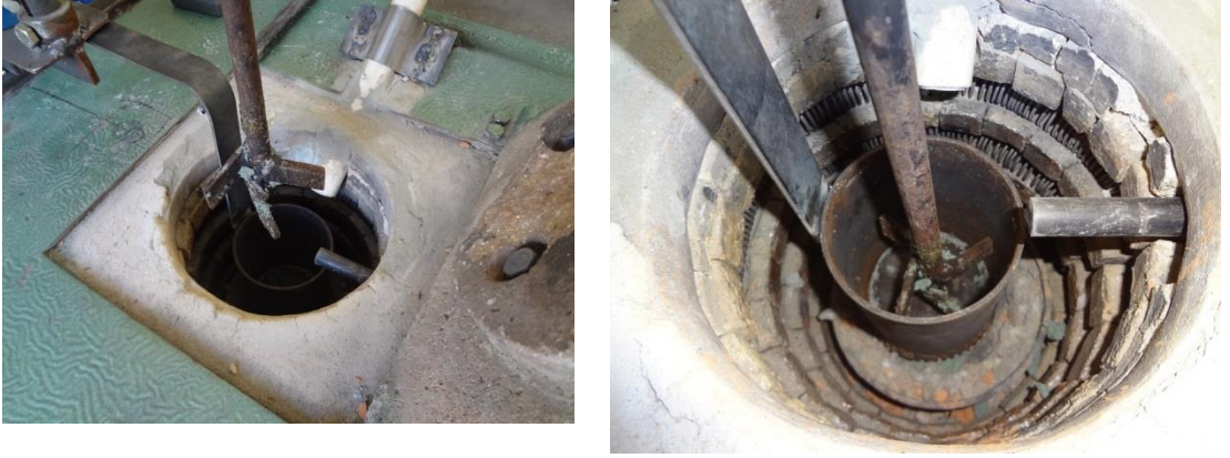
Şekil 4.8. Termokupl Montajlı Görünümü
