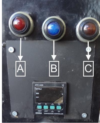
Şekil 5.2. Tork Değerine Göre PLC Kontrollü Çalışan İkaz Lambaları
