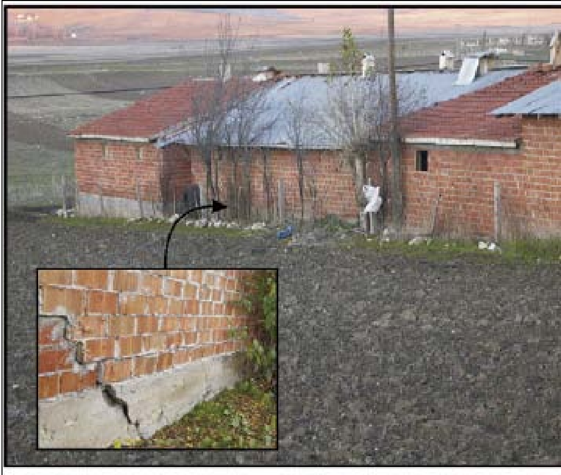
Şekil 4.13. Hamamlı Köyü besi ahırının duvarında krip hareketi sonucu meydana gelen sağ yanal deformasyon.
