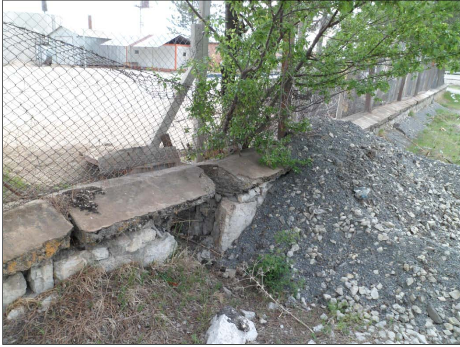
Şekil 4.10. İsmetpaşa Karayolları Bakım İstasyonu duvarı.
