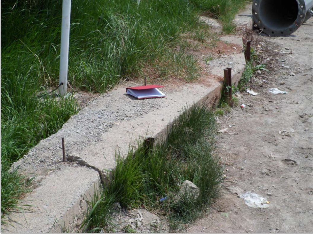
Şekil 4.9. Yalçınlar Petrol İstasyonu bahçe duvarında görülen tektonik krip.
