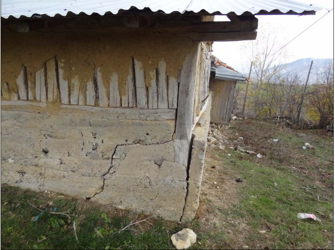
Şekil 4.36. Kıran Mahallesi'nde fay uzanımı üzerinde yerleşmiş binadaki olası krip hareketi ile ilişkili deformasyon.
