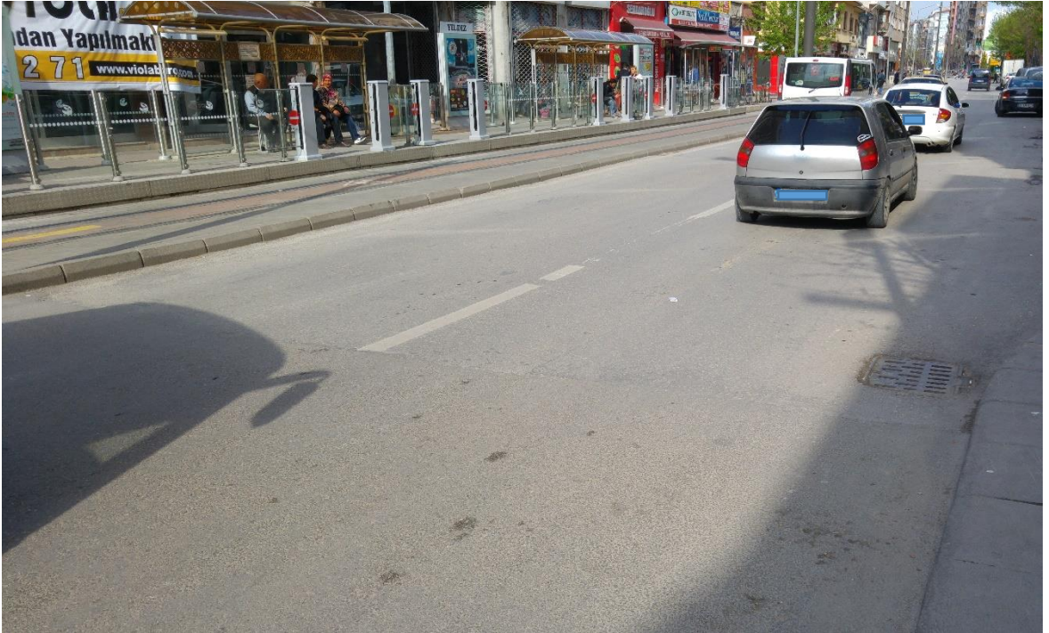
Şekil 3.28. Fiziksel beton bordür ayırıcı
