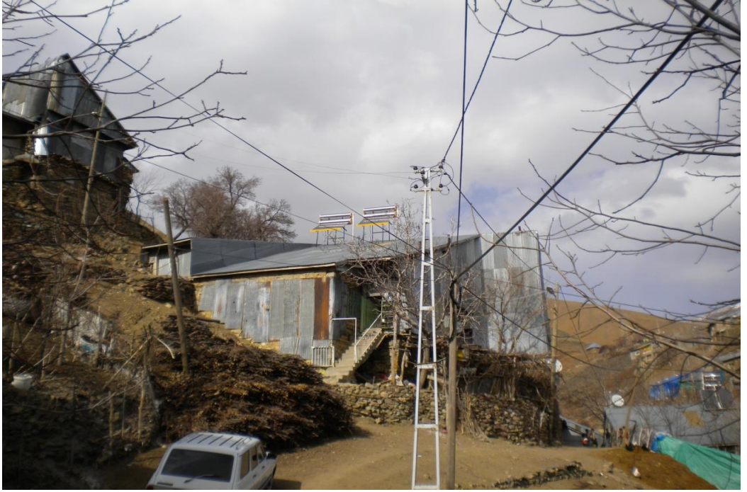
Fotoğraf 7. Sert Rüzgârlara Karşı Meskenlerini Korumaya Çalışan Köy Halkının Sacdan Duvar Kapama Önlemine Tarhana Köyünden Bir Örnek.
