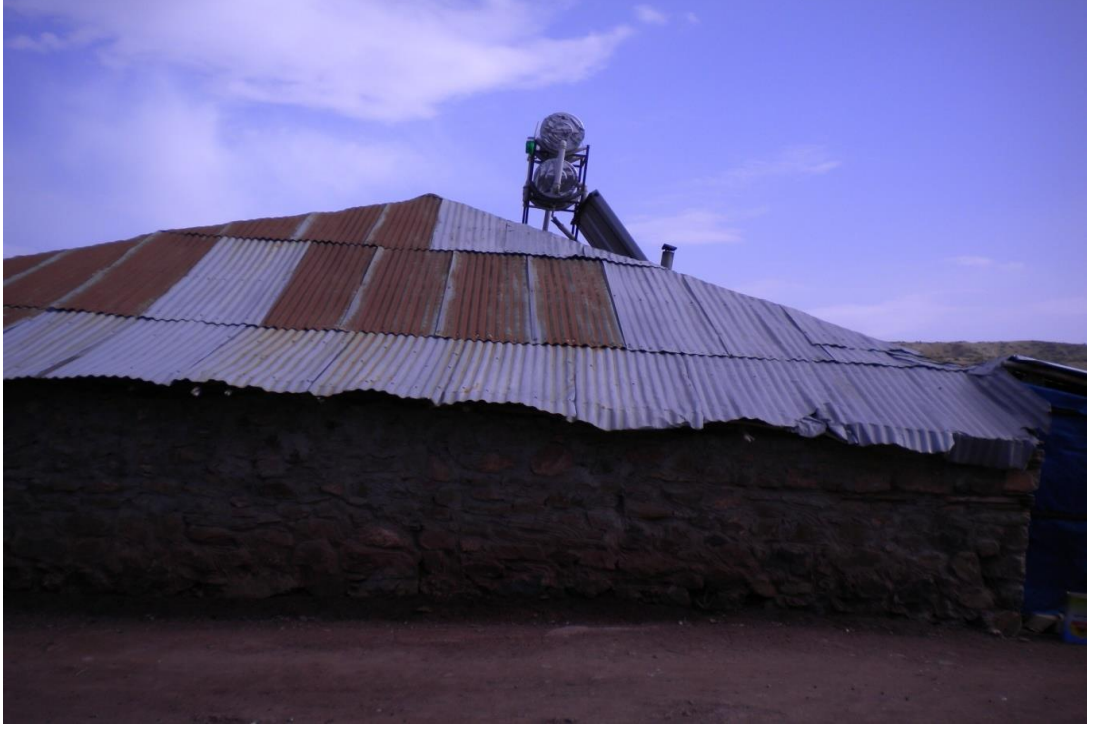
Fotoğraf 10. Caro Çayı Havzasında Sac Malzeme Kullanılarak Yapılan Çadır Örtü Çatı Örneği ( Kasil Köyü.)
