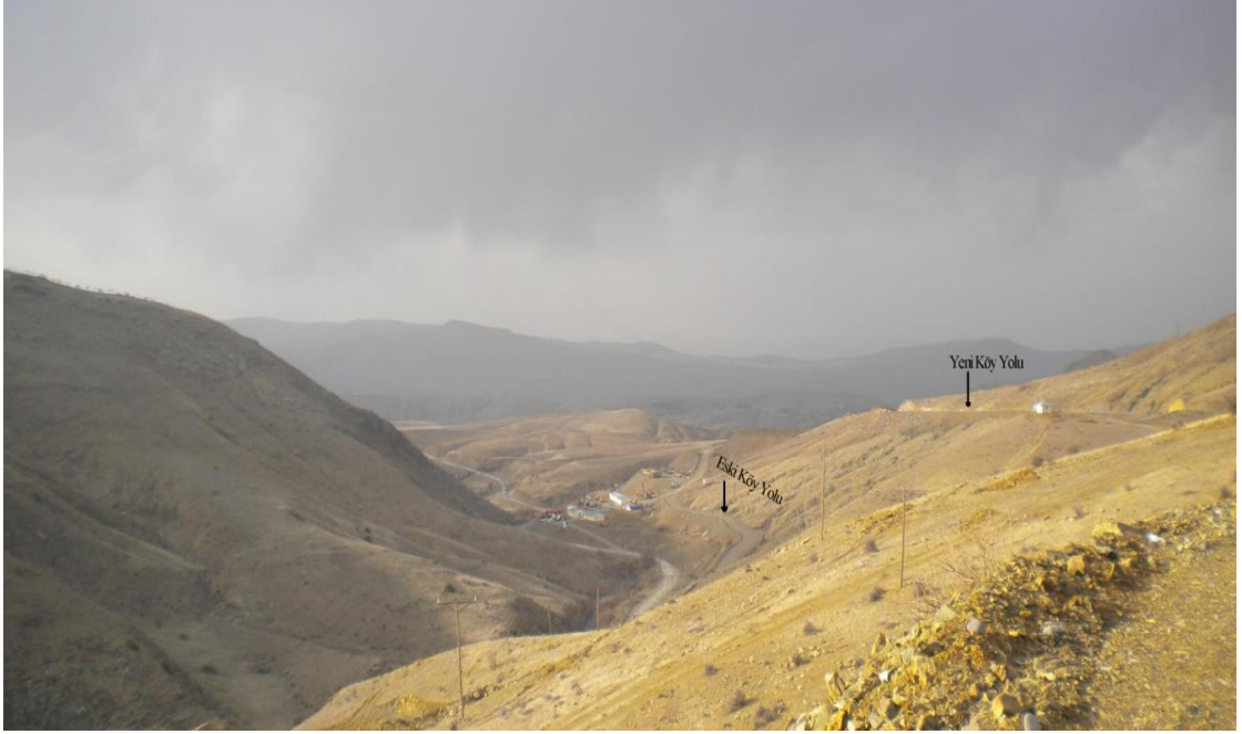
Fotoğraf 17. Baraj Yapımı Nedeniyle Güzergâhı Değişen Tarhana Köyü yolu
