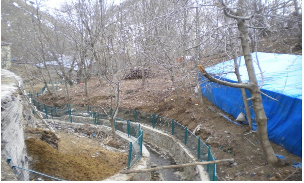
Fotoğraf 14. Erozyona Karşı Sulama Kanalını Korumak İçin Yapılan Demir Korkuluklar
