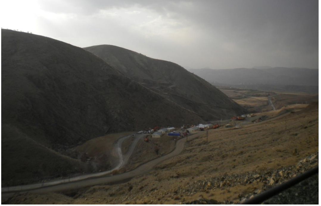
Fotoğraf 18. Hamzabey Barajı Şantiye Alanı
