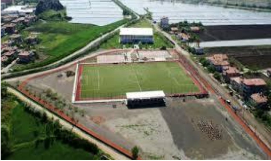
Foto 24: Osmancık Belediyesi Tarafından Yapıtılan Halı Saha (2015)
