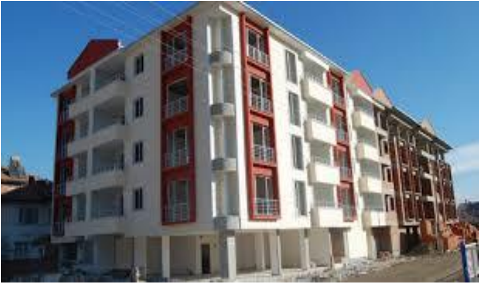
Foto 17: Gemici Mahallesinde Yapımı Süren Modern Binalar.
