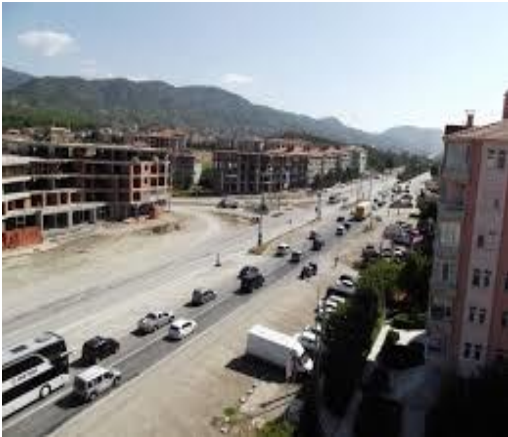
Foto 42: D-100 Karayolunun Doğu Girişinden Bir Görünüm (2014)
