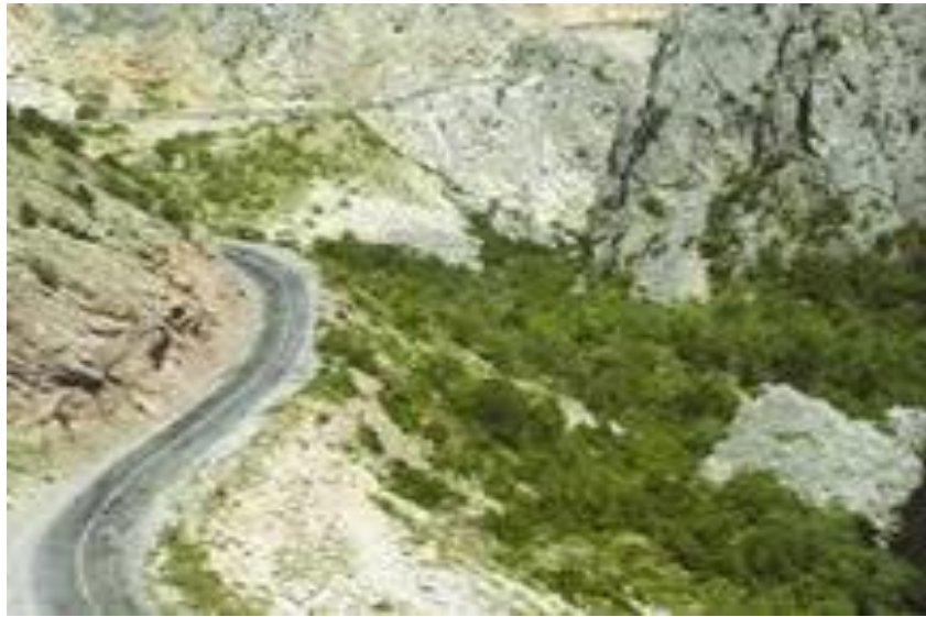
Foto 44: E-80 Karayolunun Yenilenmeden Önceki Görünümü
