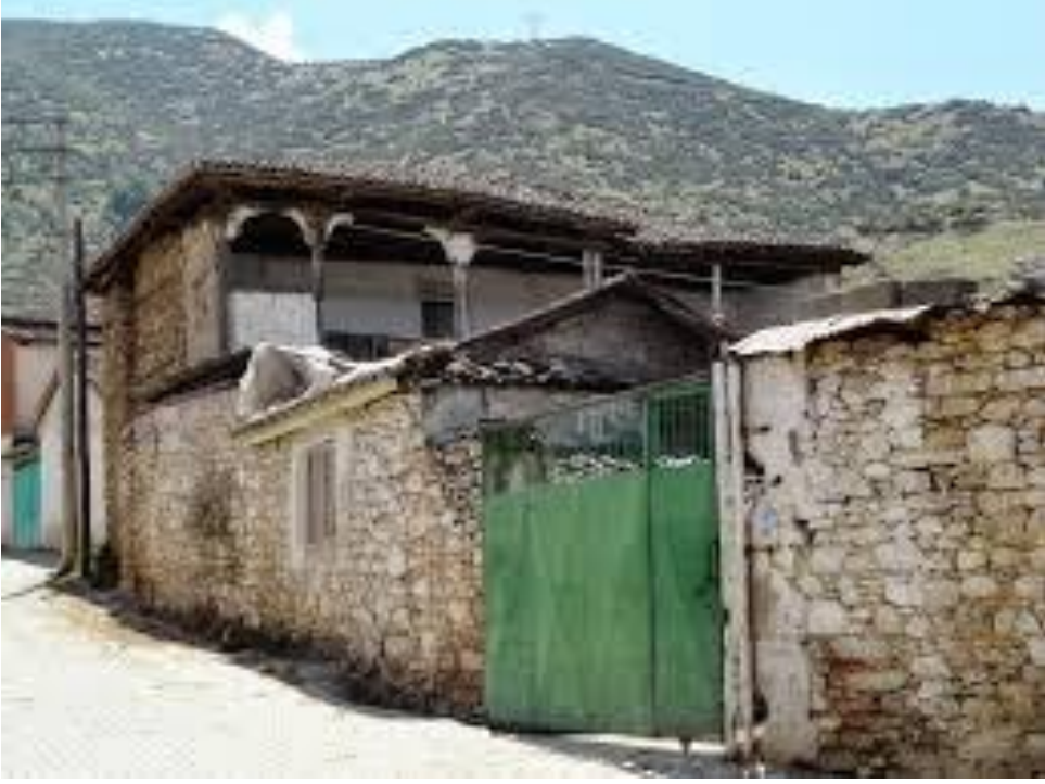
Foto 16: Osmancık'ta Kerpiç Bir Ev. (Yazı Mahallesi)
