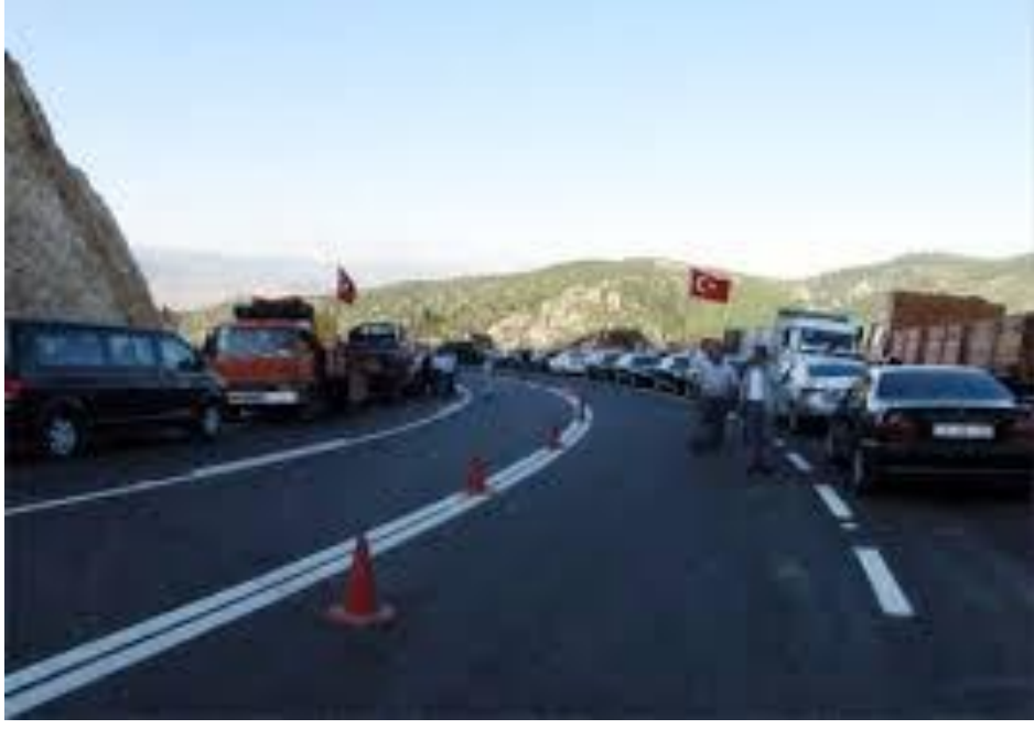
Foto 45: E -80 Karayolunun Yenilenmiş Görünümü (2014)
