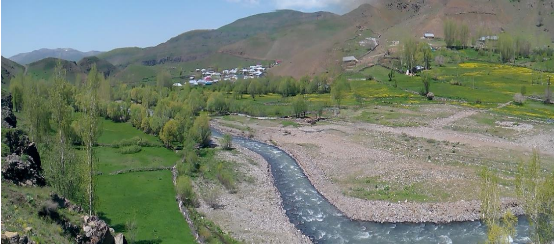
Foto 14. Esence deresi havzası yukarısında bulunan hazarşah taşkın yatağı
