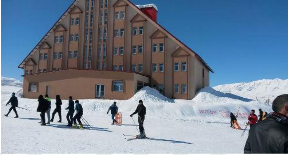
Foto 41: Yapımı Devam Eden Ovacık Kayak Tesisi( http://tunceli.gsb.gov.tr/HaberDetaylari/1/55047/kayak-tesisimiz-hizmete-gecmistir.aspx.27.01.2016 )
