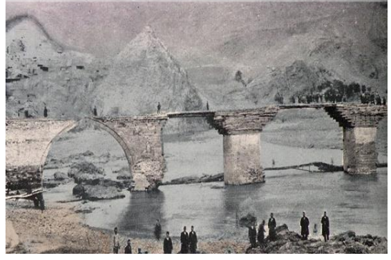
Foto 17: Palu Köprüsünün Eski Hali
