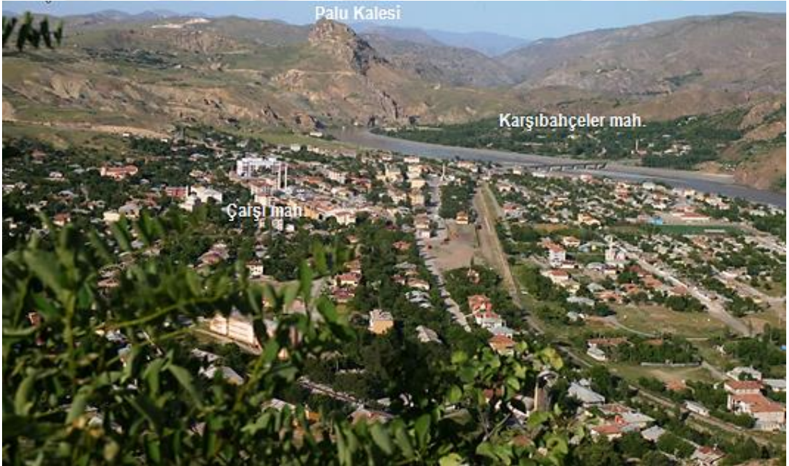
Foto 9: Günümüz Palu Yerleşmesinden Bir Görünüm (Batıdan)
