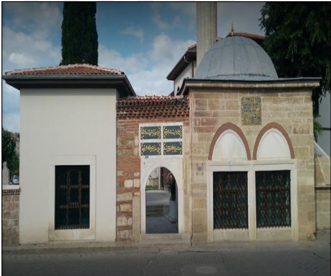
Fotoğraf 98: Hasan Sezaî Tekkesi'nin Batı Cephesi (2017)
