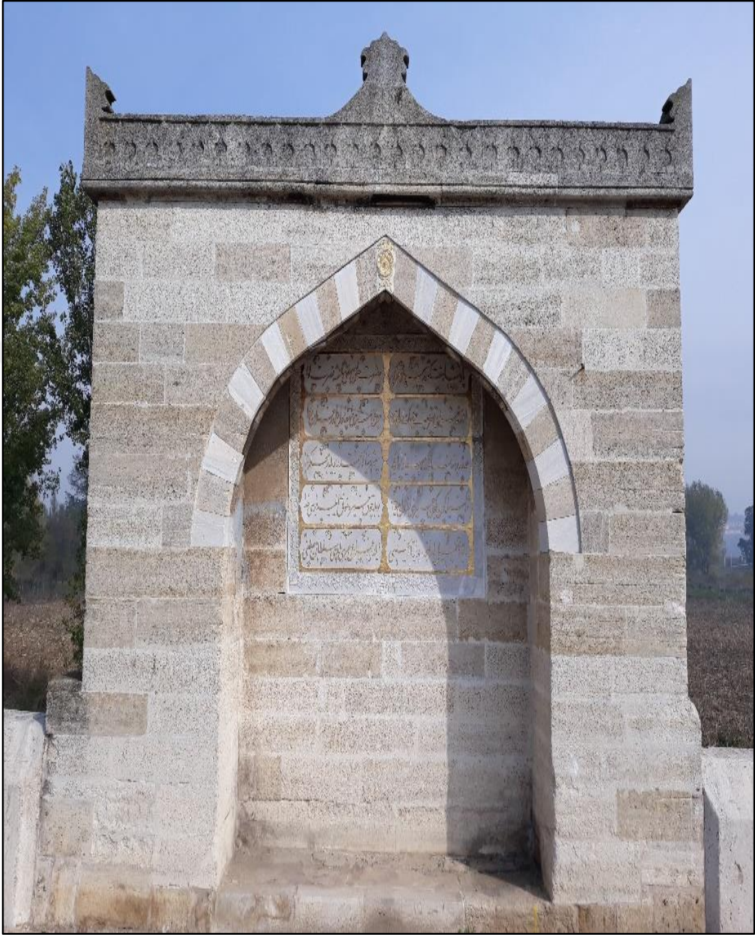
Fotoğraf 132: Saraçhane Köprüsü'nün Balkonu (2017)
