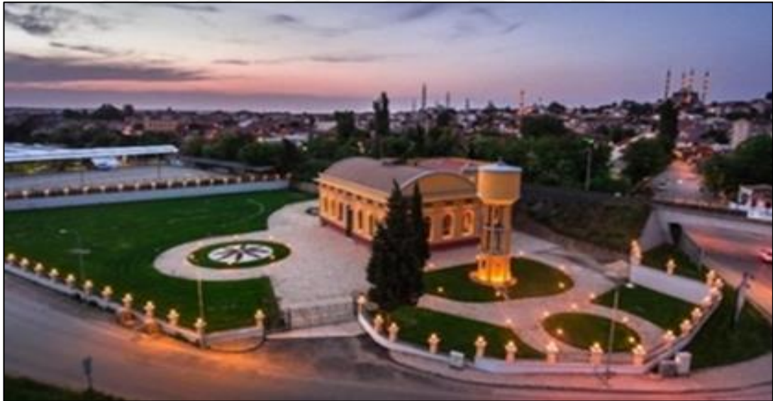
Fotoğraf 106: Elektrik Fabrikasının Yerine Yapılan Kültür Merkezi Ve Nikah Salonu 898
