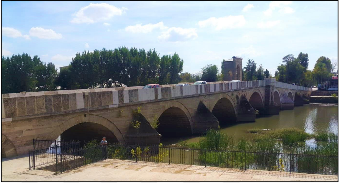
Fotoğraf 141: Ekmekçizâde Ahmed Paşa Köprüsü'nün Genel Görünümü (2018)
