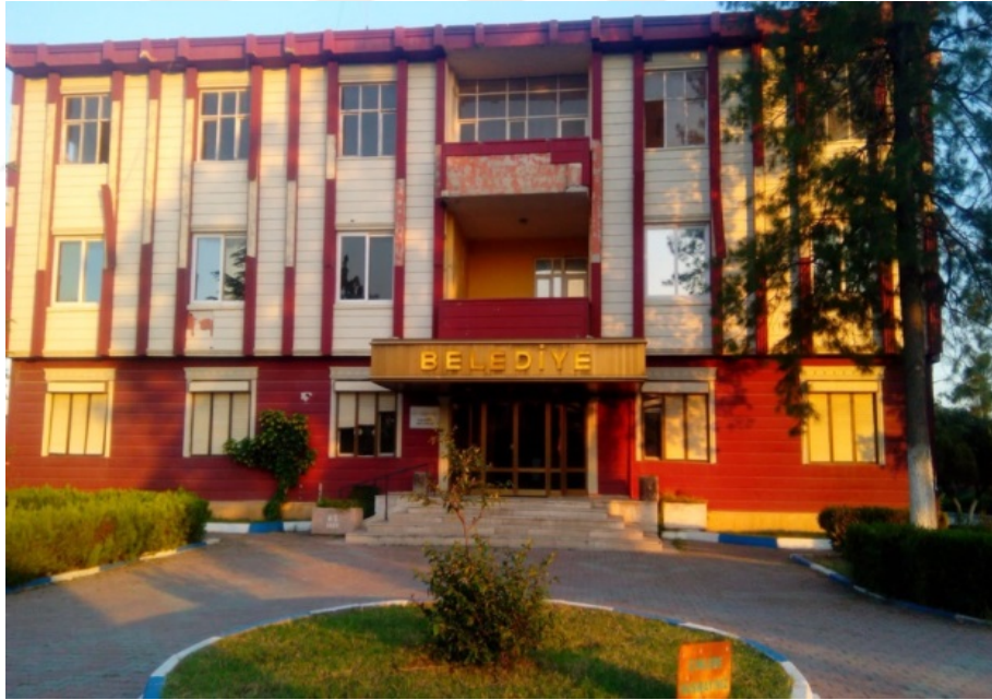
Foto 7. Huzurkent Eski Belediye Binası
