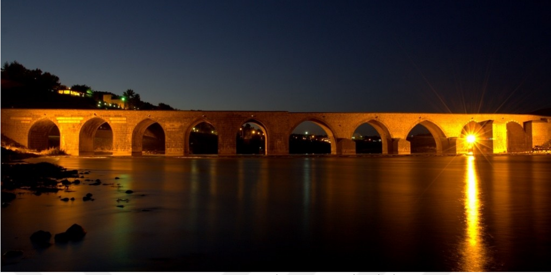
Resim 6. On Gözlu Köprü, Diyarbakir
