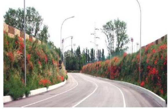
Şekil 2.15. Destekli toprak dolgu duvar çekirdekli bitki bariyeri (CEDR, 2017)
