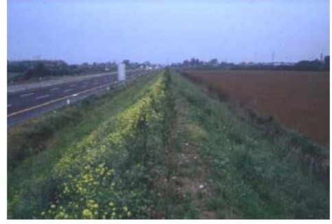
Şekil 2.14. Doğal toprak dolgu duvar çekirdekli bitki bariyeri (CEDR, 2017)
