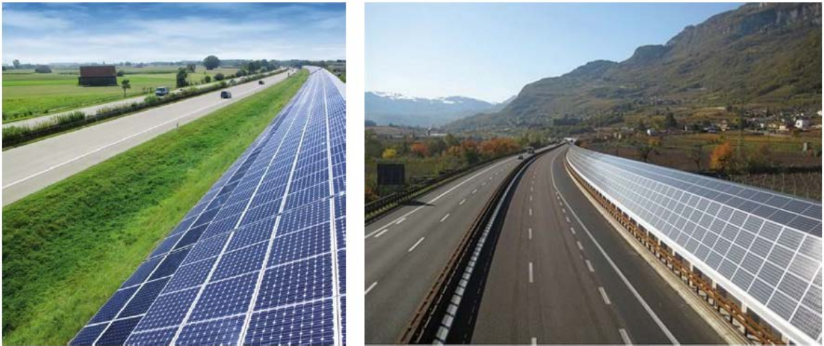
Şekil 2.28. Güneş enerjisi paneli kaplı gürültü perdesi (CEDR, 2017)
