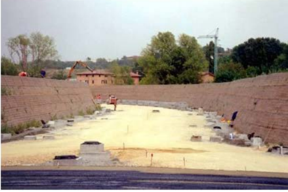
Şekil 2.15. Destekli toprak dolgu duvar çekirdekli bitki bariyeri (CEDR, 2017)
