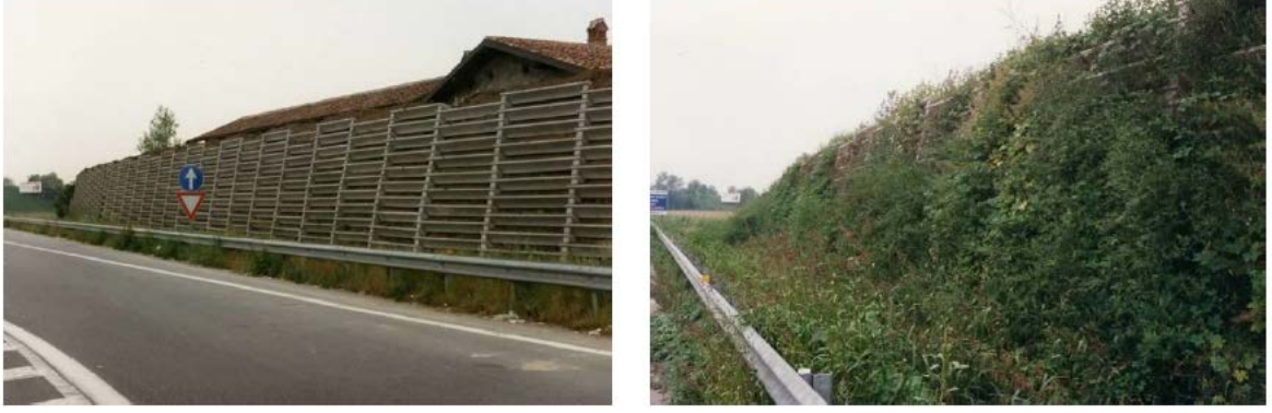
Şekil 2.18. Beton iskeletli bitki bariyeri (CEDR, 2017)
