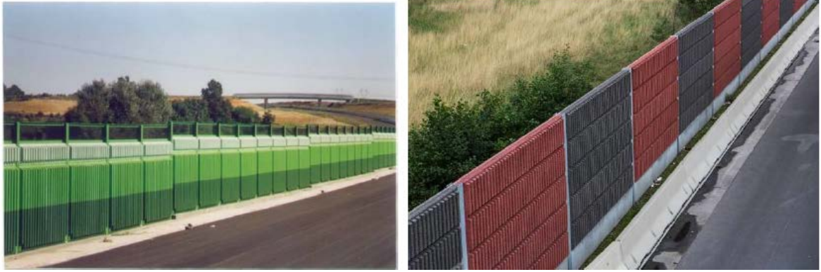
Şekil 2.30. Beton gürültü perdesi (CEDR, 2017)
