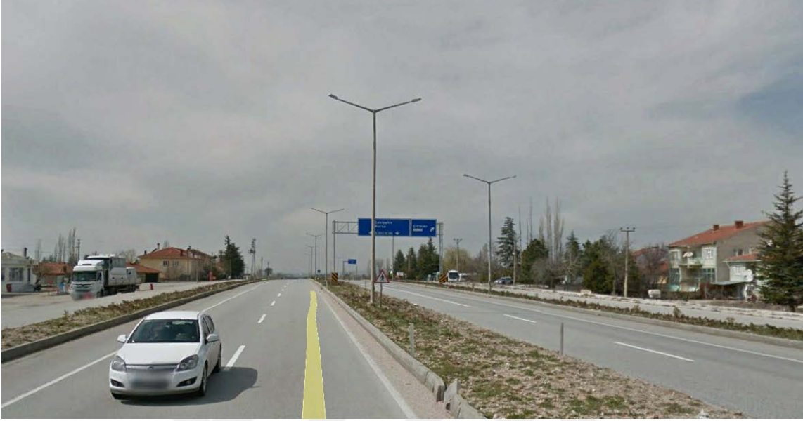
Şekil 4.4. D200 karayolu ve Kaymaz Mahallesi'ndeki yola yakın konutlar
