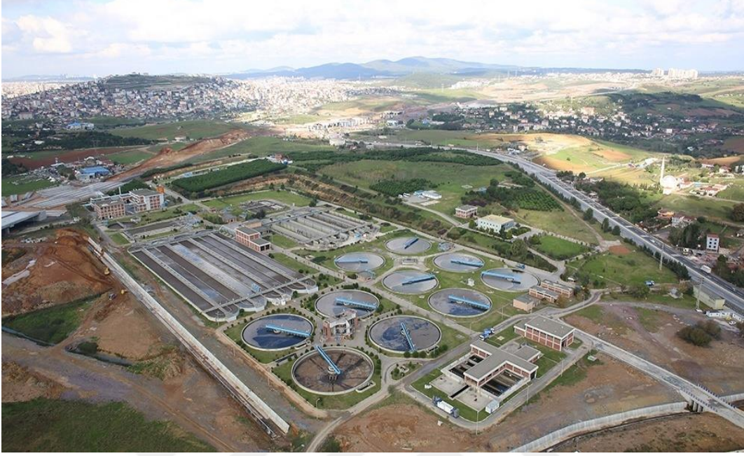
Şekil 2.5. Paşaköy İleri Biyolojik Atıksu Arıtma Tesisi'nin üstten görünüşü
