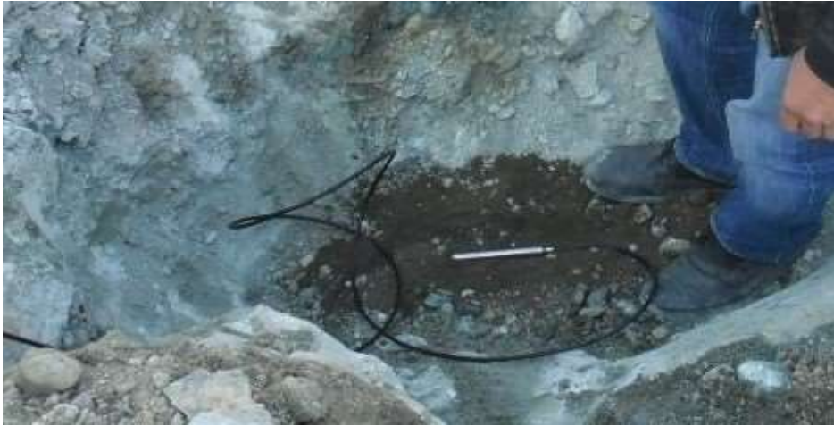
Şekil 1.14. Temel tipi piyezometre
