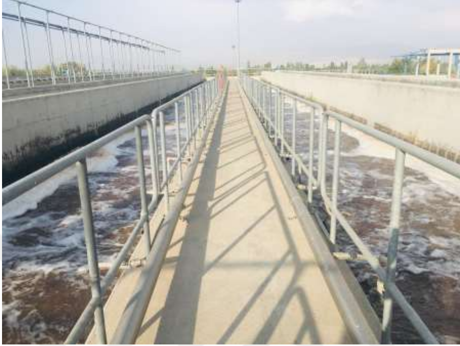
Şekil 3.5. Havalandırmalı Kum ve Yağ tutucu Havuz (MASKİ, 2019)
