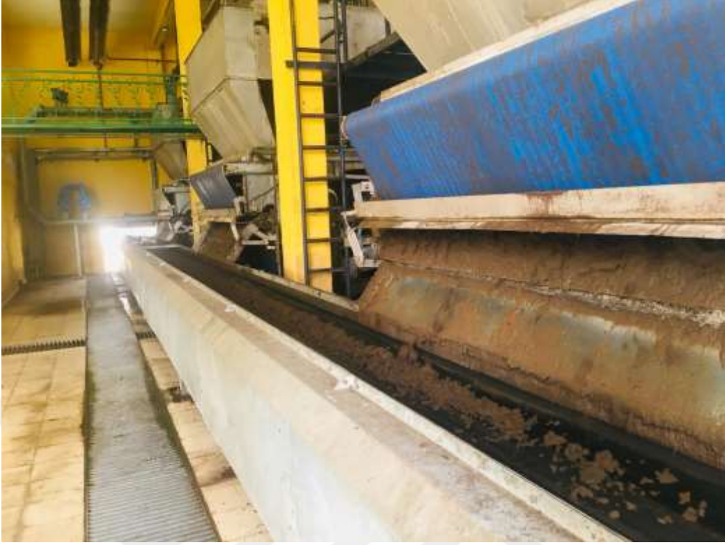
Şekil 3.9. Belt Pres Ünitesi (MASKİ, 2019)
