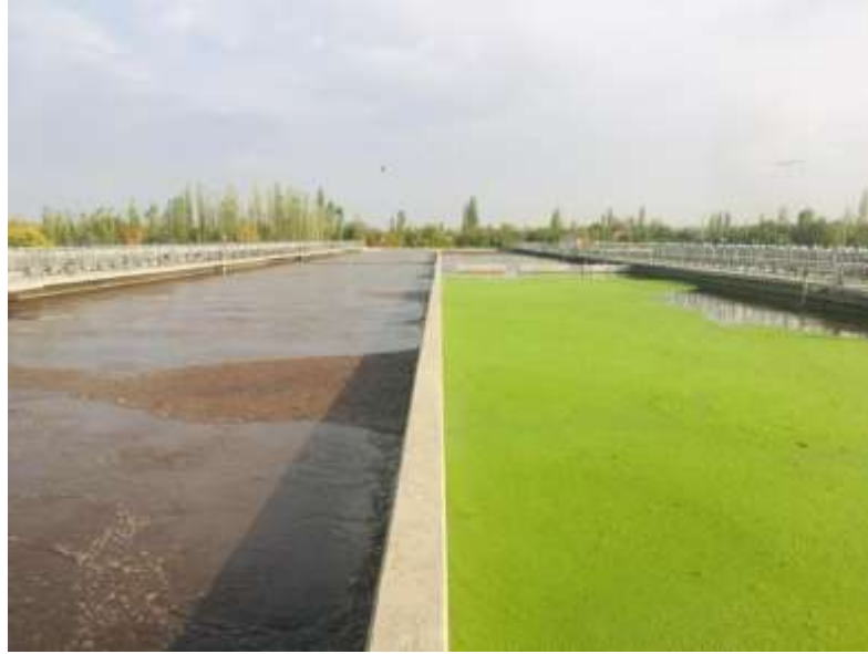
Şekil 3.7. Havalandırma Havuzu (MASKİ, 2019)
