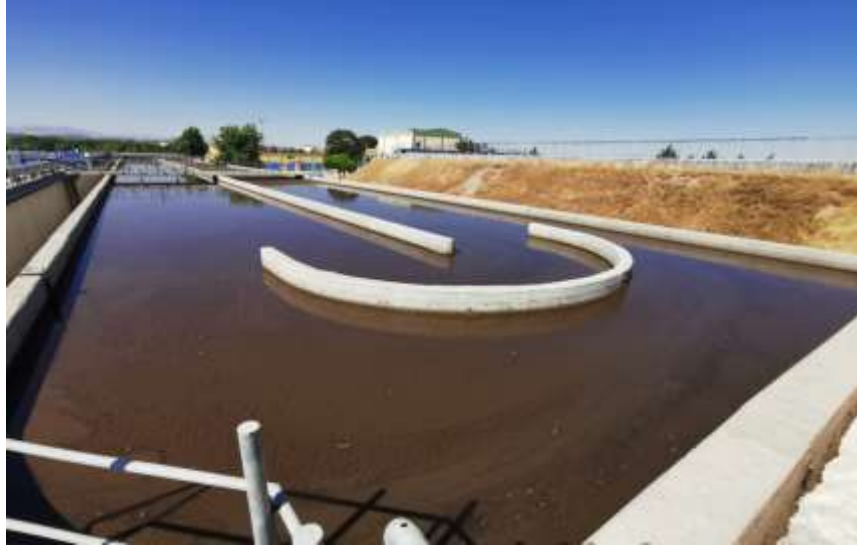
Şekil 3.6. Biyolojik Fosfor Giderim Havuzu (MASKİ, 2019)
