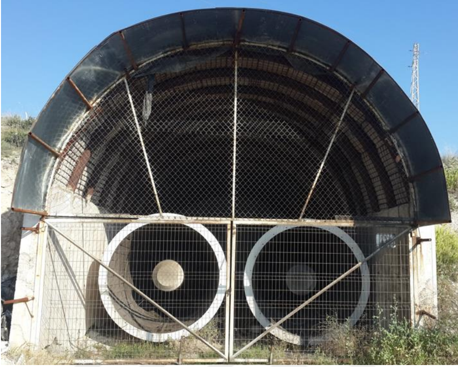
Şekil 5.4. Paralel çalışmakta olan iki emici vantilatör.
