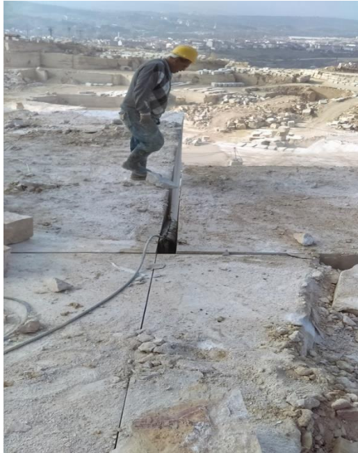
Şekil 5.16. Blok ayırma sacının takılması ve su ile şişirilmesi
