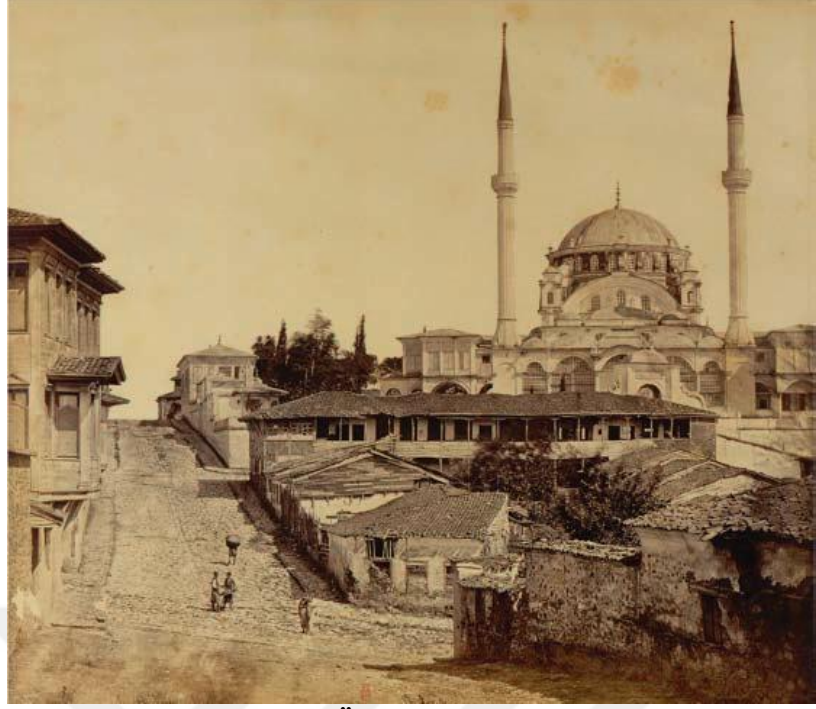
Şekil 123: James Robertson'un Üsküdar'daki Sultan Selim Cami Fotoğrafı (Bibliothèque Nationale de France, [31.01.2017])
