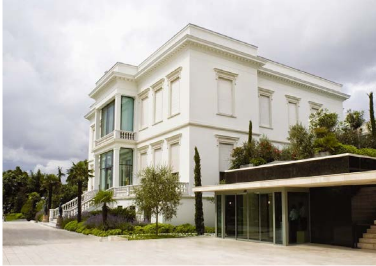
Şekil 52: Müze Ek Binası Yapı Örneği Sabancı Müzesi
