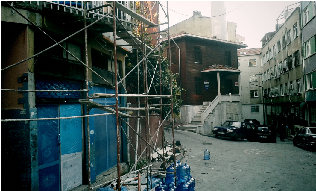
Abbildung 8: Der Renovationsprozess in Siraselviler (eigene Photographie)
