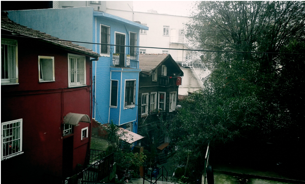
Abbildung 9: Der Renovationsprozess in Siraselviler (eigene Photographie)
