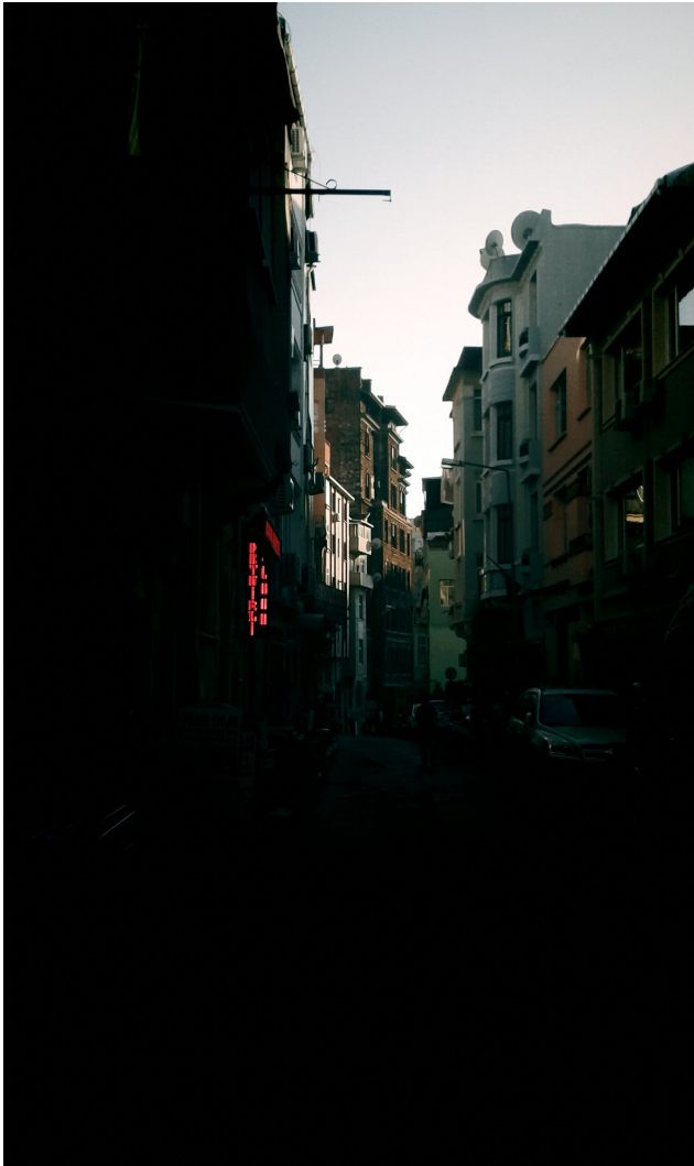
Abbildung 2: Eine Reihe von Wohnhäusern, die in Elmadağ renoviert werden (eigene Photographie)
