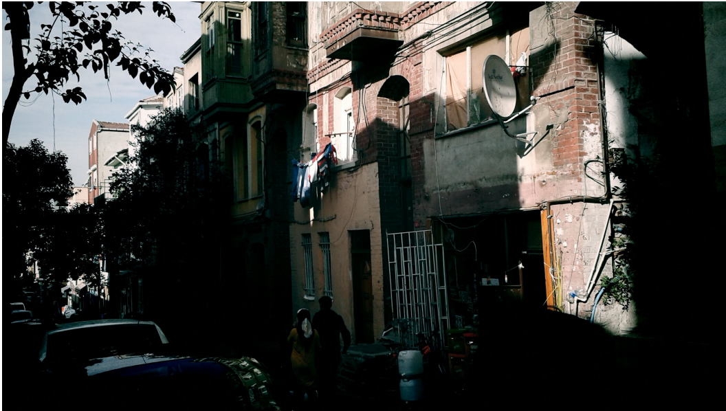
Abbildung 6: Freigelegtes Mauerwerk alter Strukturen einer reicher Bevölkerungsgruppen (eigene Photographie)
