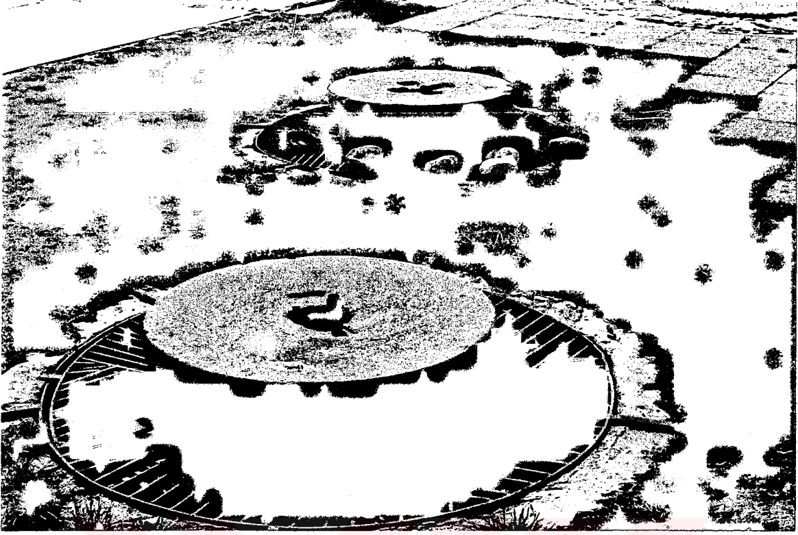
F 36 : Çim alanda demir ızgaralar üzerine oturtulmuş daire formu beton su gösteri elemanları
