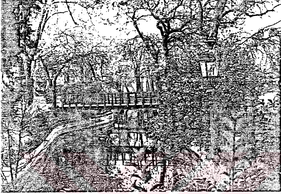
F 7 ; Hamit havuzu üzerinde yer alan Çelik konstrüksiyon üzerine oturmuş açılabilir, köprünün görünümü.
