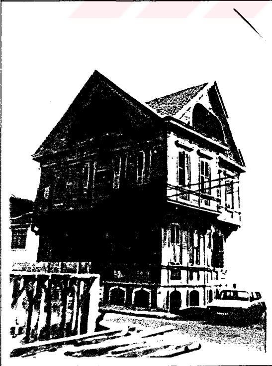
Resim No: 16 12 Eylül Cad. No: 76 (5) Restorasyon öncesi durumu Bursa K.T.V.K.K. arşivi 1977
