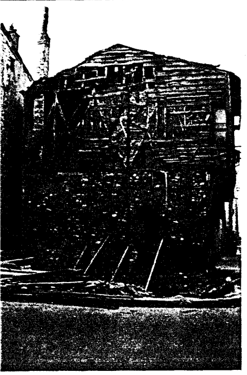
Resim No: 53 Cınarlı Kahve Sok.No: 10 (28) Geleneksel konutların yapım sistemi ahşap kar- kas arası zemin kat taş, üst kat kerpiç veya tuğla olduğunu gösteren bina yan cephesi.
