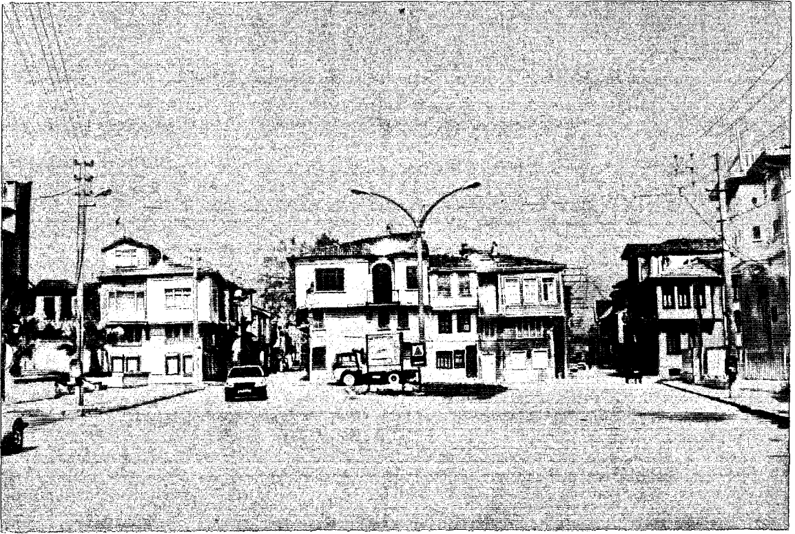
Resim No: 1 Giri Mahallesi girişi
