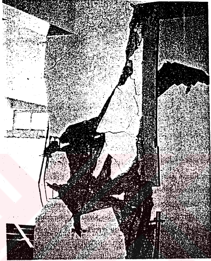
Şekil 2.47. Ara donatısı tutulmamış kolonlar [19]
