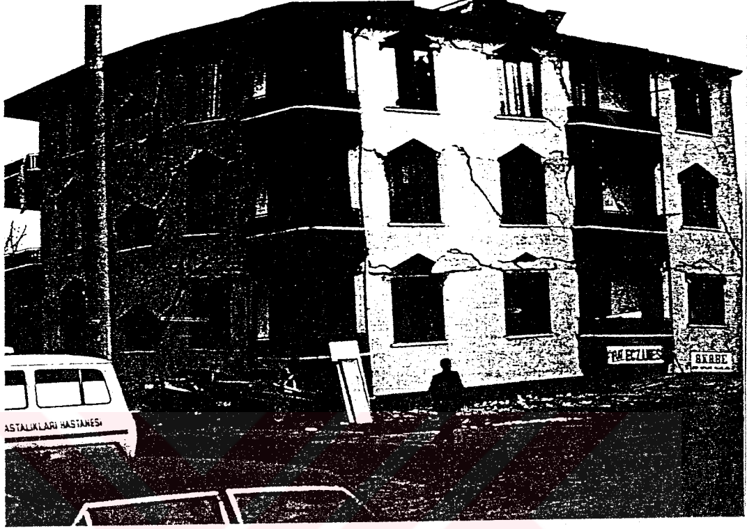
Şekil 2.3. 13 Mart 1992 Erzincan depreminde yumuşak kat oluşumu hasarı [4]
