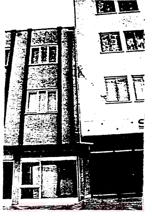
Şekil 2.14. Farklı yükseklikte bitişik binalarda çarpışma hasarı[19]
