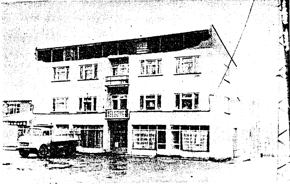
Şekil 2.59. 1983 Erzurum depreminde Narman Belediye Binası'nda dolgu duvar hasarı
