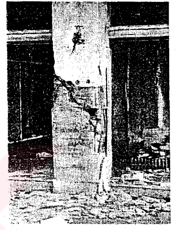
Şekil 2.44. Kolonda kesme kırılması hasarı [16]
