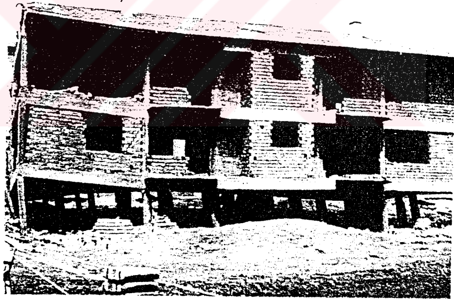
Şekil 2.5. Zemin kat kolonlarında mafsallaşma [19]
