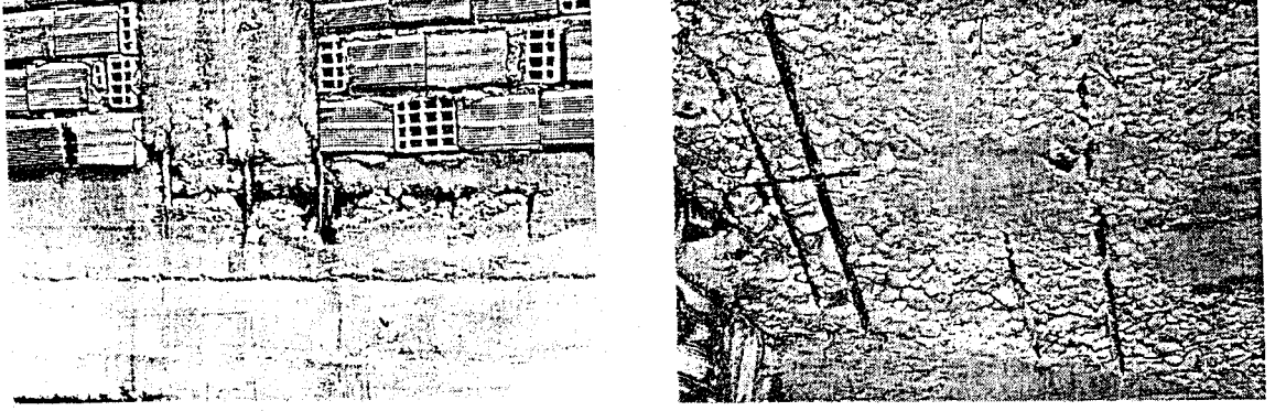
Şekil 3.49-50. 13 Mart 1992 Erzincan depreminde bir yapıda betondaki boşluk ve beton kalitesi [16]
