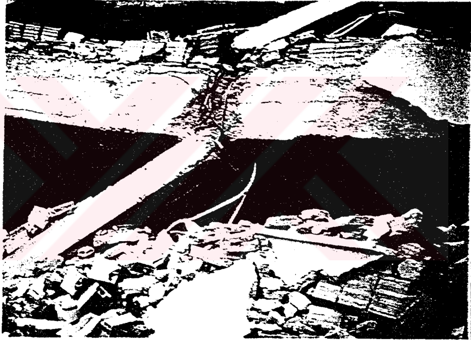
Şekil 2.6. Kuvvetli kiriş - zayıf kolon [19]
