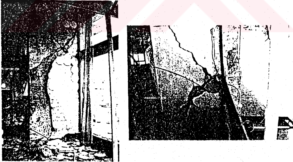
Şekil 2.40-41. Kolonlarda kesme kırılması hasarı [4]
