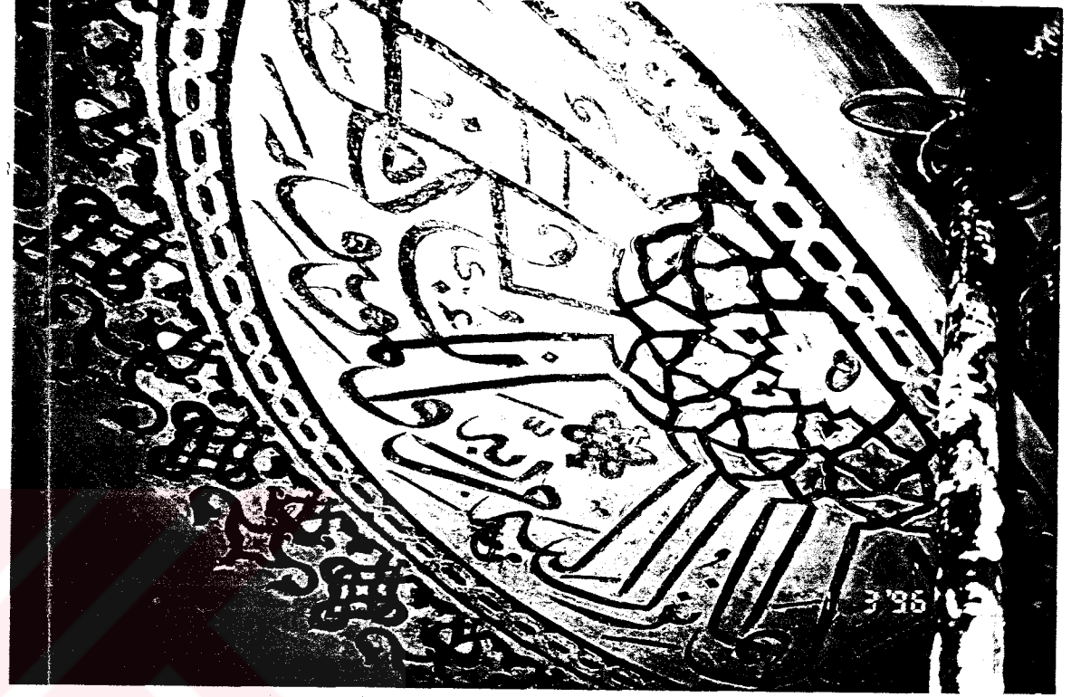
Resim 36- Çeyrek Kubbe Restorasyon Bulguları
