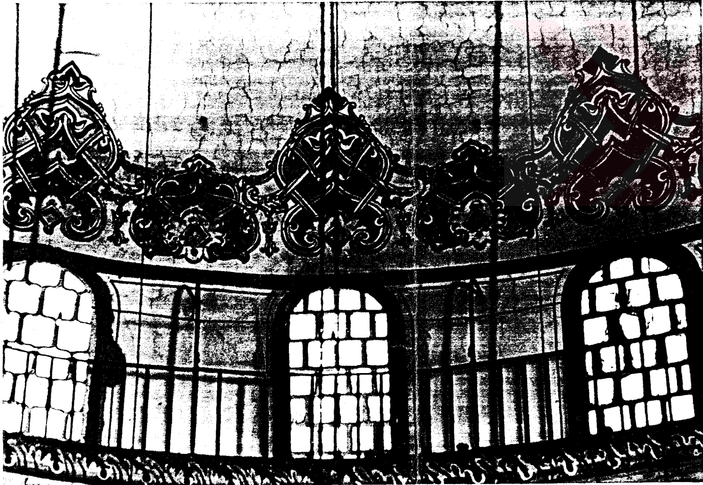
Resim 18- Ana kubbe Etek Detayları (Restorasyon öncesi)
