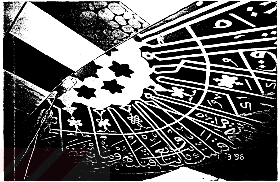
Resim 33- Yarım Kubbe Göbek Tığı Restorasyon öncesi
