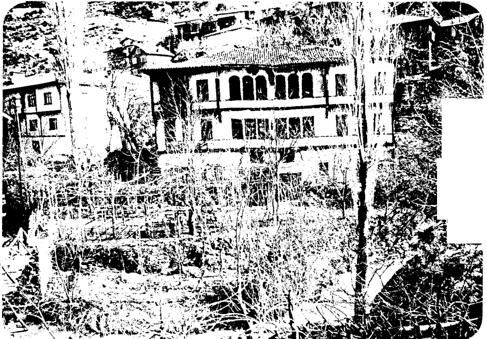
Foto. 195- Mümtaz Birsen Evi, dere cephesi (Env.126).
