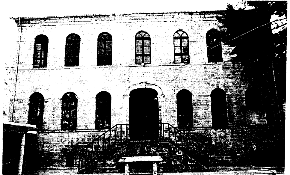
Foto. 135- Süleyman Paşa Camii, giriş cephesi, 1993.
