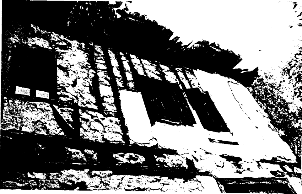
Foto. 278- Ahşap çatki arası taş dolgu, Ali Kaya Evi. Sağ köşedeki "maşallah" yazısı belirsizleşmiş.
