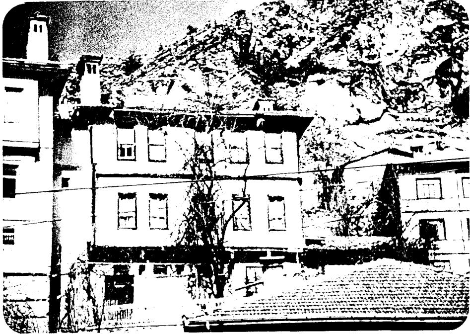
Foto. 177- Hacı Beyler Evi, dere cephesi
