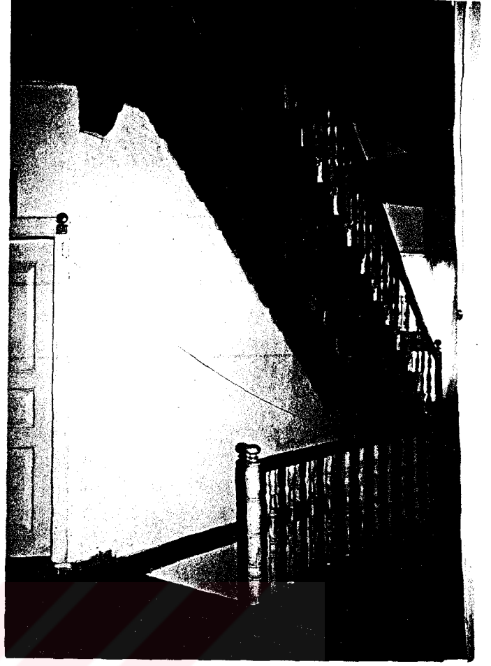
Foto. 248- Zekai Eke Evi, üst kat-çatı katı merdiv.
