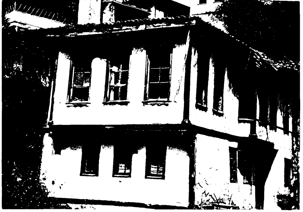
Foto. 180- Kavaklar Evi, dere cephesi ile arka cephe.
