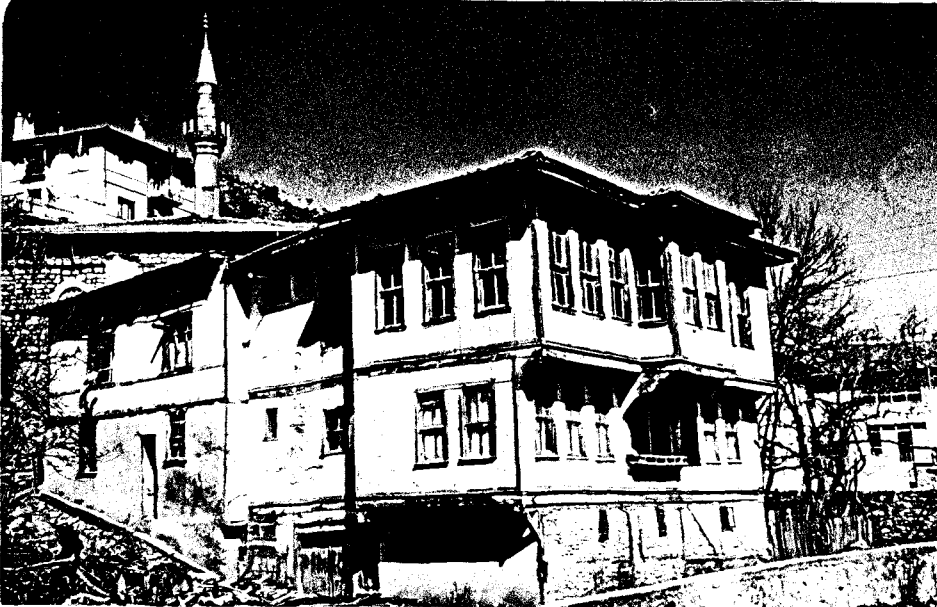
Foto. 61- Orhan Çalış Evi, giriş ve dere cepheleri, 1994 (Onarım öncesi).
