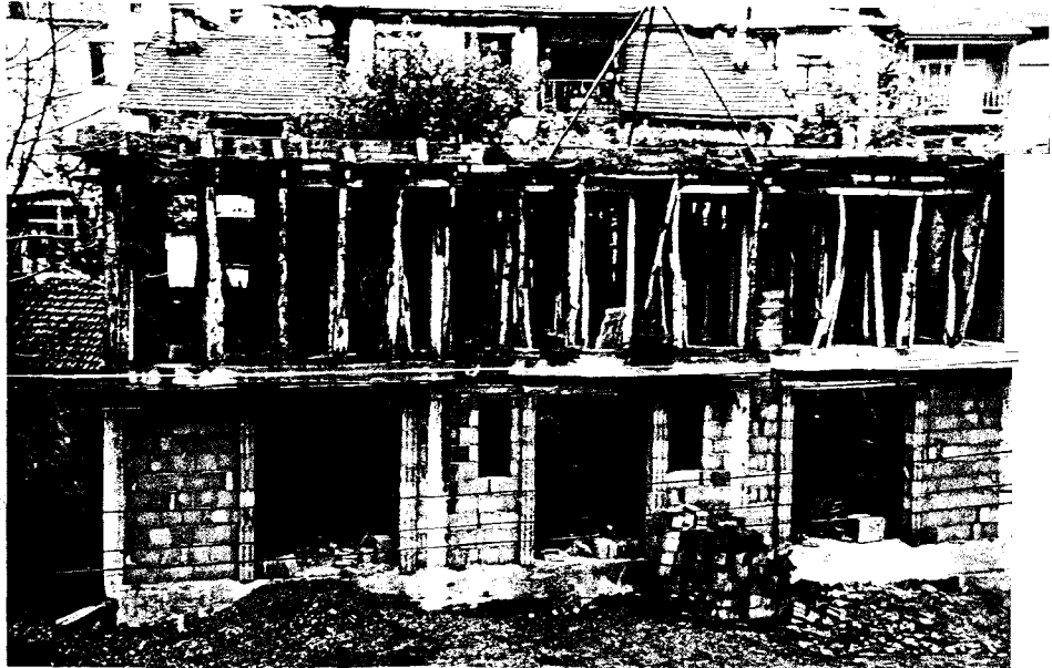
Foto. 316- Tescilli yapıya yapılan restorasyon uygulaması.
