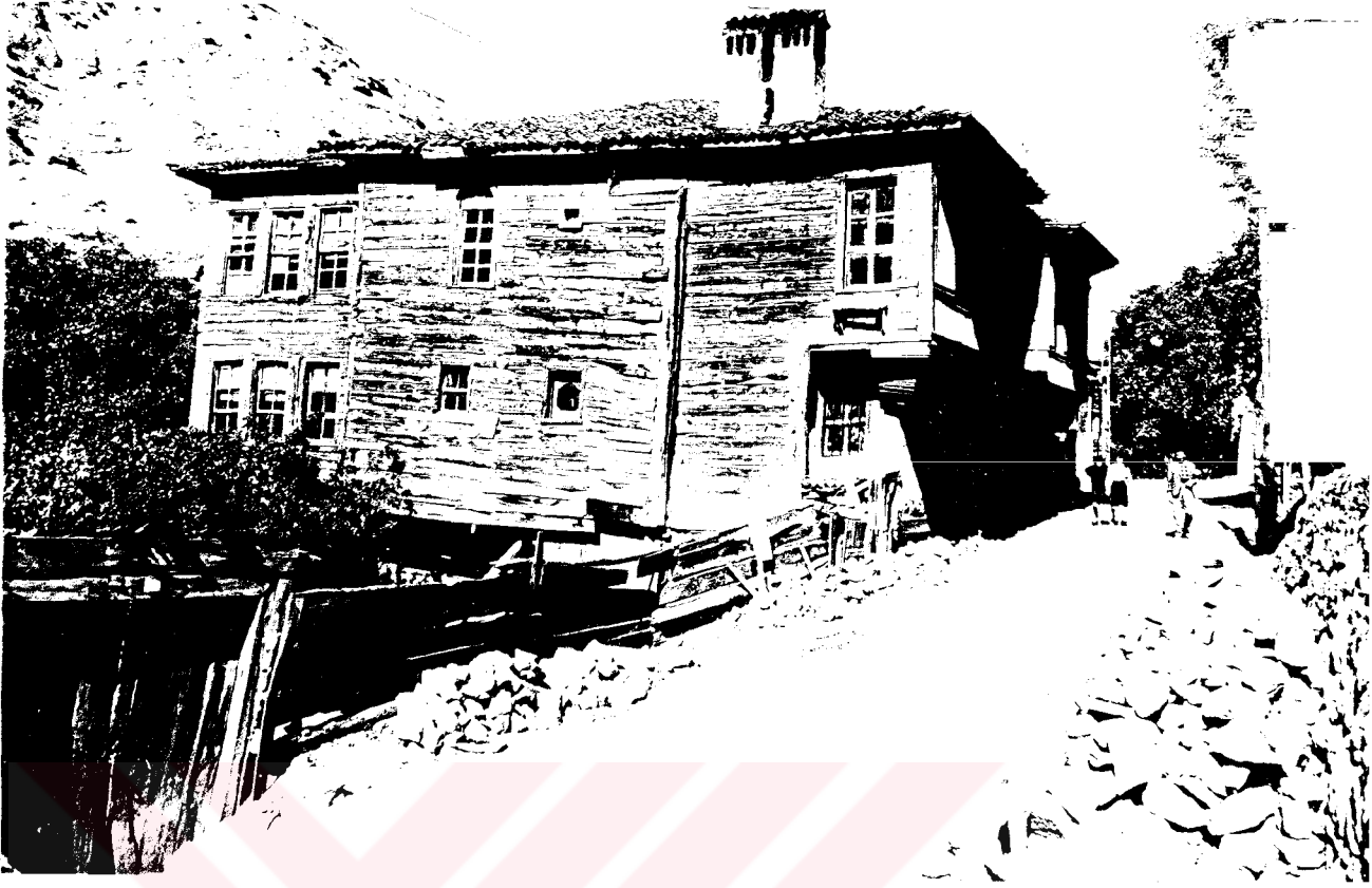
Foto. 301- Beybahçesi Caddesi'nde bulunan ve "korunması gerekli kültür varlığı özelliklerini yitirdiği" gerekçesiyle tescil kaydı kaldırılan yapının 1967 yılındaki görünümü. (Env. No. E.40) (ODTÜ).
