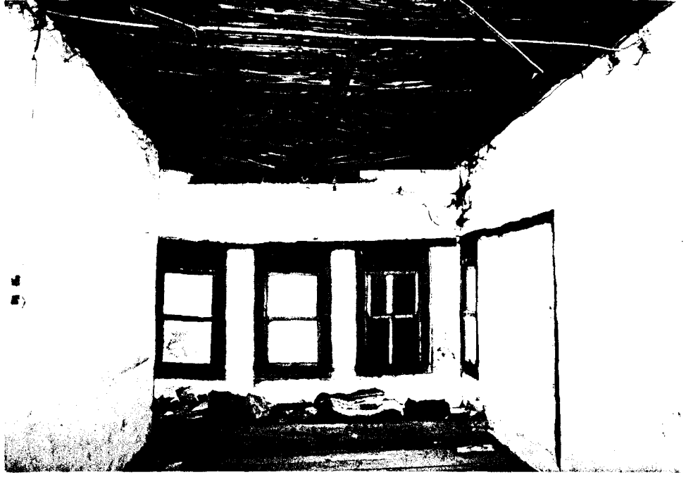
Foto. 214- Ali Kaya Evi, çardak -sofa- görünüşü.
