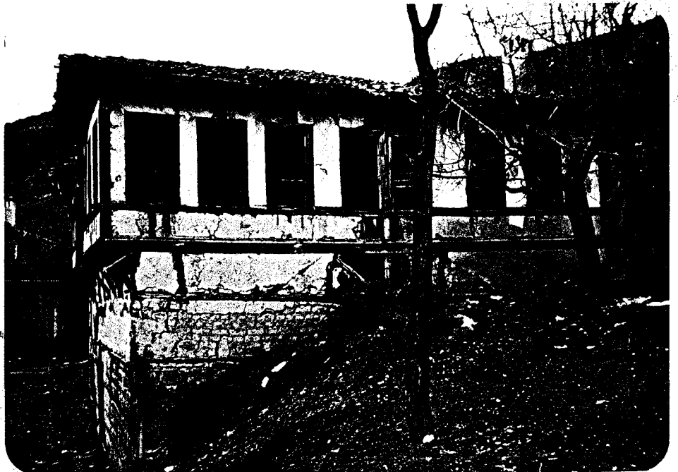
Foto. 182- Kasımlar Evi, sağ yan (kuzeydoğu) cephe.
