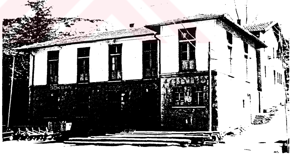
Foto. 322- Tescilli olmayan yapılardan biri, GÖKSAN Binası, onarım öncesi.
