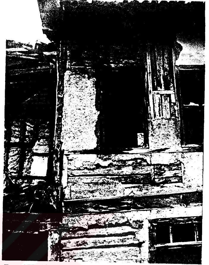
Foto. 277- Ahşap çatki, ahşap ve kerpiç dolgulu
