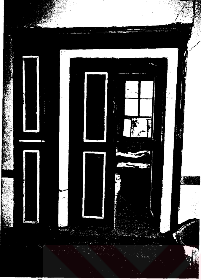
Foto. 254- Kavaklar Evi, yazlık oda kapısı.
