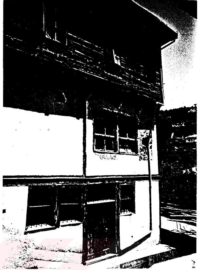
Foto. 184- Geredeliler Evi, sokak cephesi.
