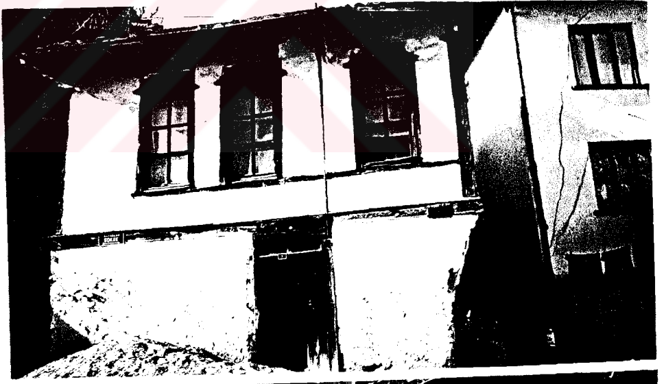
Foto. 312- 89 Env. No.'lu yapı- nın onarım öncesi durumu.
