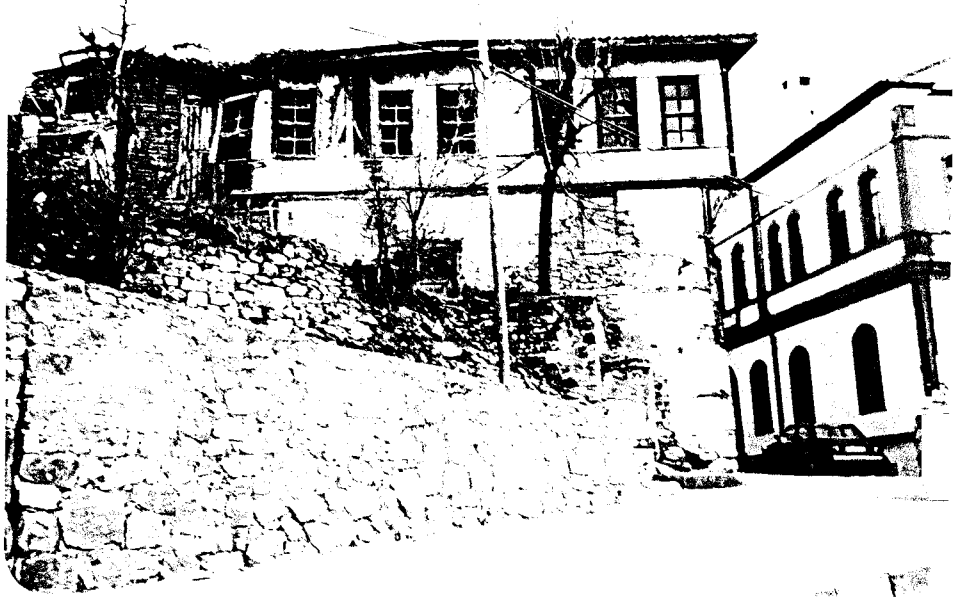
Foto. 317- 75 Env. No'lu Yapı, kuzey cephe, 1993.
