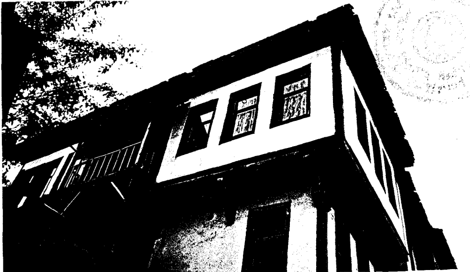
Foto. 176- Ş. Erdem Evi, dere cephesi ile güneybatı cephesi köşesi ve muhdes balkon.
