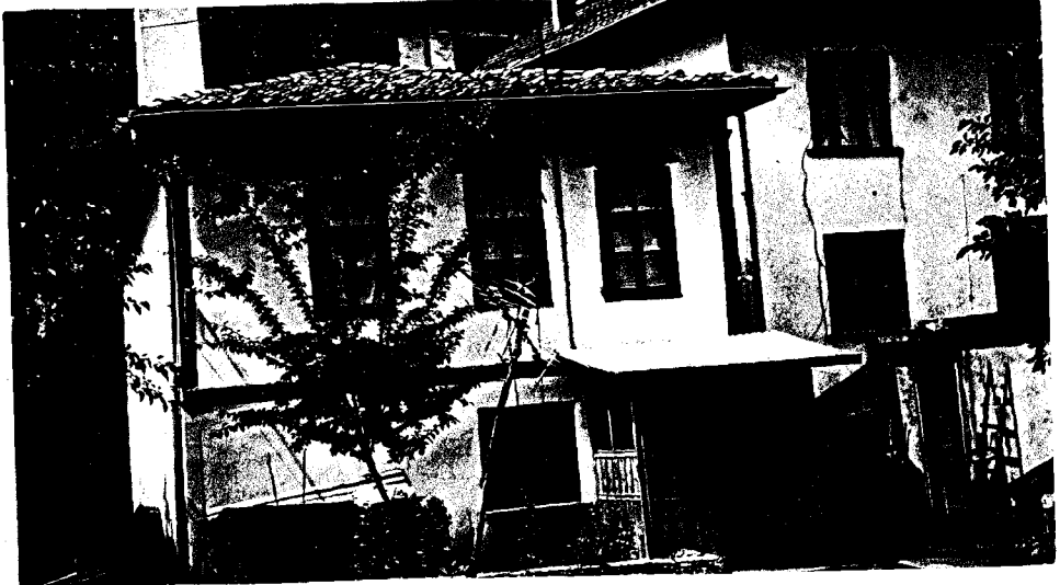
Foto. 313- 89 Env. No.'lu yapı- nın onarım sonrası durumu.
