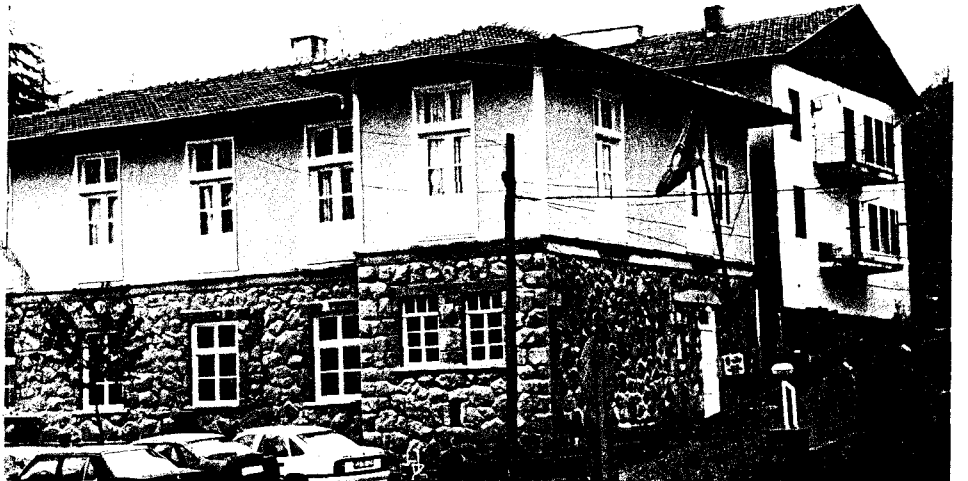
Foto. 323- Aynı binanın onarım sonrası (otel).
