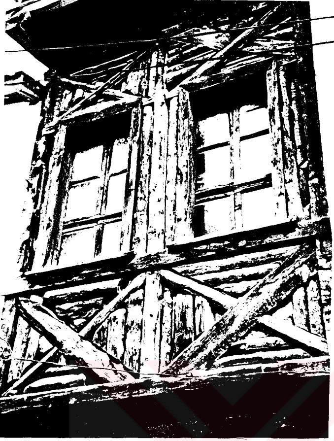
Foto. 276- Geleneksel yapılarda ahşap çatki düzeni, çatki arası ahşap dolgu. İsmail Derkan Dükkânı yanı.
