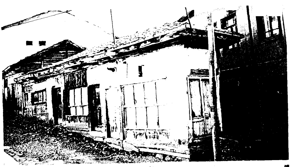
Foto .310- 84 Env. No.'lu yapı- nın onarım öncesi durumu.
