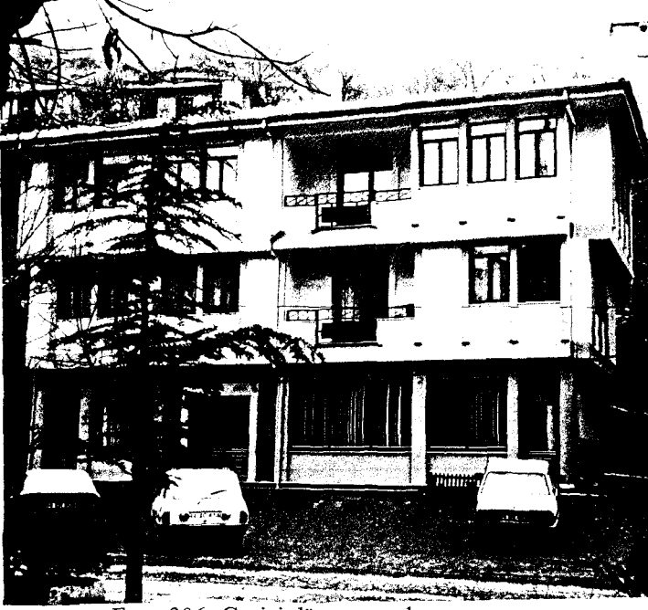
Foto. 306- Geçici dönem yapılanma şartlarının uygulandığı dönemde yapılmış yeni yapı.
