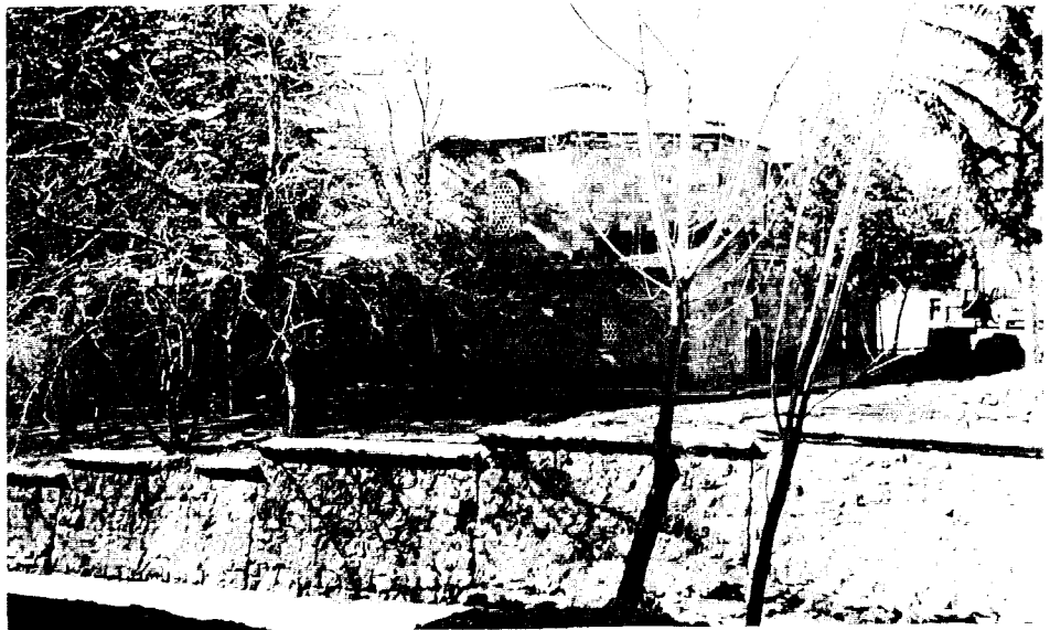
Foto. 148- Gazi Süleyman Paşa Hamamı, doğu cephesi, 1995.
