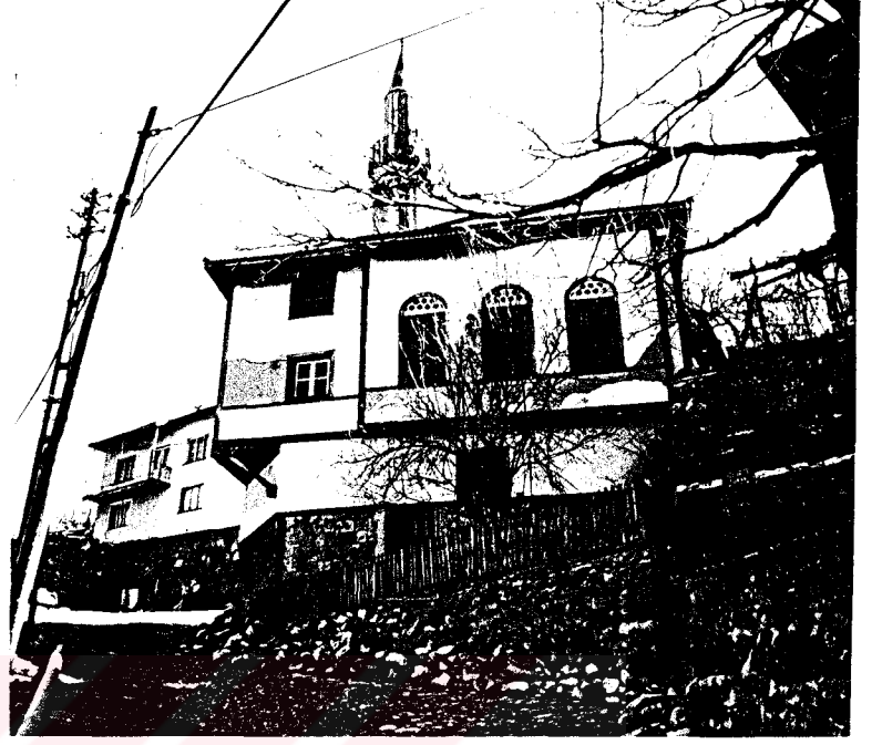
Foto 13- Hacı Apti Camii, batı cephesi, 1993.
