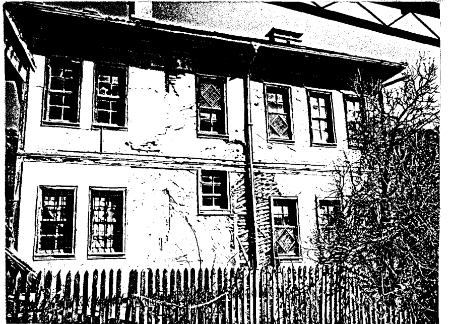
Foto.56- Varlık Evi, batı cephesi.
