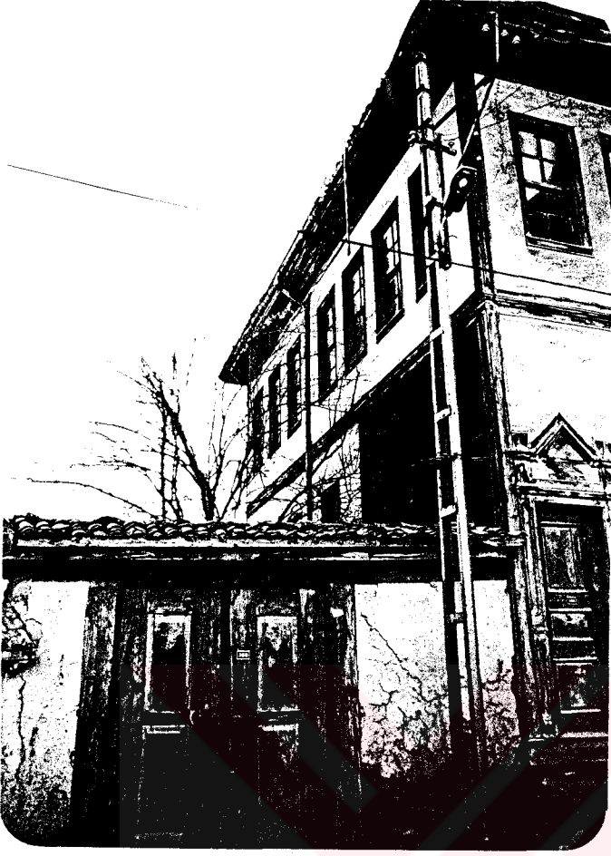
Foto. 190- Varlık Evi, cadde cephesi ile doğu cephesi köşesi, harem girişi.
