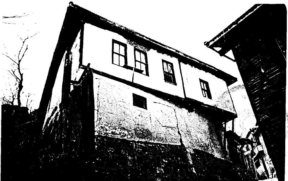
Foto. 285- Tescil edilmemiş konutlardan biri, Deveyolu Sokak, No.15.
