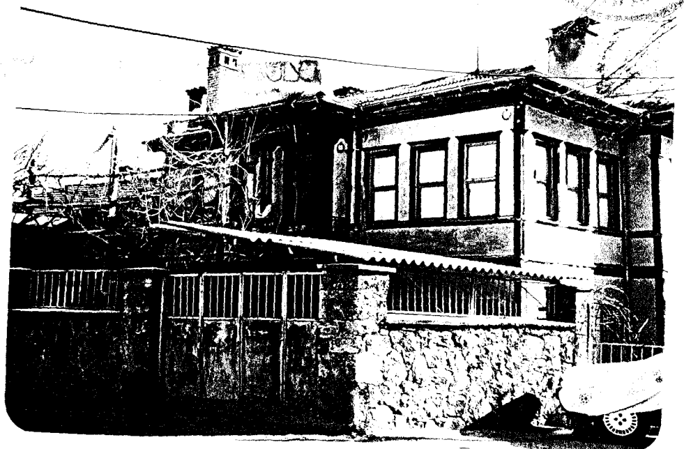
Foto. 201- Yağcılar Evi, cadde cephesi (Env.69).
