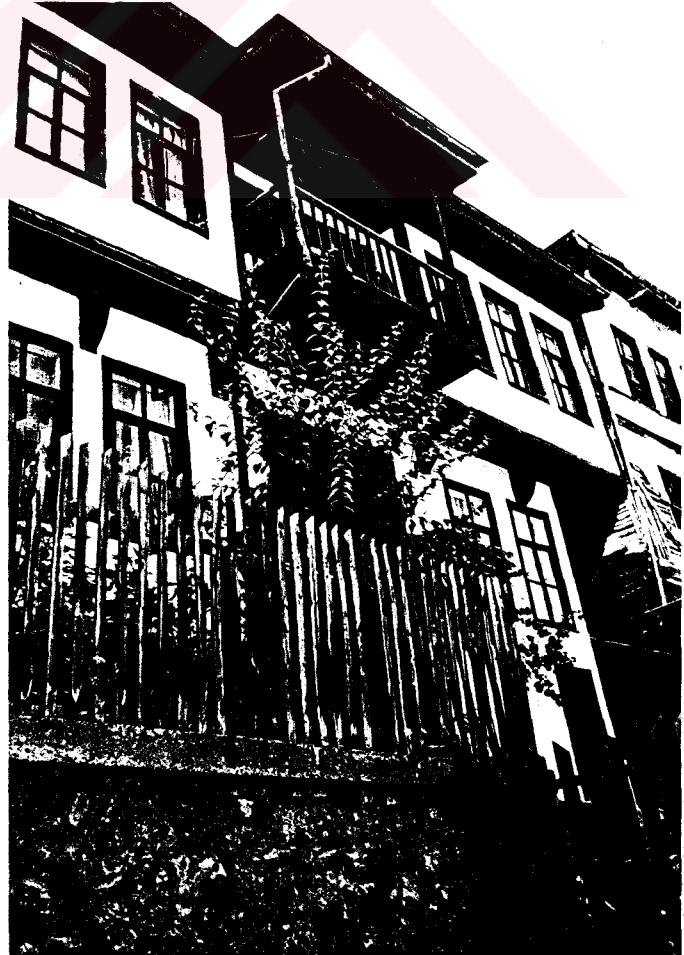
Foto. 67- Öğretmen Osman Bey Evi, manzara cephesi.
