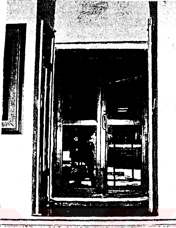
Resim 4. 70 Özgün pencere kapaklarının korunduğu vezne odası penceresi iç görünüşü
