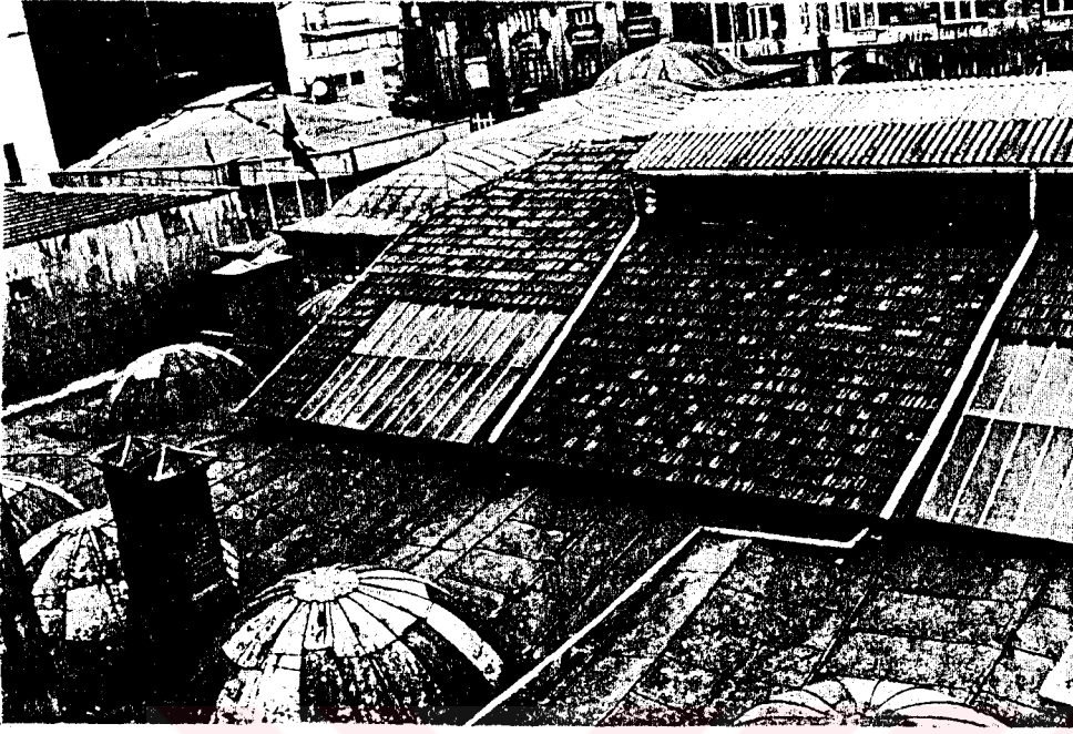
Resim 4. 58 Eklenti çatı görünüşü
