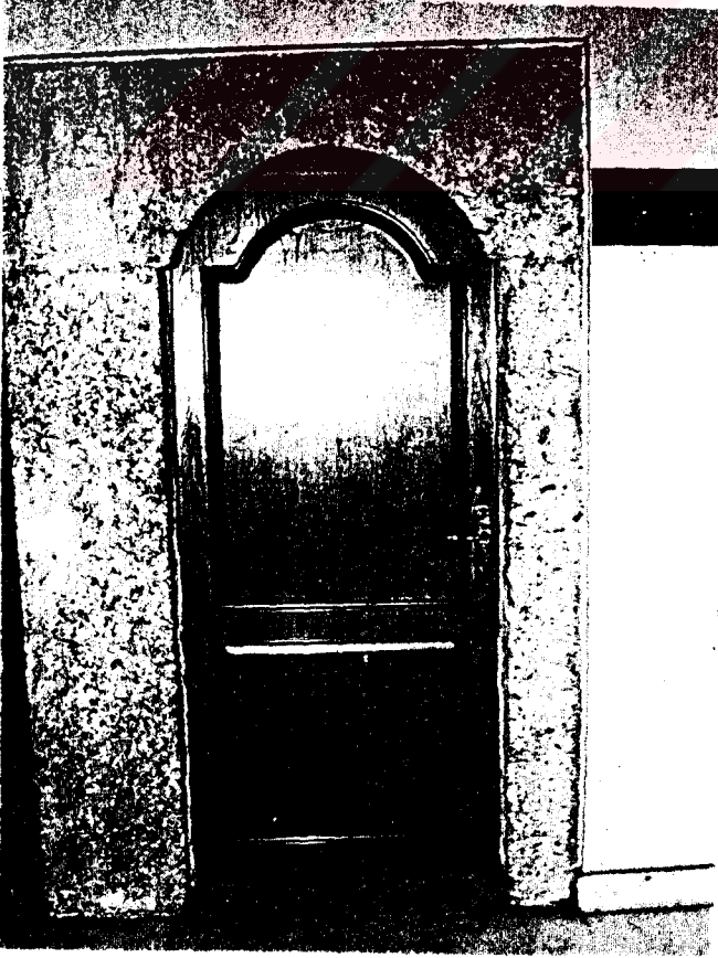
Resim 4. 67 Medrese eklenti ahşap oda kapısı
