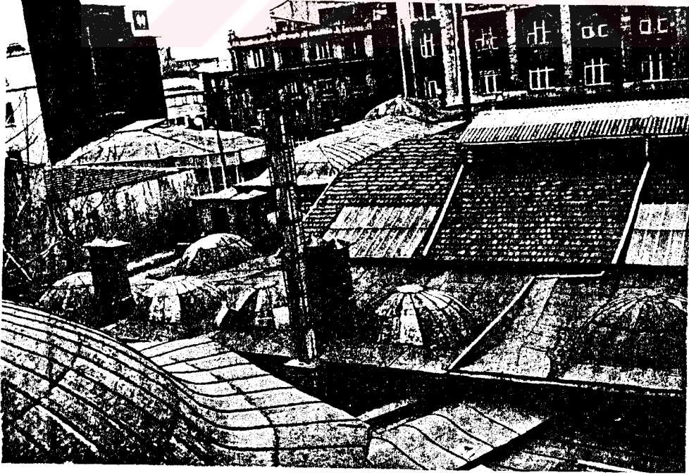
Resim 5. 10 Eklenti kalorifer bacasının görünüşü
