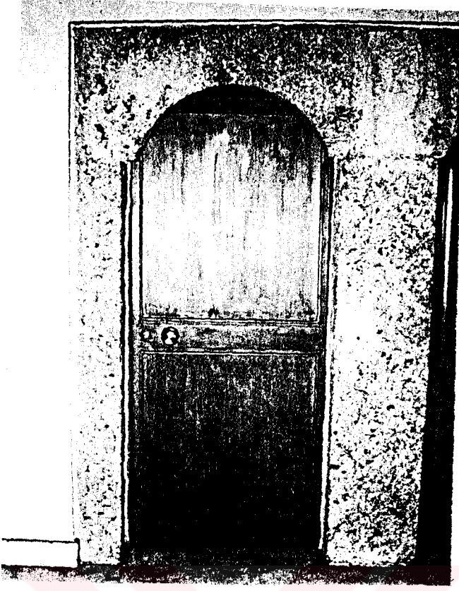
Resim 4. 66 Medrese eklenti demir bodruma iniş kapısı
