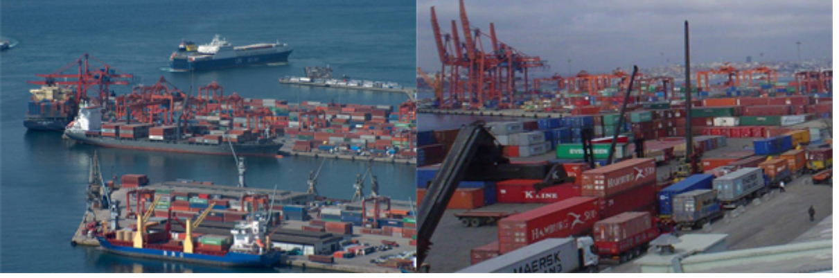
Şekil 6.2 Haydarpaşa limanı konteyner terminalleri genel görünüşü [3]
