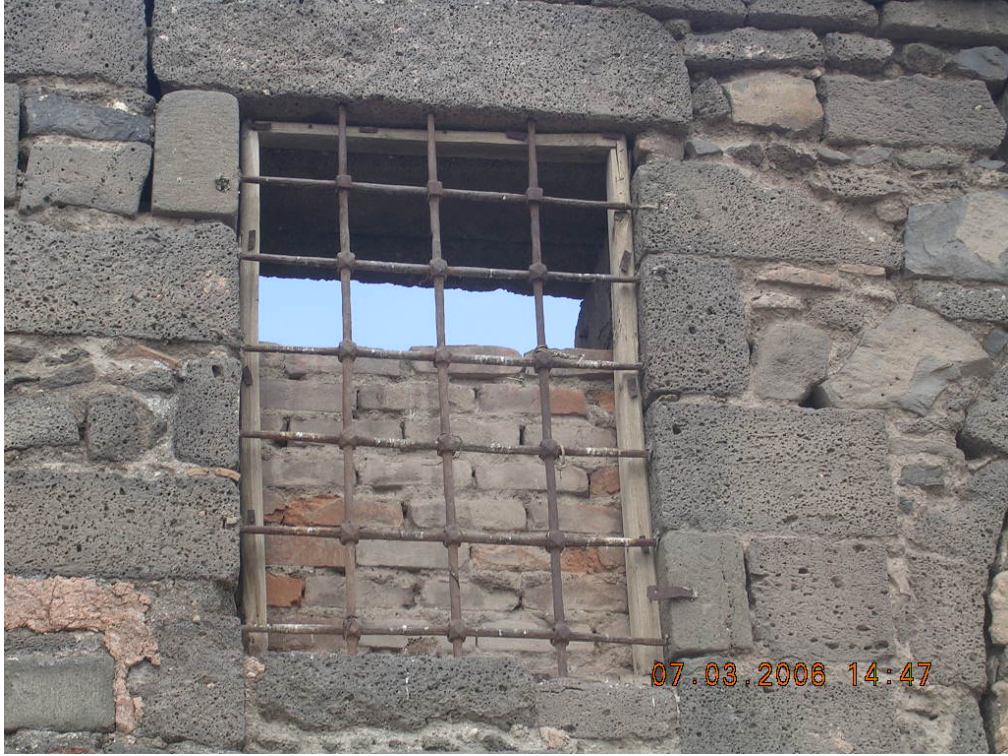
Şekil 5.29 Surp Sargis Kilisesi'nin pencere demir parmaklık detayı
