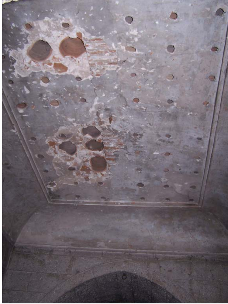
Şekil 5.18 Surp Sargis Kilisesi'nin vaftiz odasındaki manastır tonozu
