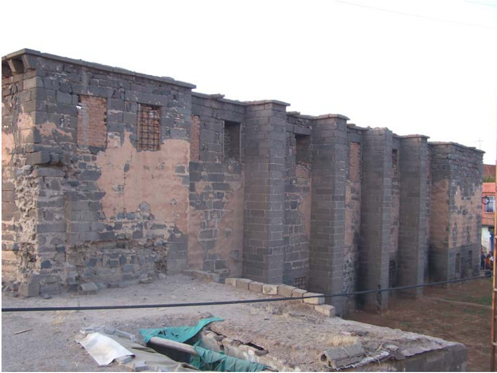
Şekil 5.13 Surp Sargis Kilisesi'nin sağ yan cephesi
