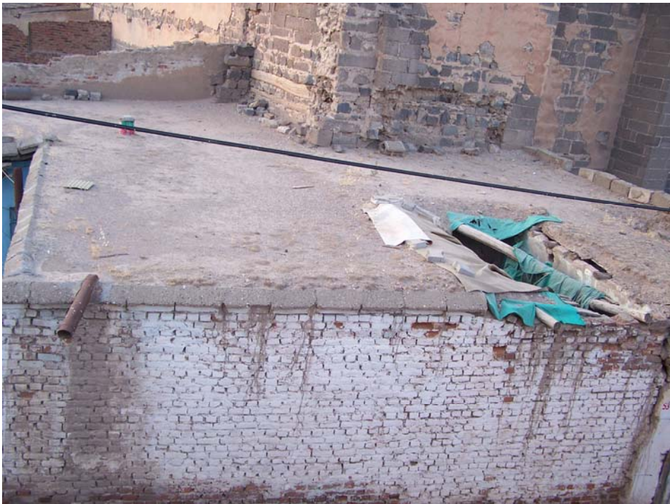
Şekil 5.38 Surp Sargis Kilisesi'ne bitişik ev
