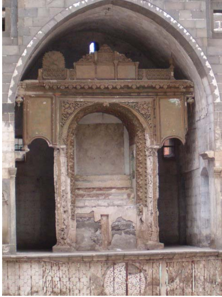
Şekil 5.31 Surp Giragos Kilisesi'nin altar detayı
