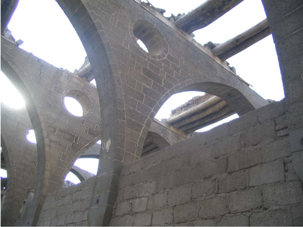
Şekil 5.44 Surp Sargis Kilisesi çatı örtüsünün naostan görünümü
