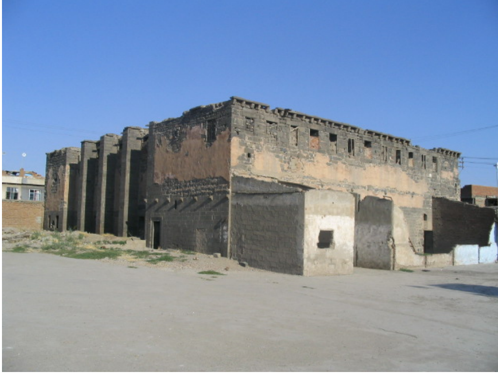
Şekil 4.27 Surp Sargis Kilisesi'nin kuzeybatı görünüşü
