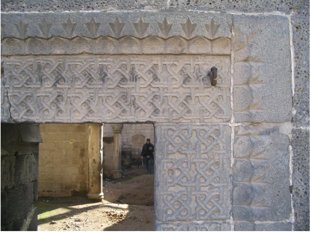
Şekil 5.21 Surp Sargis Kilisesi'nin sol yan (batı) cephesindeki kapı sövesi detayı
