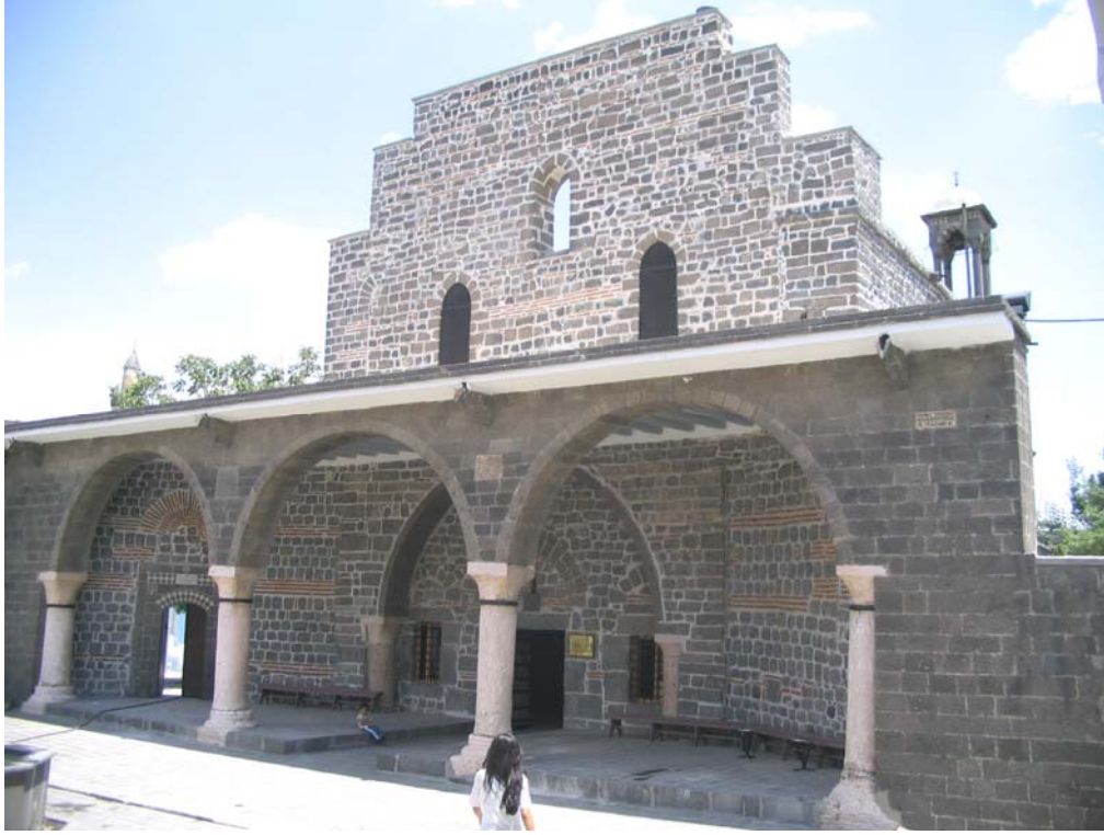
Şekil 4.31 Meryem Ana Kilisesi'nin batı görünüşü (onarımdan sonra)
