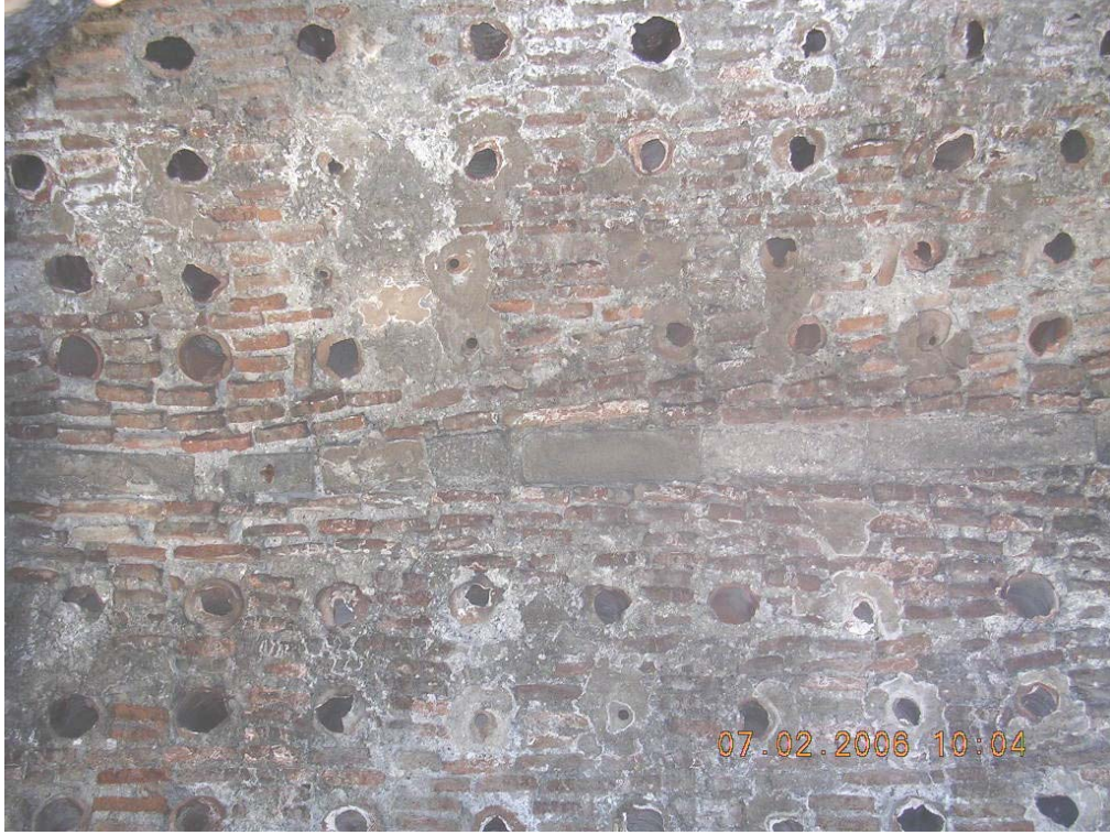
Şekil 5.40 Surp Sargis Kilisesi'nin üst kat odaları tonozunda bulunan ses yutucu küpler
