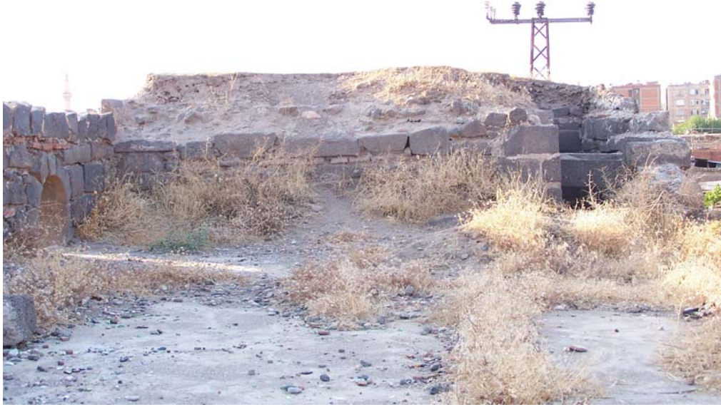
Şekil 5.36 Surp Sargis Kilisesi'nin apsit bölümünün üst örtüsünün şap kaplaması
