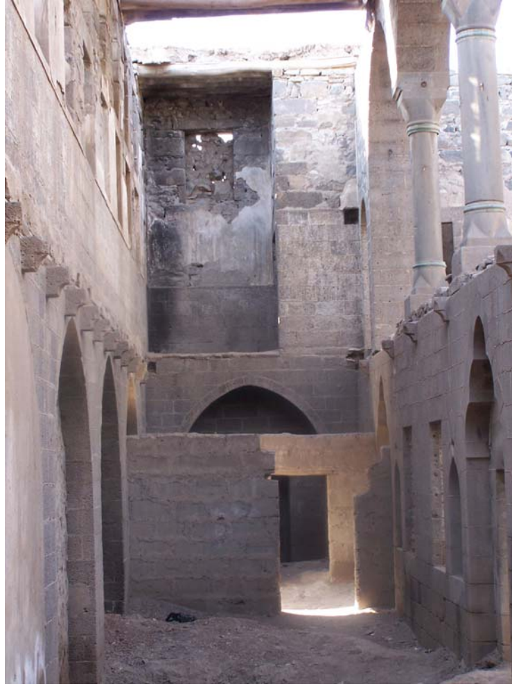
Şekil 5.5 Surp Sargis Kilisesi'nin narteks bölümü
