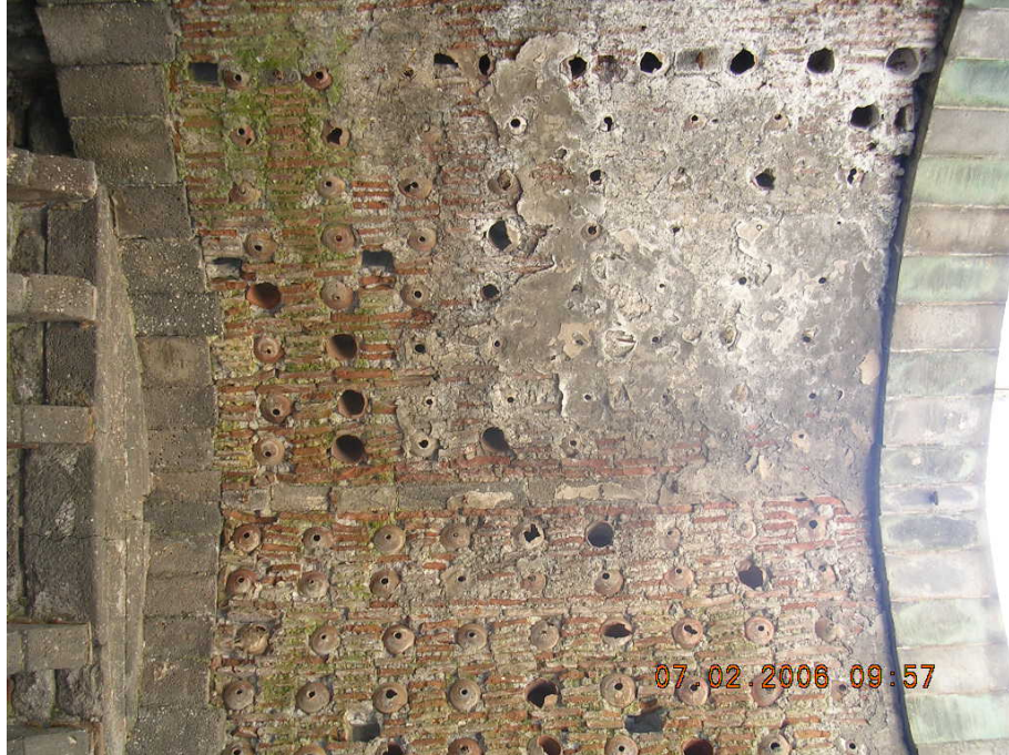
Şekil 5.25 Surp Sargis Kilisesi'nin orta apsisteki beşik tonoz ve tuğla küpleri
