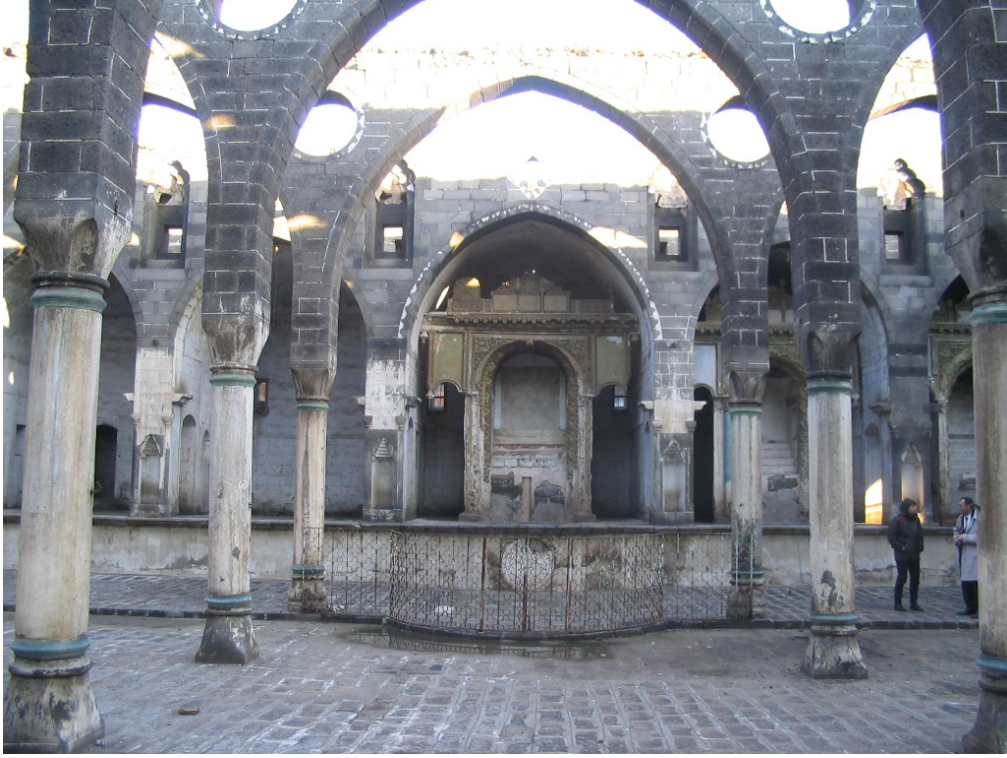
Şekil 4.20 Surp Giragos Kilisesi'nin iç mekandan görünümü
