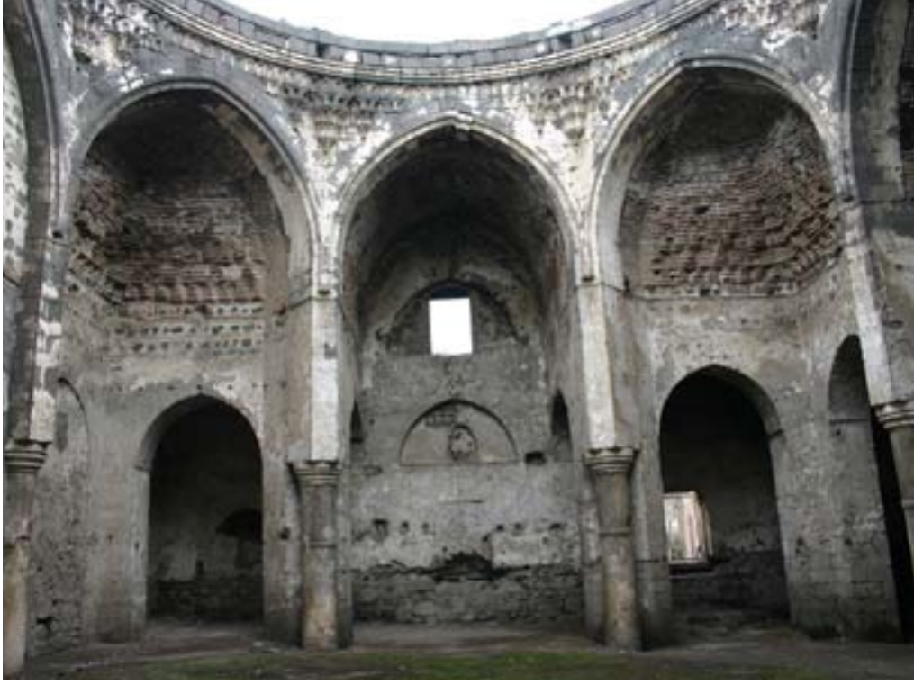
Şekil 4.50 Sen Corc Kilisesi'ne Artuklular Dönemi'nde eklendiği düşünülen hamam bölümü (Diyarbakır-info, 2006)
