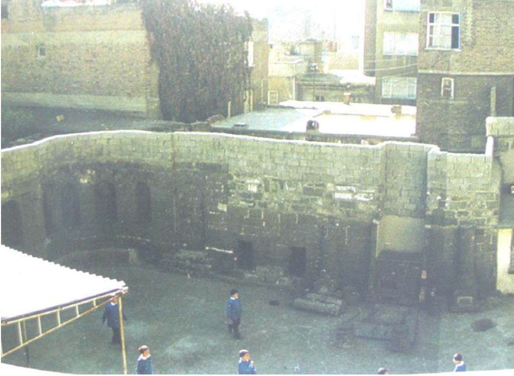
Şekil 4.60 Tamamen yok olmuş Süryani Katolik Kilisesi'nin arsası ve yan duvarı
