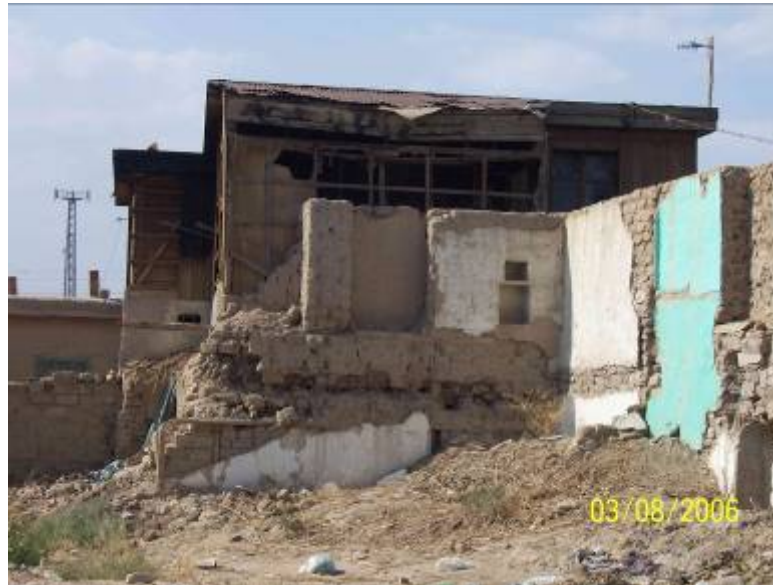
Şekil 4.82 Sedirler caddesindeki bir ev yıkıntısında geleneksel Konya evlerinde kullanılan yöresel malzemelerin tamamı görülebilmektedir.
