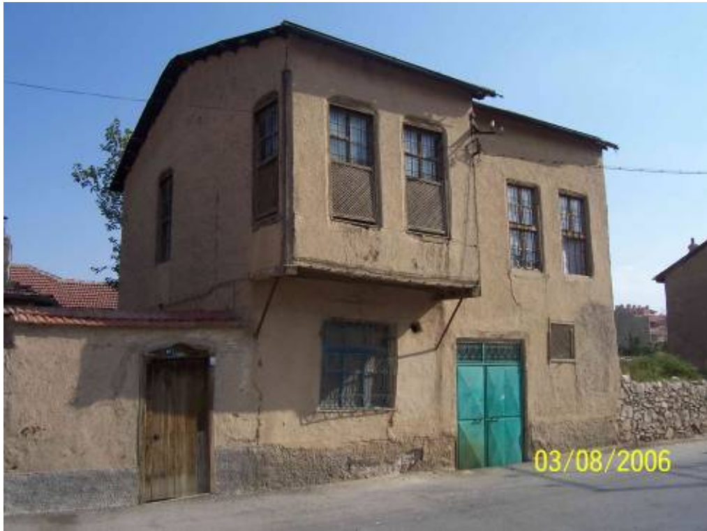
Şekil 4.28 Yediler mahallesinde bir evin çıkma pencerelerindeki ahşap kepenkler.
