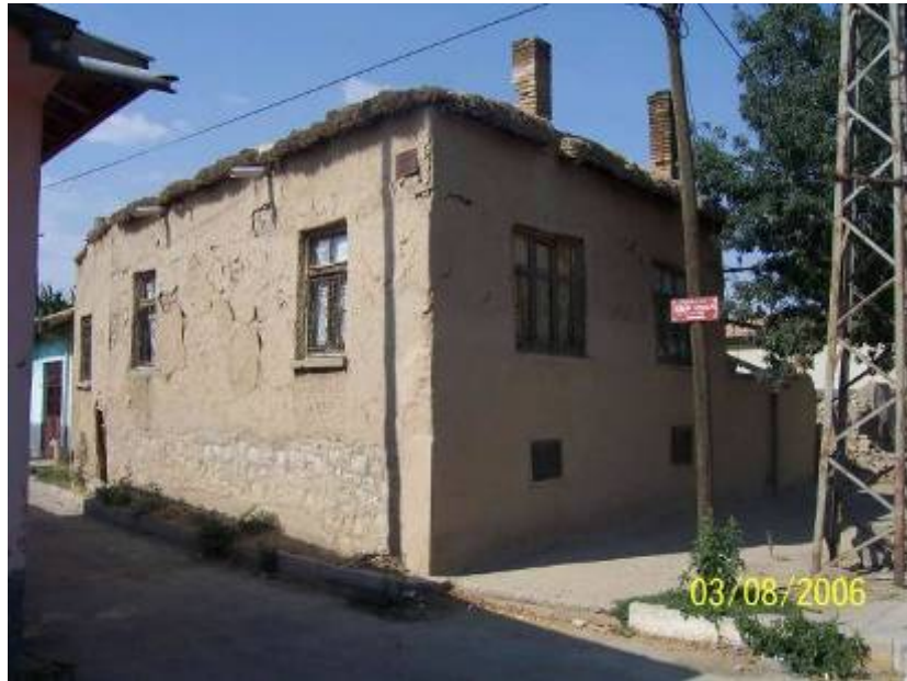
Şekil 4.71 Sedirler caddesi Âşık Paşa sokaktaki evin sazlıktan yapılmış çatısı.
