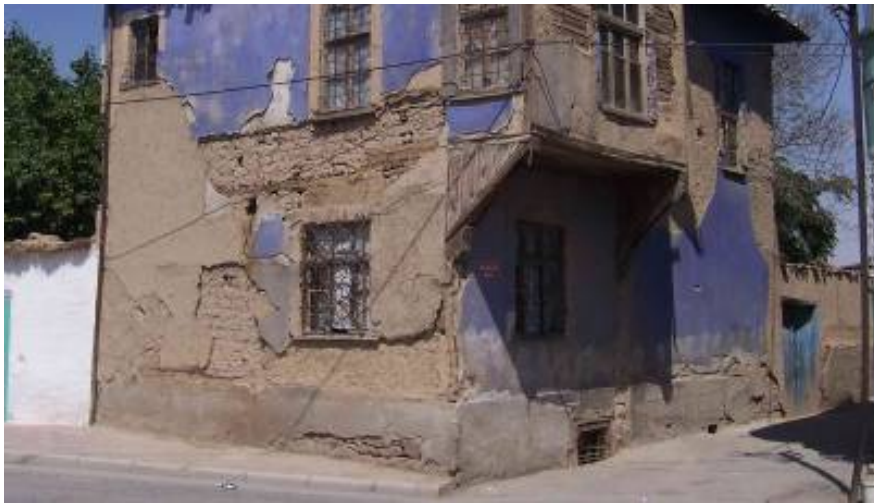
Şekil 4.74 Türbe civarındaki bir evin pencere alt ve üst hizalarındaki ahşap hatıllar.
