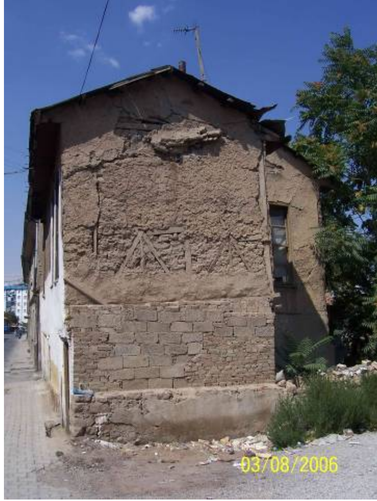
Şekil 4.75 Türbe mahallesindeki bir evin yan cephesindeki hımış duvar.
