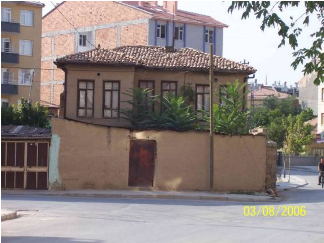
Şekil 4.80 Hayat duvarları ile kendi yeşil dokusu ve iklimsel korunumunu sağlayan, yeni yapı stokunun ortasında yeni yapılmış yollarla çevrilmiş eski bir Konya evi.
