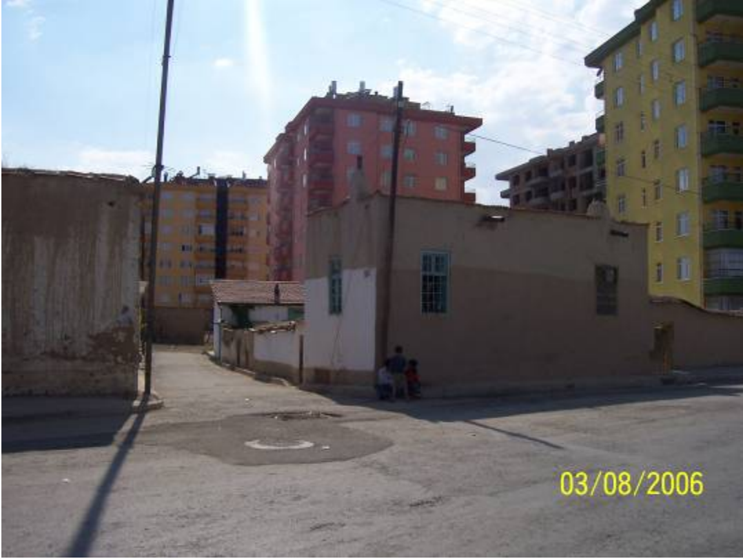
Şekil Ek 2.19 Sedirler mahallesinde yeni yapıların köşesinde kalmış bir ev.
