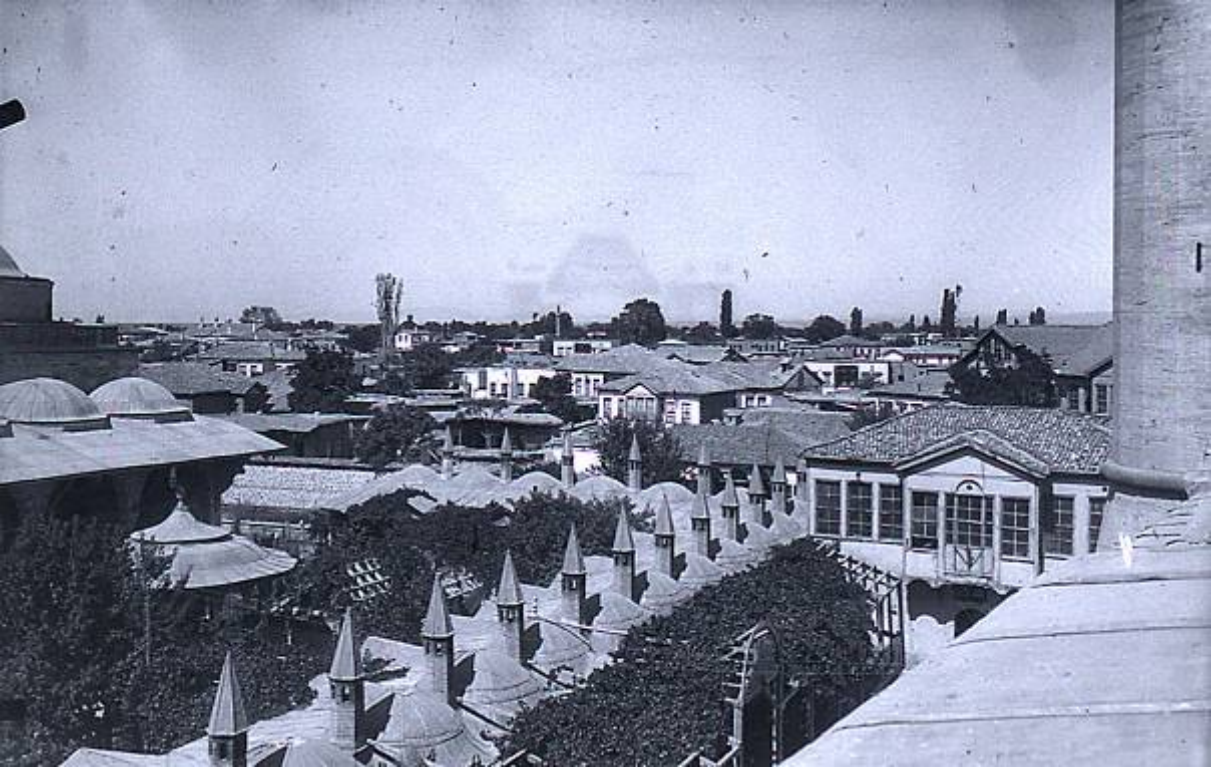
Şekil Ek 1.10 Sultan Selim Camisinden türbeye bakış. [18]
