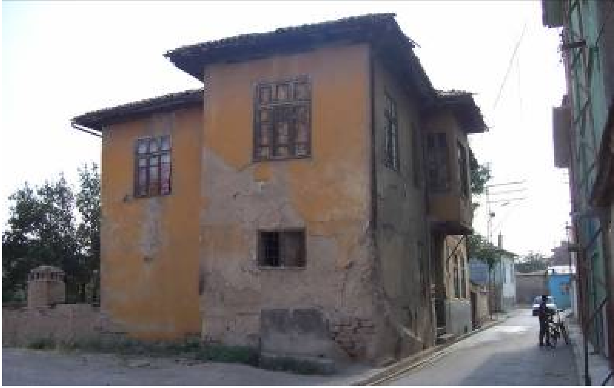
Şekil 4.79 Fenni fırın civarında cephesi çimentolu sıva ile kaplanmış bir ev örneği
