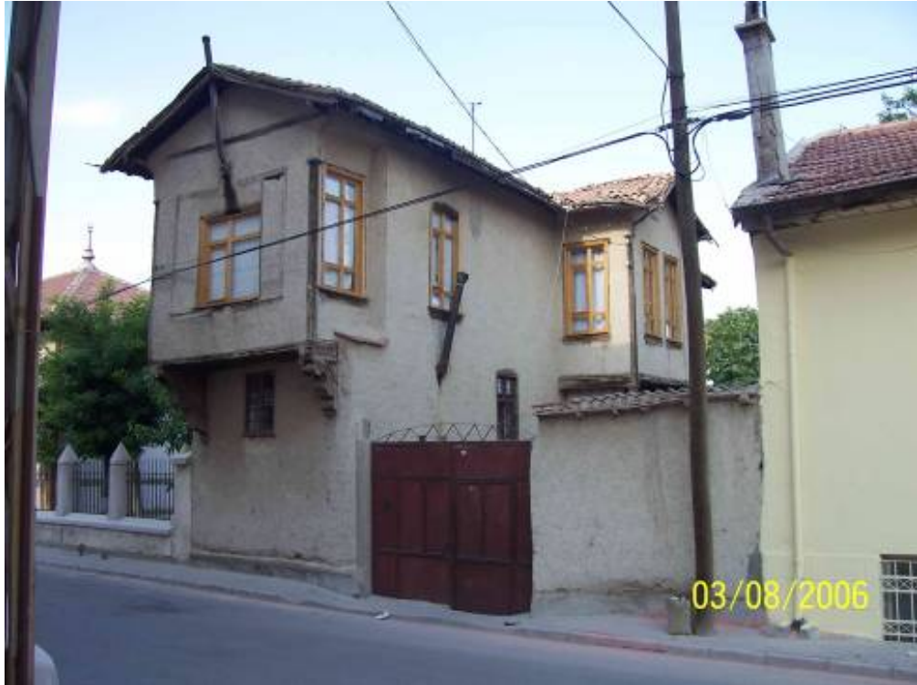
Şekil 4.30 Fenni fırın civarındaki evin iki çıkmasının altı ahşap kaplanmıştır.
