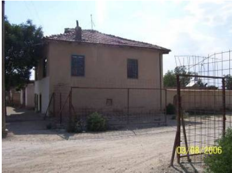
Şekil 4.23 Yıkılmış bir evin arsasından geçen yeni yol.
