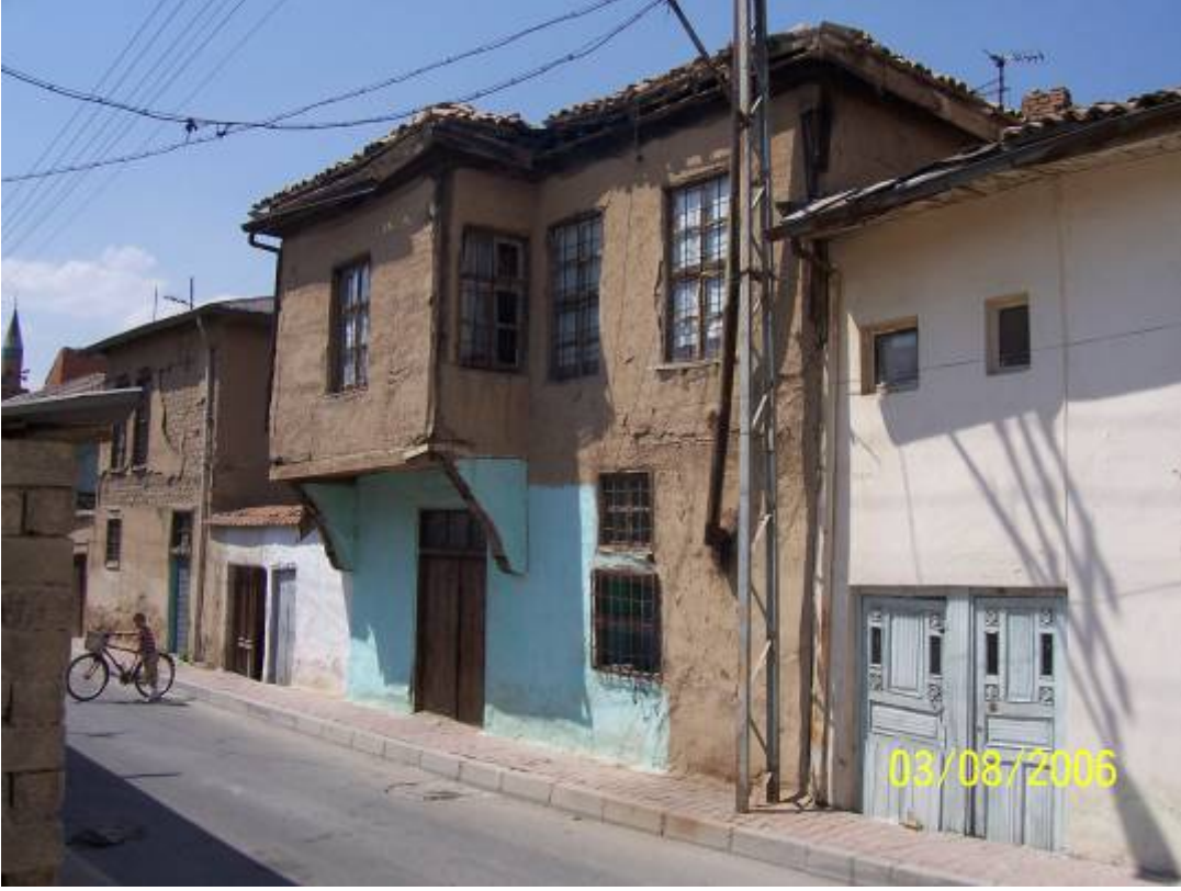
Şekil Ek 2.5 Kerpiç sıvalı evin cumba altı ahşap kaplanmıştır.
