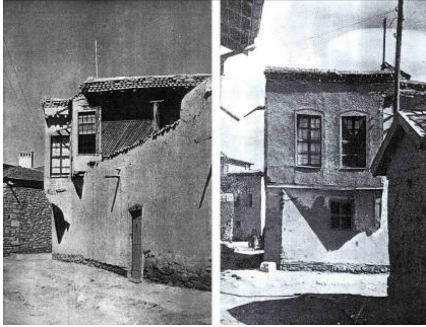
Şekil 4.48 Şems mahallesindeki Mustafa Uğur evinin sokaktan görünüşü. (Berk, 1951)
