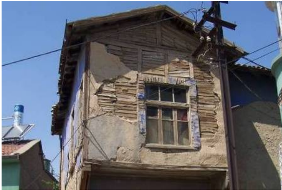
Şekil 4.76 Türbe civarı akarca sokaktaki evin bağdadi duvarı.
