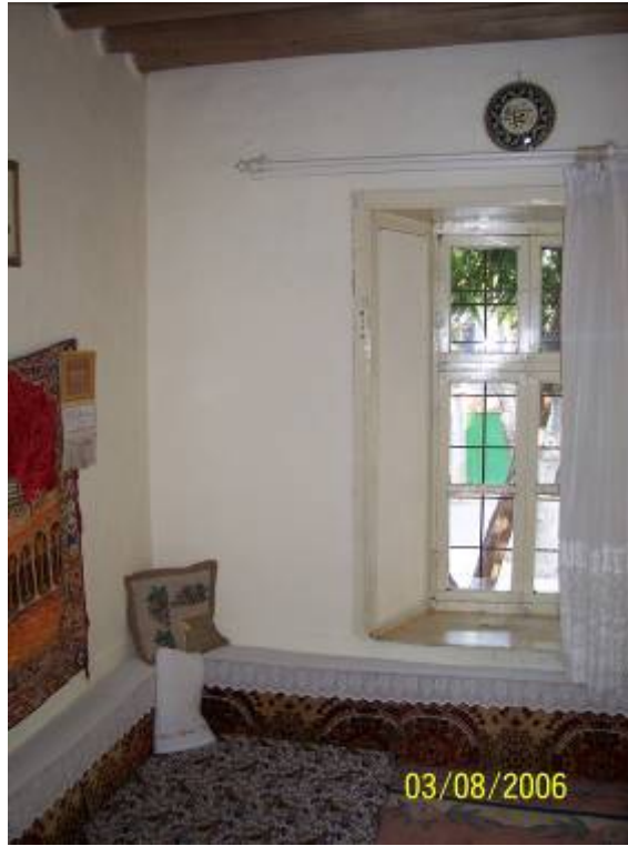
Şekil Ek 2.34 Mustafa Emine Sarvan evi, sokak cephesine bakan pencere nişi, pencerenin önünde bulunan ahşap sedir sonradan yıkılmıştır.
