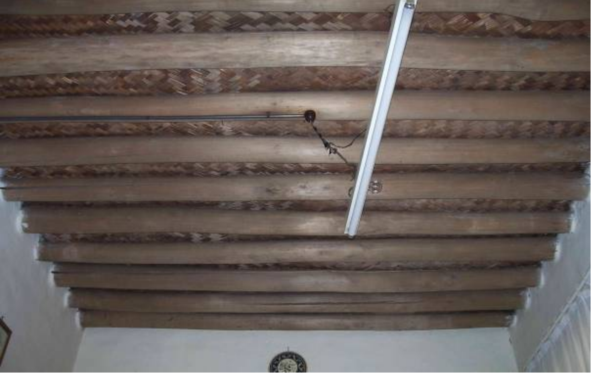
Şekil 4.69 Mustafa-Emine Sarvan evinin tavanındaki kavak ağacından yapılmış kirişler.
