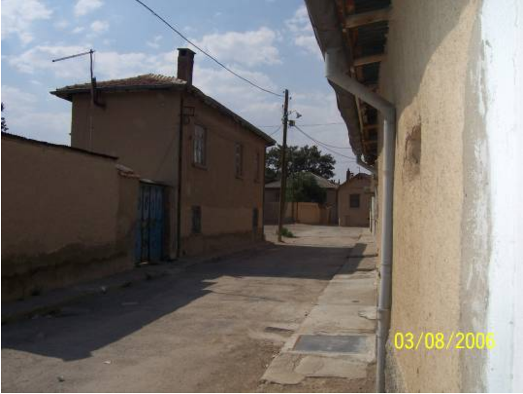
Şekil Ek 2.15 Sedirler caddesinde evin ahşap hayat kapısı demir kapı yapılmıştır.
