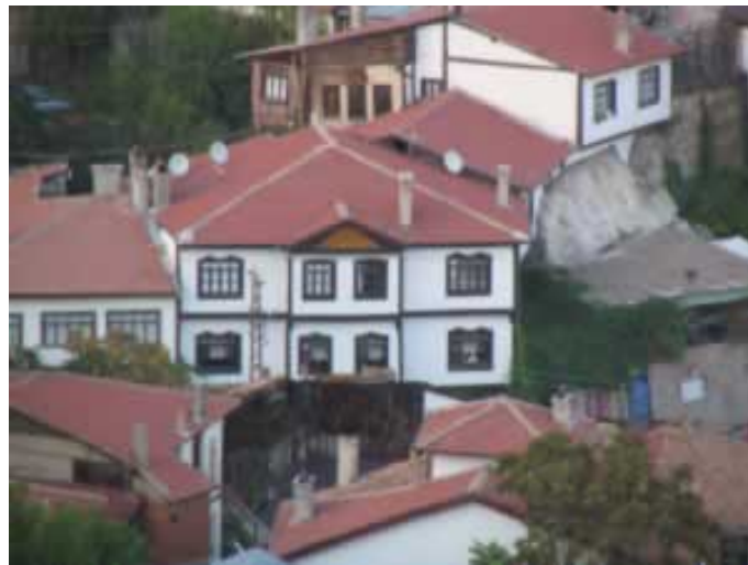
Şekil 4.15 Beypazarı evlerinden çatı ve cephe görünüşleri
