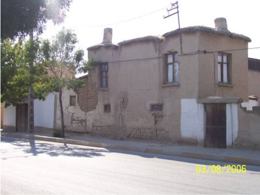
Şekil Ek 2.22 Yediler caddesindeki evin sazlık düz damı ve çörtenleri.
