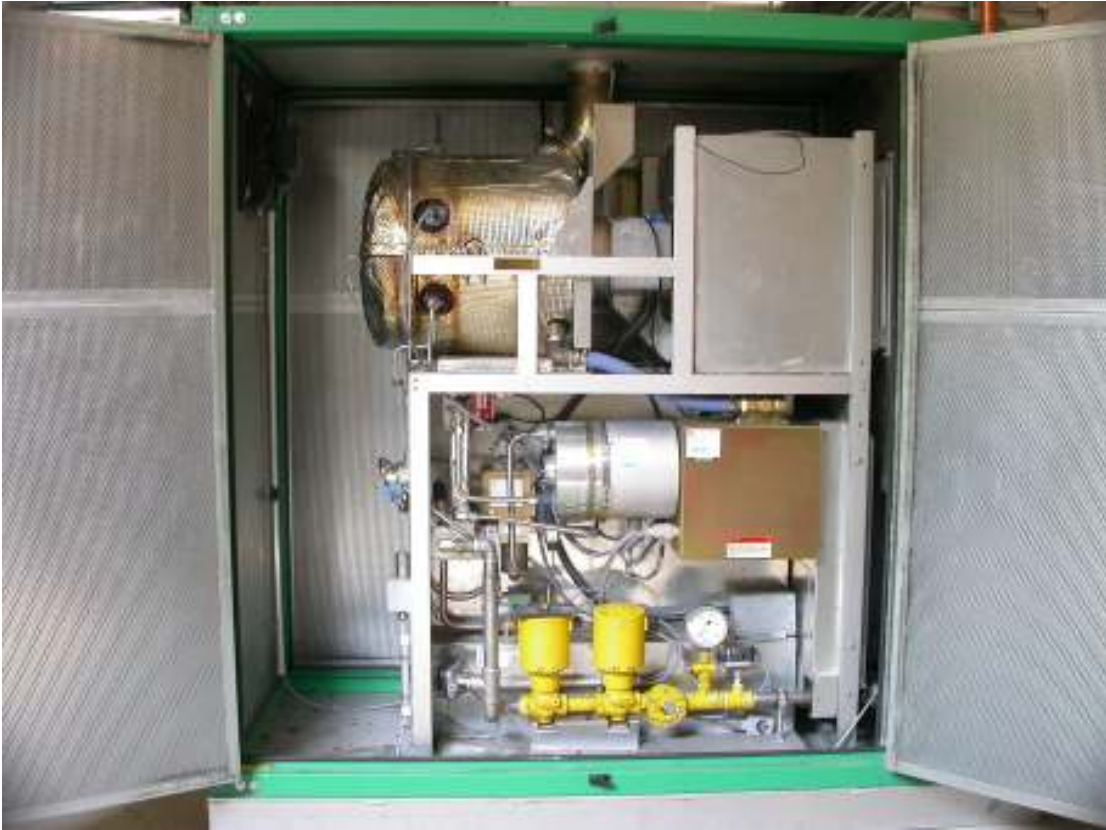
Resim 3.2 Sistemde Kullanılan Capstone C 30 Mikrogaztürbininin Dış Görünüşü
