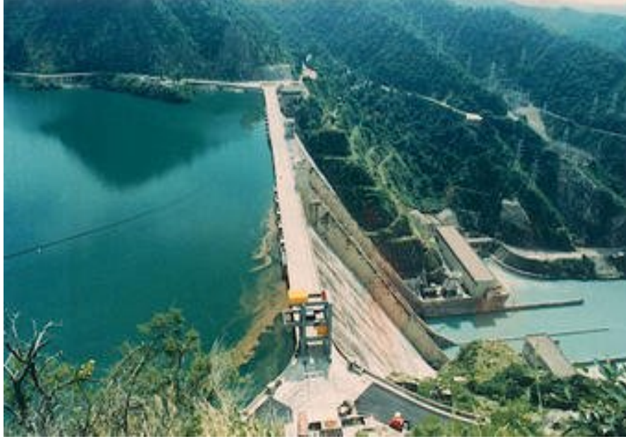
Şekil 2.1 Beton ağırlık barajı örneği (Hoşbaş, 2004)
