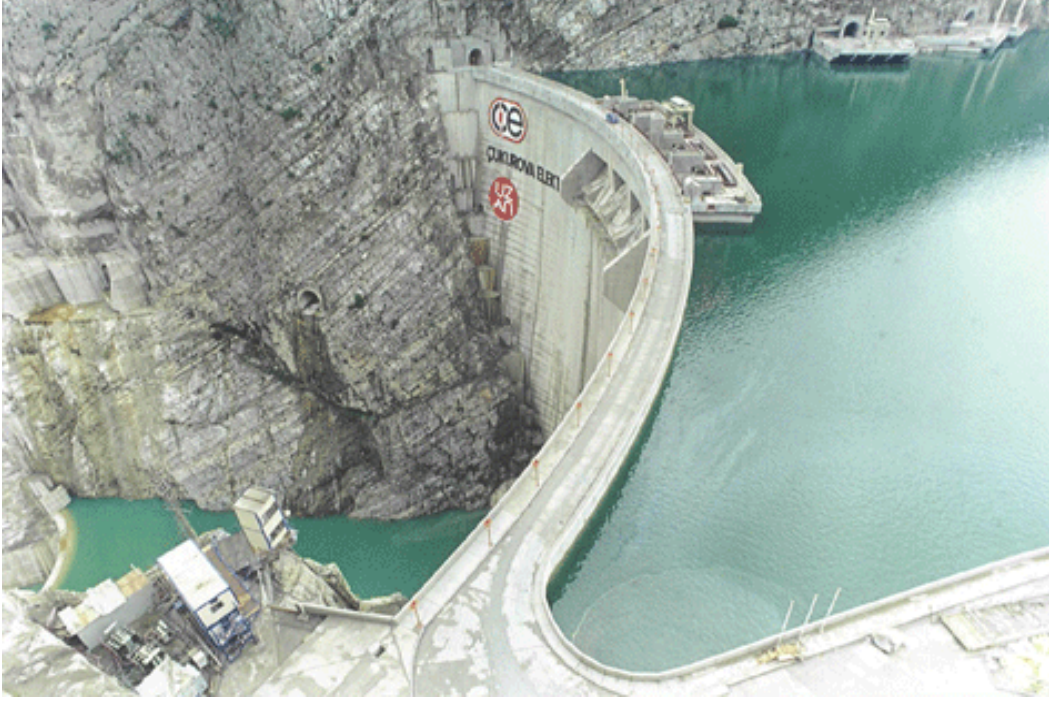
Şekil 2.2 Beton kemer baraj örneği ( http://www.suvakfi.org.tr/makale-berke.htm )
