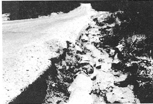
Şekil 4.41 Yüksek yoğunlukta kenar / banket düşüklüğü (Shahin, 2002)
