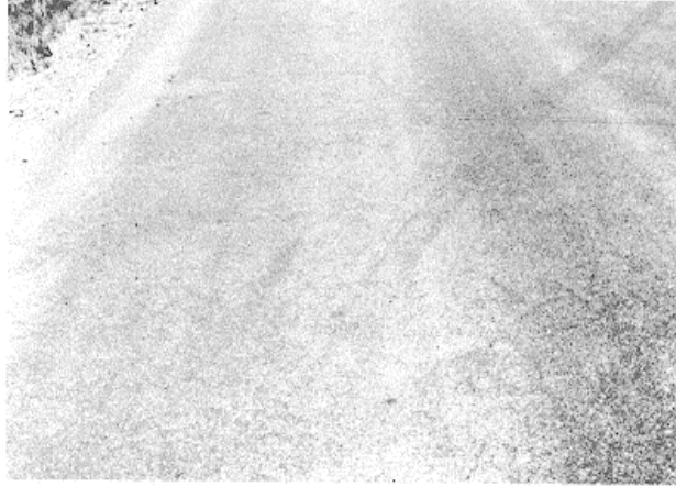
Şekil 4.18 Düşük yoğunlukta kuma (Shahin, 2002)
