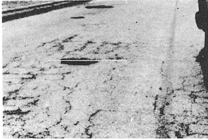
Şekil 4.50 Orta yoğunlukta oyulma (Shahin, 2002)
