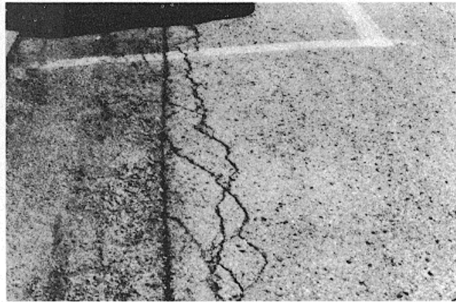
Şekil 4.34 Orta yoğunlukta kenar çatlağı (Shahin, 2002)
