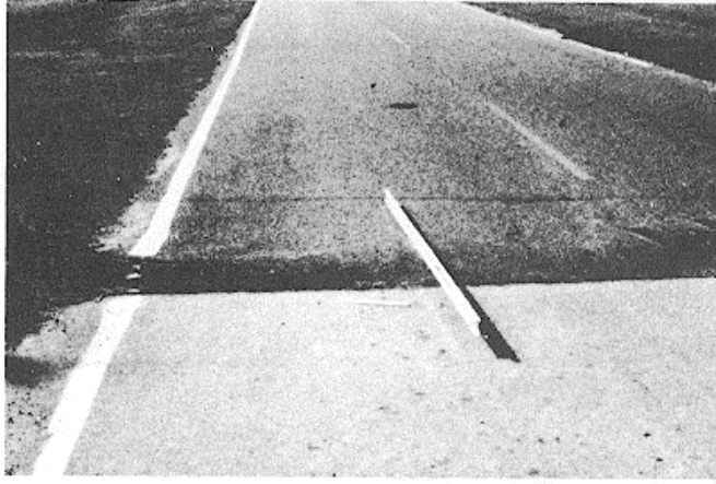
Şekil 4.60 Yüksek yoğunlukta toplanma (Shahin, 2002)
