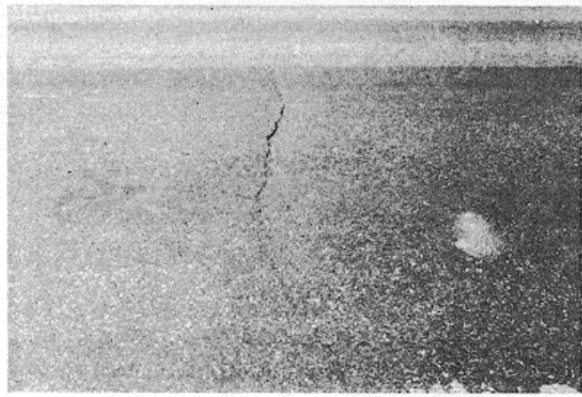
Şekil 4.42 Düşük yoğunlukta boyuna ve enine çatlaklar (Shahin, 2002)
