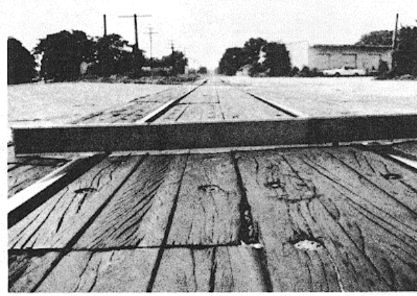
Şekil 4.52 Düşük yoğunlukta demiryolu geçişi kusuru (Shahin, 2002)
