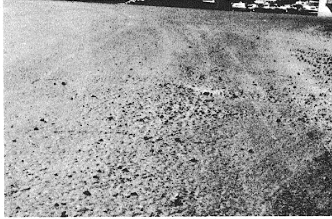
Şekil 4.66 Orta yoğunlukta sökölme ve ayrışma (Shahin, 2002)
