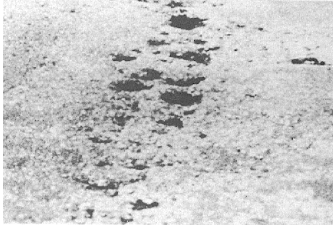
Şekil 4.67 Yüksek yoğunlukta sökölme ve ayrışma (Shahin, 2002)
