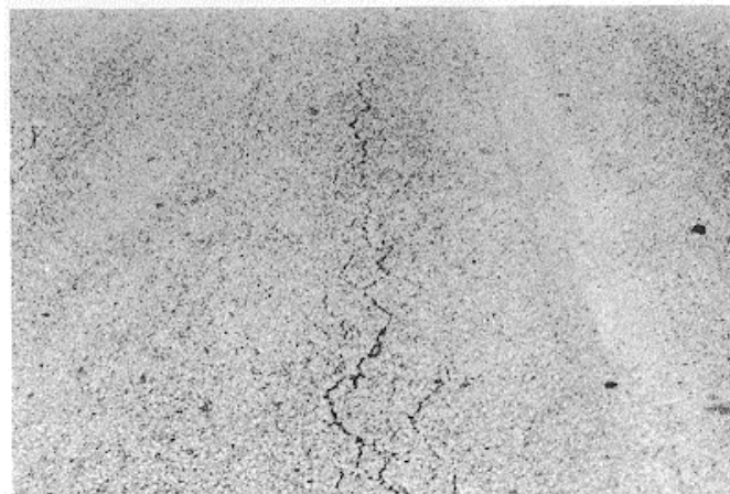
Şekil 4.15 Düşük yoğunlukta timsah sırtı çatlak (Shahin, 2002)
