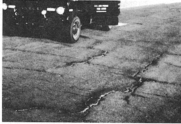
Şekil 4.23 Yüksek yoğunlukta blok çatlak (Shahin, 2002)
