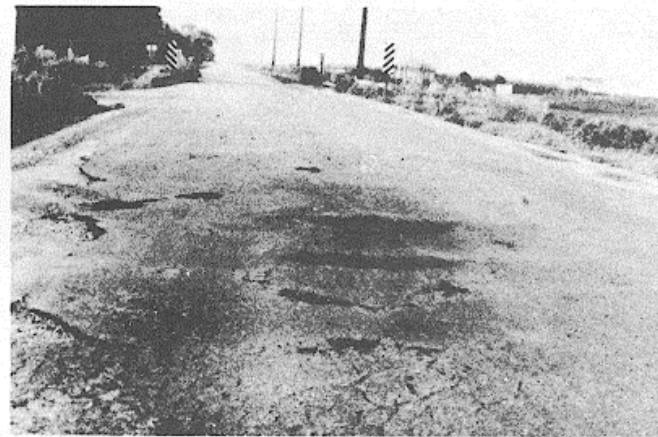
Şekil 4.59 Orta yoğunlukta toplanma (Shahin, 2002)
