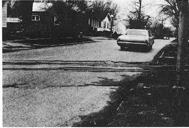
Şekil 4.54 Yüksek yoğunlukta demiryolu geçişi kusuru (Shahin, 2002)
