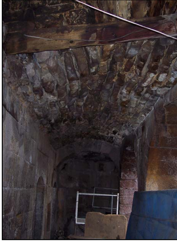
Şekil 4.16 Pamuk Hanı üst kat güney revaklarının tonozu.
