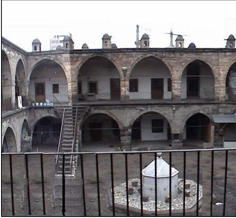
Şekil 4.25 Vezir Hanı 2. avlu kuzey revakları.
