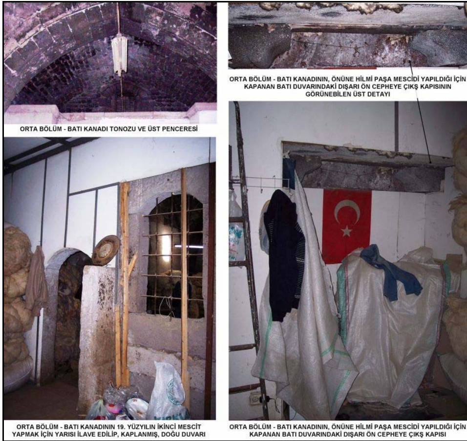
Şekil 5.26 Bedestenin güney bölümüne, 19. yüzyılın ikinci yarısı mescit yapmak için bölünen batı kanadı.
