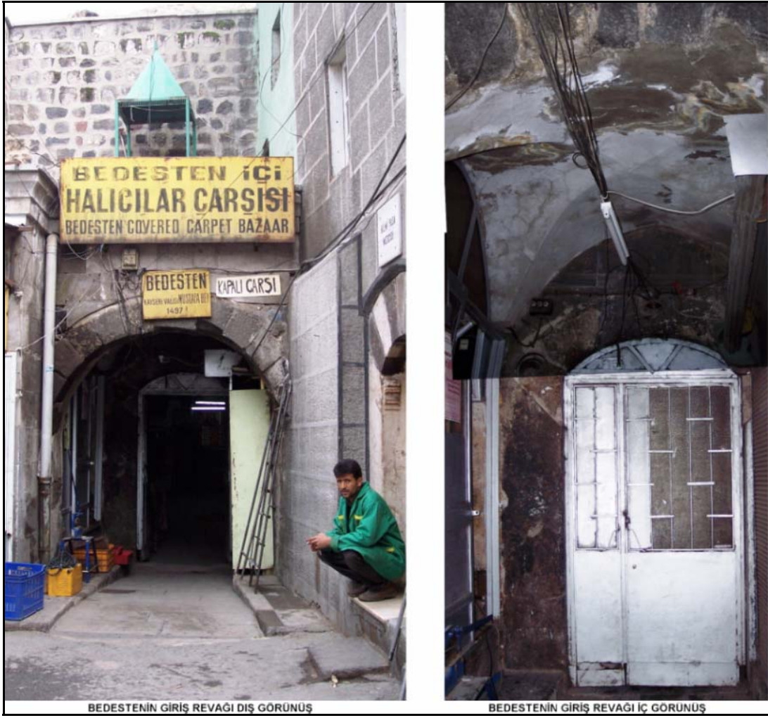
Şekil 5.14 Bedesten giriş revağı.
