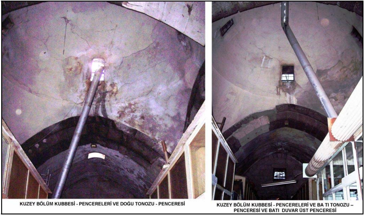
Şekil 5.29 Bedestenin kuzey bölümünün iki başında bulunan iki yüksek sivri tonozu ve ortasındaki kubbesi.
