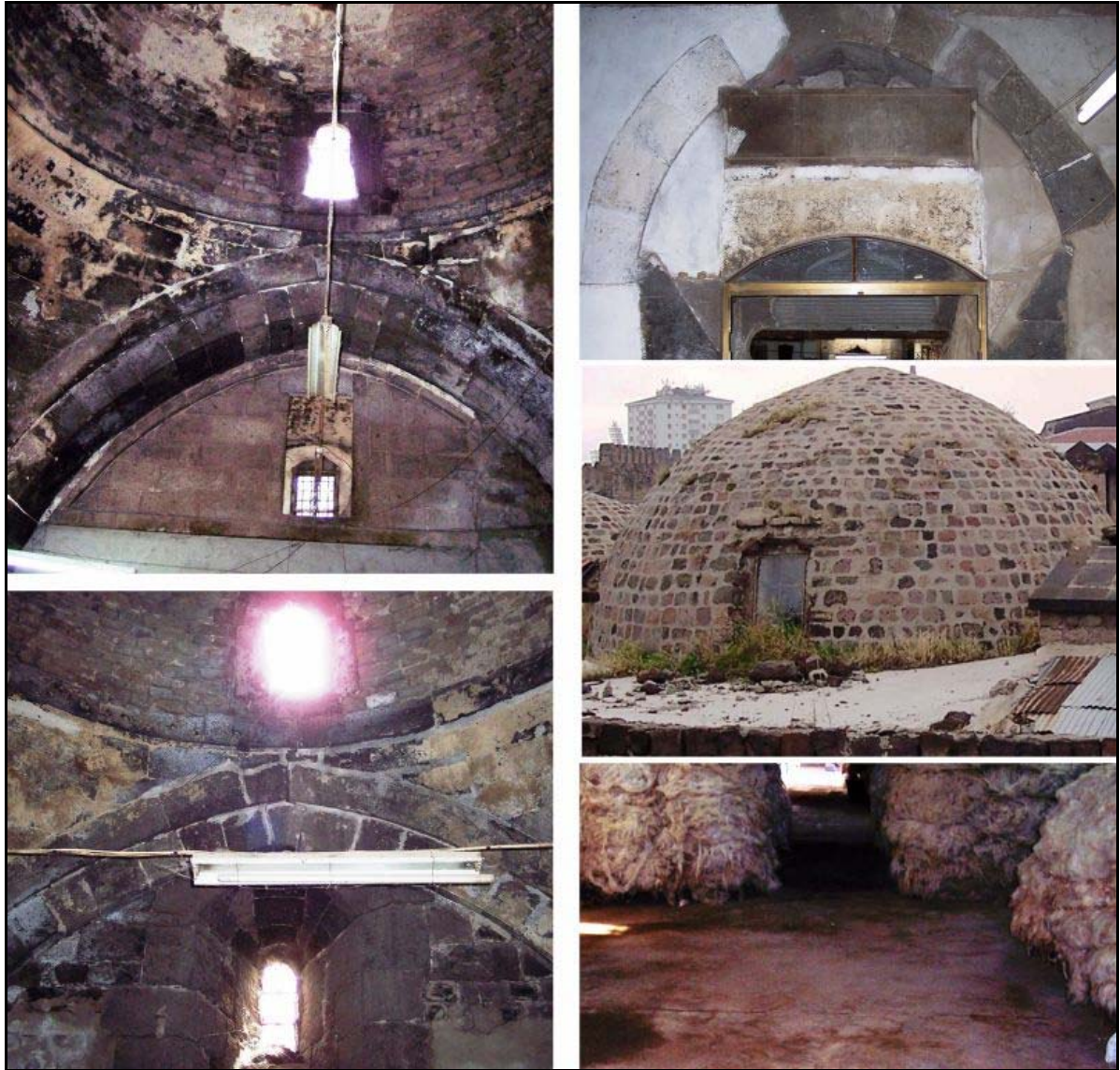
Şekil 5.63 Bedestenin güney bölümünün orta kısmındaki bozulmalar.
