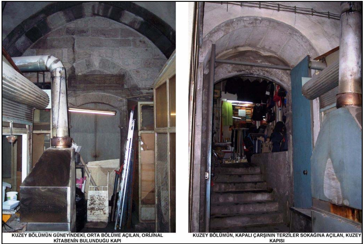
Şekil 5.30 Bedestenin kuzey bölümünün güneyindeki üzerinde asıl kitabenin bulunduğu, bedestenin orta bölümüne açılan kapı ve yine kuzey bölümün kuzeyindeki kapalı çarşının Terziler sokağına açılan kapısı.
