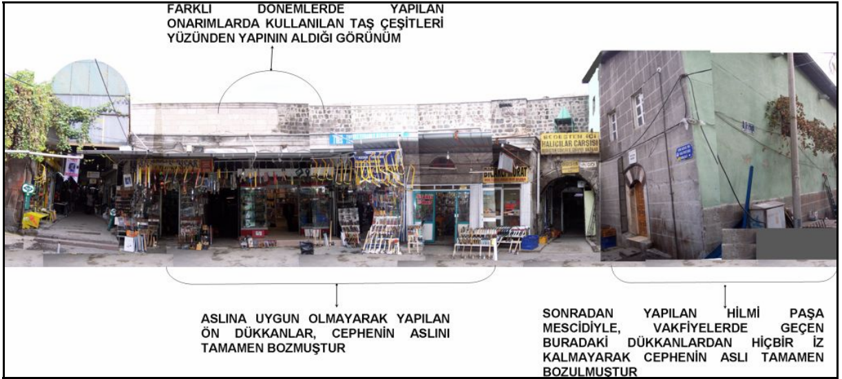
Şekil 5.59 Bedestenin çevresindeki bozulmalar ve sorunlar.
