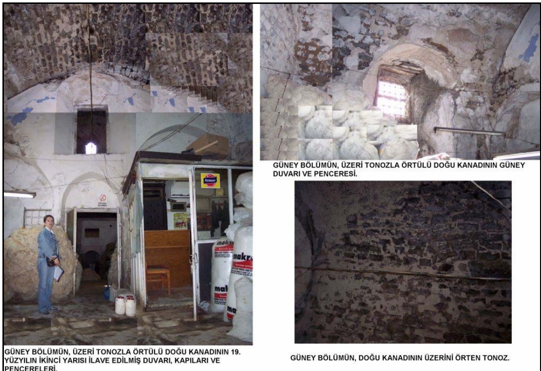
Şekil 5.28 Bedestenin güney bölümünün doğu kanadının güney duvarı, penceresi, batı duvarı, pencereleri ve kapısı ve tonozu.
