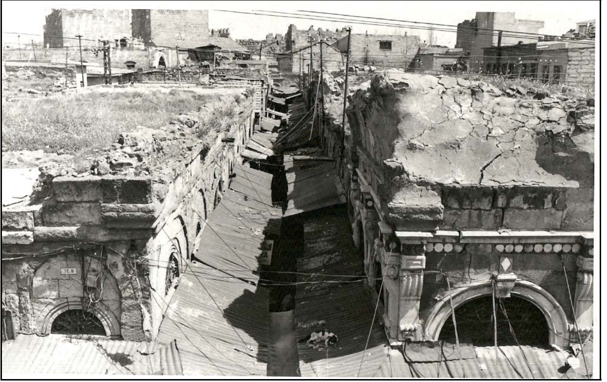
Şekil 4.35 Kapalı çarşının tonozları yıktırıldıktan sonraki 13.11.1981 yılındaki hali.
