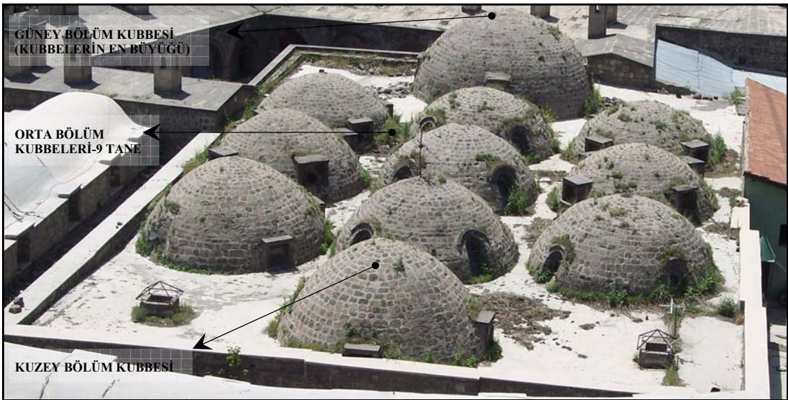
Şekil 5.13 Bedesten çatı döşemesinin, kubbelerinin ve kubbe pencerelerinin üstten görünümü.
