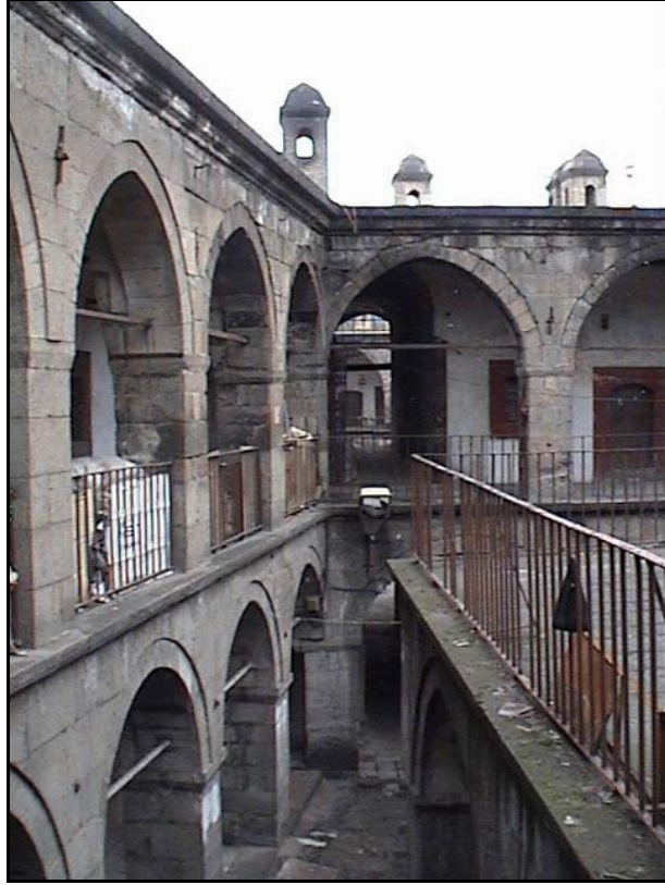
Şekil 4.26 Vezir Hanı 3. avlu güney revakları ve 3. avluya geçiş koridoru.
