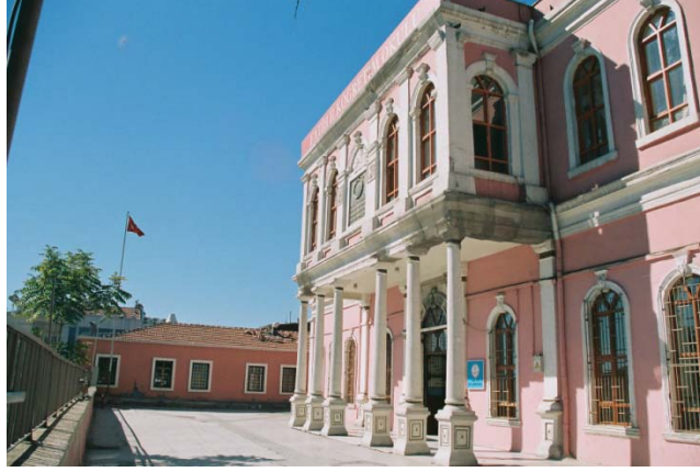
Fotoğraf No 30: Fatih Askeri Rüşdiyesi (Fatih İlköğretim Okulu) Kuzeydoğu (Giriş) Cephesi
