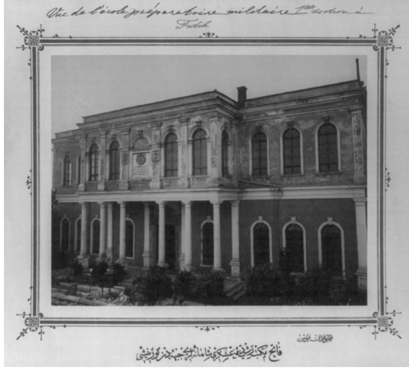
Fotoğraf No 27: Fatih Mekteb-i Rüşdiye-i Askeri-i Şahaneleri Cepheden Görünüşü
