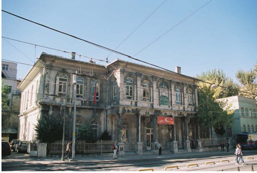
Fotoğraf No 65: Soğukçeşme Askeri Rüşdiyesi (İstanbul Çocuk Mahkemeleri) Kuzeydoğu (Giriş) Cephesi
