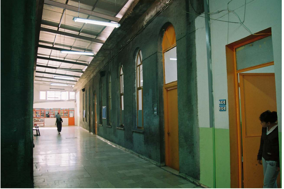
Fotoğraf No 50: Kocamustafapaşa Askeri Rüşdiyesi'nin Güneybatı Cephede Bulunan Tenefüşhanesi
