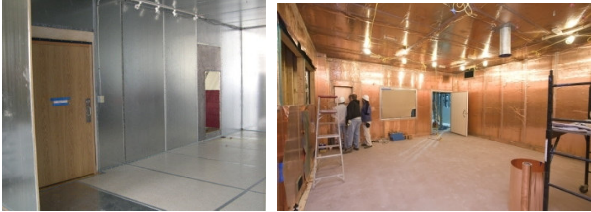
Şekil 4.38 Manyetik kalkan ile kaplanmış RF kalkanı [7]
