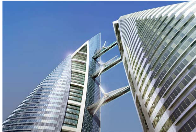
Şekil 3.3 Bahrain Dünya Ticaret Merkezi, kuleler arasındaki rüzgar türbinleri [30]
