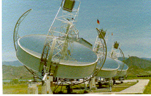
Şekil 5.30 Parabolik çanak güneş ısı elektrik santrali, İspanya [60]
