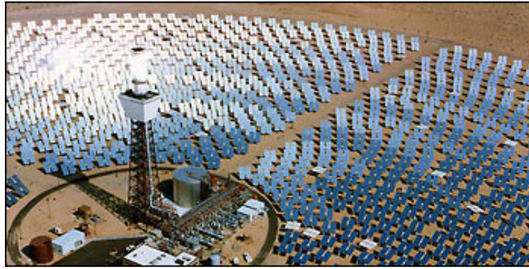
Şekil 5.31 Solar 1 merkezi alıcı güneş ısı elektrik santrali, İspanya [60]
