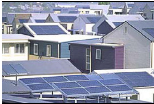
Şekil 4.10 Olimpiyat sporcular köyündeki evlerin çatılarındaki fotovoltaik modüller (Eryıldız vd., 2005)
