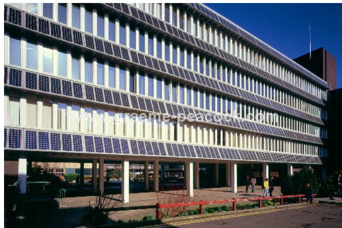
Şekil 5.34 Cephede uygulanmış fotovoltaik paneller, Northumbria Üniversitesi, Newcastle, UK [65]
