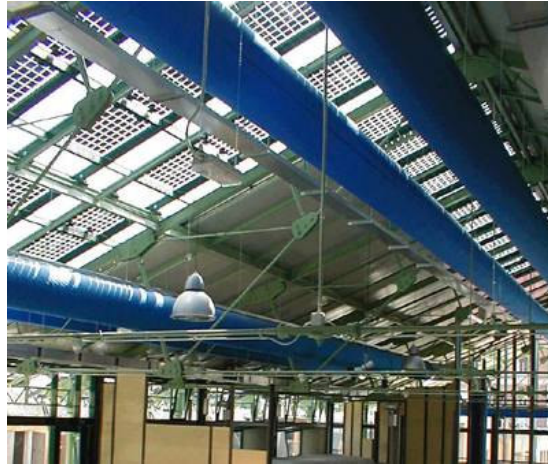
Şekil 5.73 Çatıdaki fotovoltaik modüllerin iç mekandan algılanışı, Roma Çocuk Müzesi [72]
