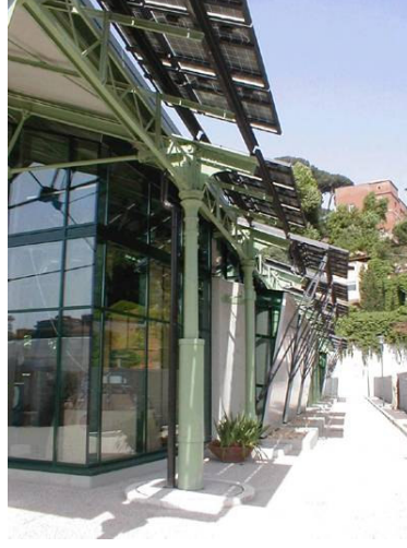
Şekil 5.70 Fotovoltaik modüllerden oluşan gölgeleme elemanları [72]
