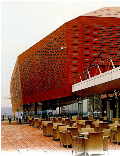
Şekil 5.171 Meydan Alışveriş Merkezi, orta avludan görünüm (Sağnak, 2008)
