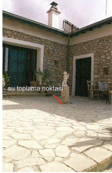
Şekil 5.89 Quensel Evi, avludaki su toplama noktası (Deviren, 2006)
