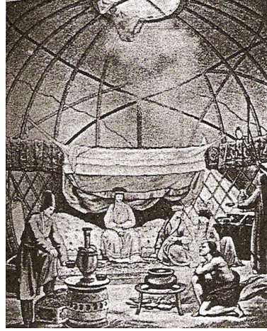
Şekil 2.10 Mongul yurdu, iç mekandan görünüş (Bowen, 1985)
