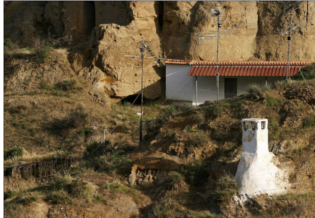
Şekil 2.34 Guadix, İspanya, mağara evleri ve havalandırma bacalarından görünüm [13]
