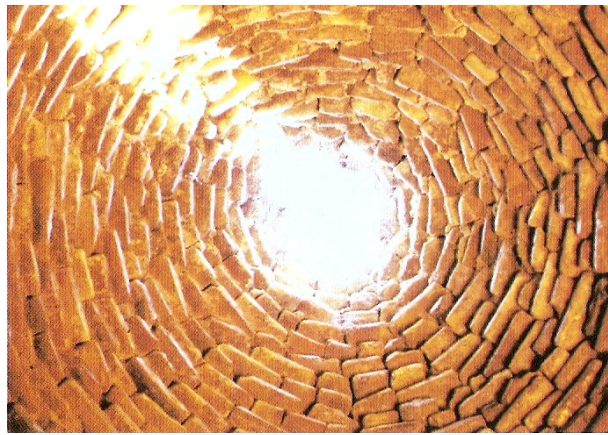
Şekil 2.22 Yassı tuğlaların her sırada içeri doğru kaydırılmasıyla (bindirmeli olarak) örülen konik kubbeler (Özdeniz vd., 1998)
