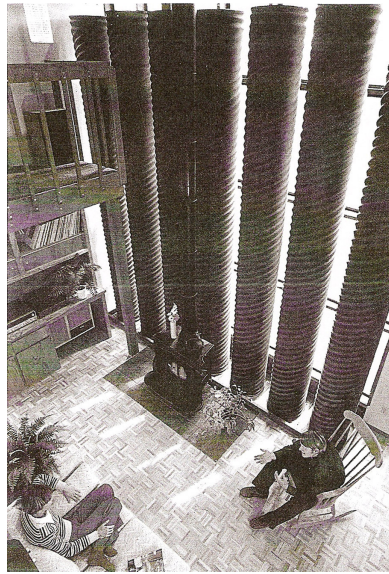
Şekil 5.47 Su dolu kolon sistemine sahip bir evden görünüm (Clark, 1978)
