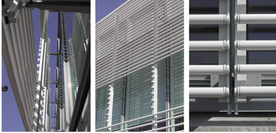
Şekil 5.165 New York Times Binası, dış cephede yer alan güneş kalkanı [103]
