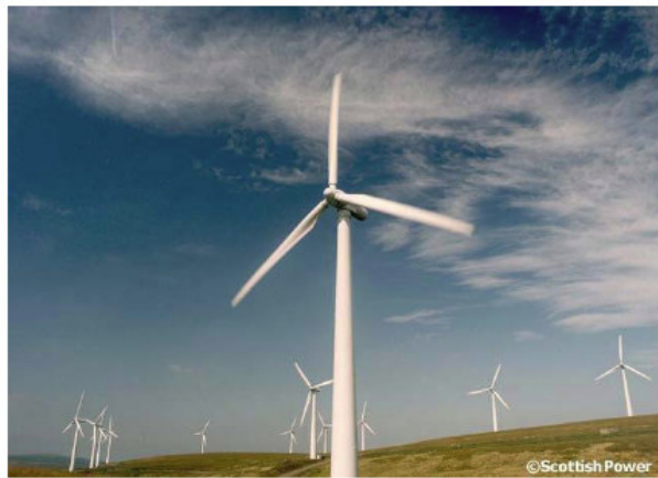
Şekil 2.7 Elektrik üreten üç kanatlı rüzgar türbinleri
