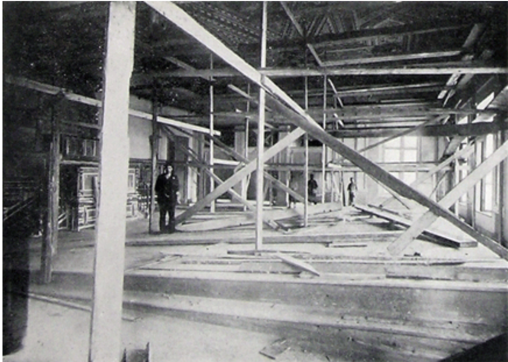
Şekil 3.10. Darülfünun'un binasının Adliye Nezareti'ne dönüştürülmesi çalışmaları (Şehbal, 1 Teşrinisani 1325/ 14 Kasım 1909, s.290).
