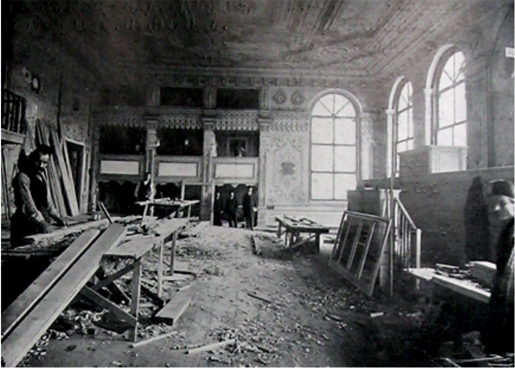
Şekil 3.9. Darülfünun binasındaki Mebusan Meclisi salonunun mahkeme salonuna dönüştürülmesi çalışmaları (Şehbal, 1 Teşrinisani 1325/ 14 Kasım 1909, s.290).
