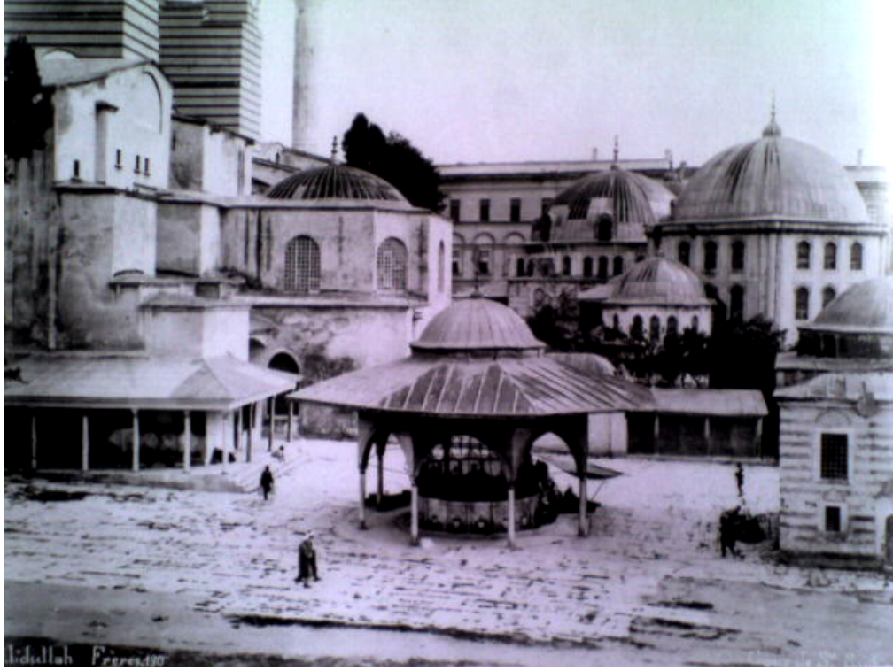
Şekil 3.15. Ayasofya'nın dış avlusundan Darülfünun binasının görünüşü (Genç ve Çolak, 2007, s.238).
