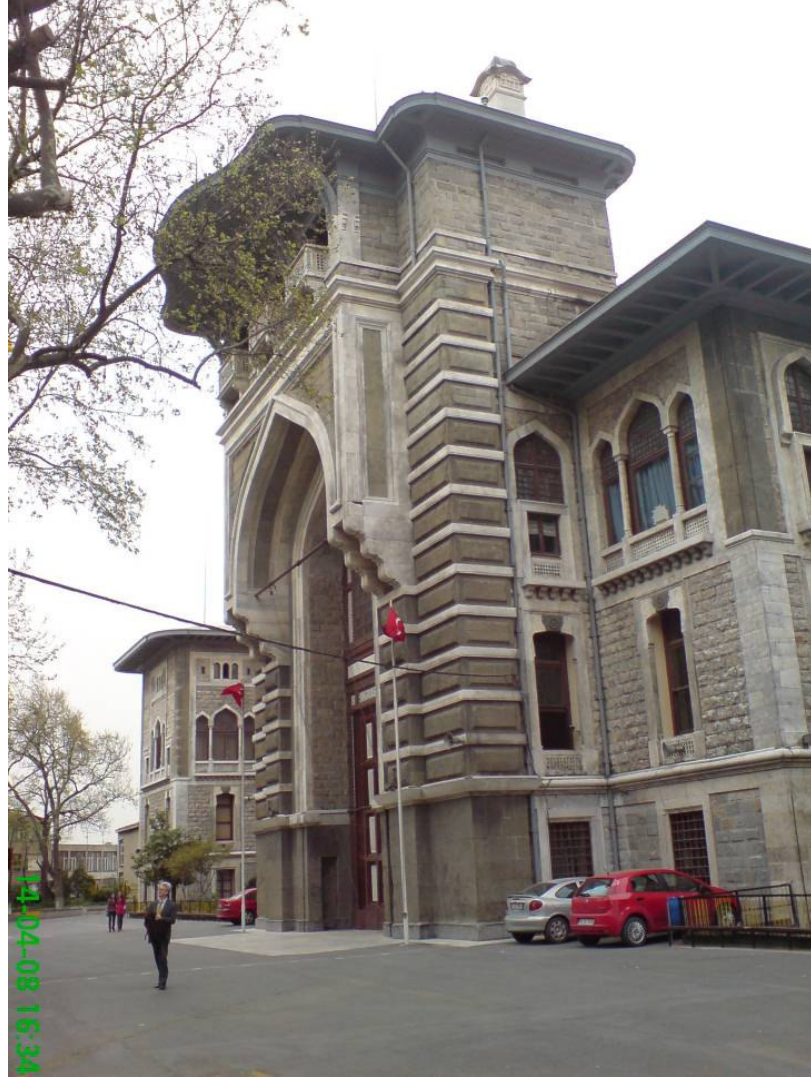
Resim 7.1.5 Alexandre Vallauri'nin tasarladığı Düyun-u Umumiye Binası Ana Giriş Kapısı (Kayaalp)
