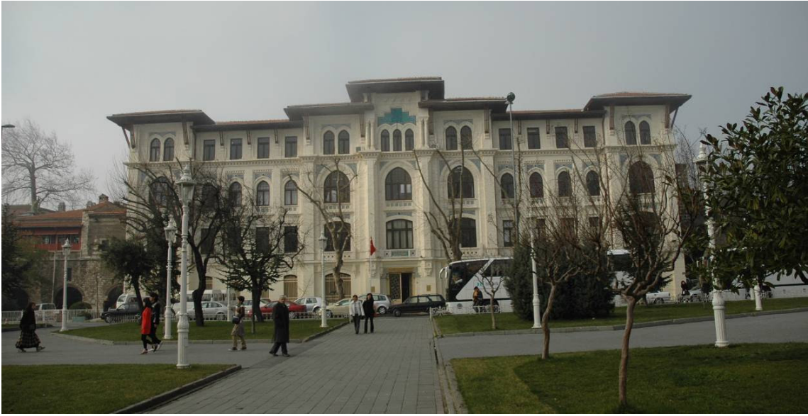
Resim 7.1.4 Defter-i Hakani Binasi (Kayaalp)
