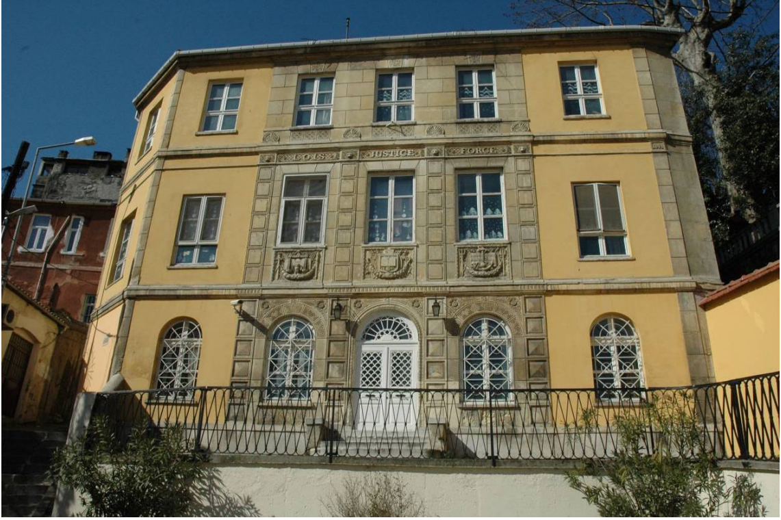
Resim 4.2.2 Fransız Sefareti mahkeme binası (Kayaalp)
