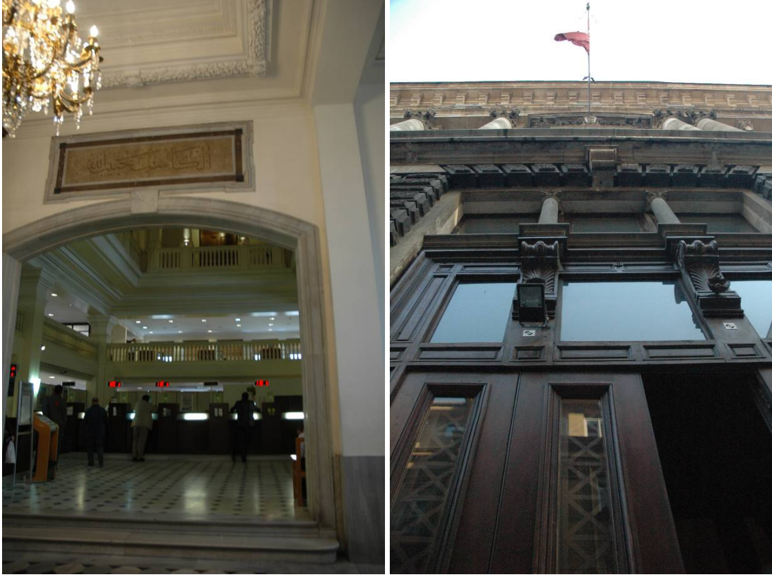
Resim 6.3.2 Osmanlı Bankası Merkez Binası ana hol ve cephe detayları (Kayaalp)
