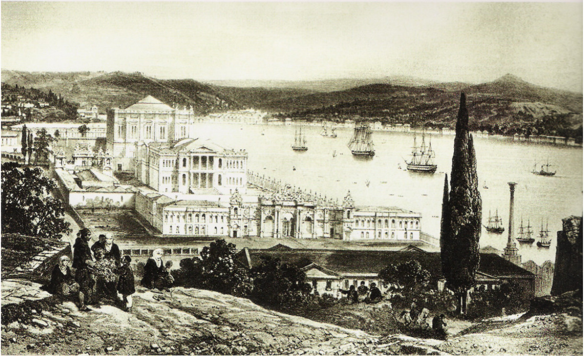
Şekil 4.13. Dolmabahçe Sarayı (Kuban, 1998).
