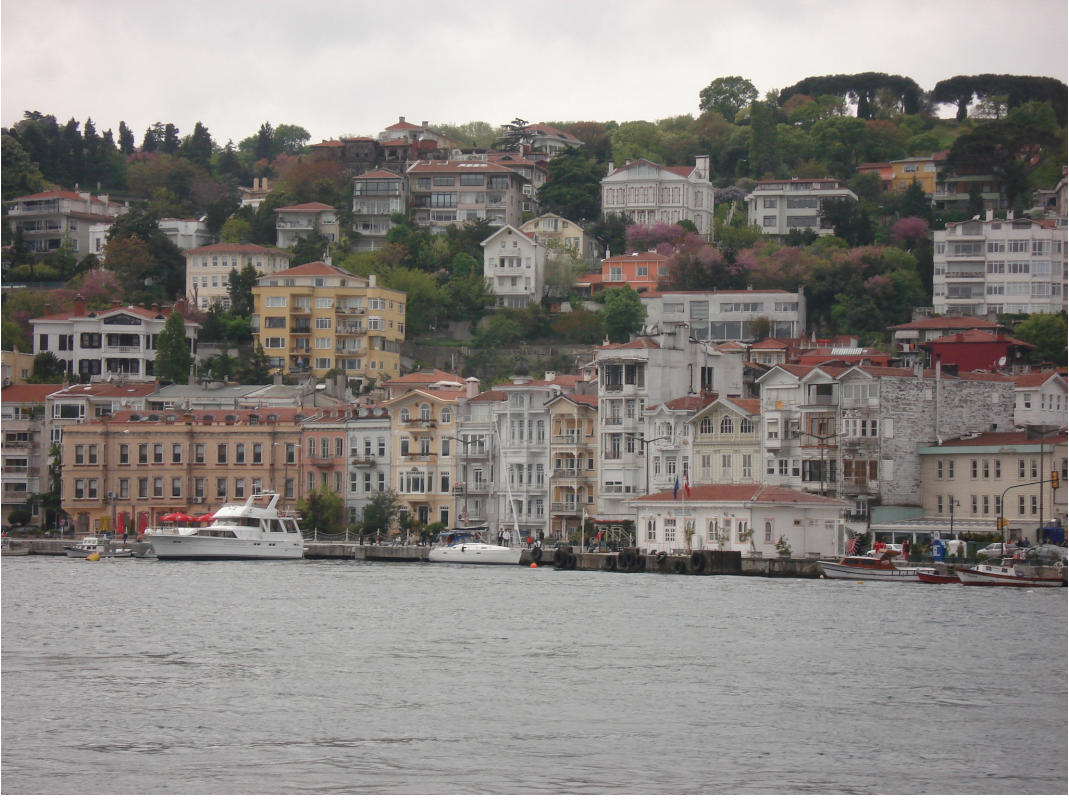
Şekil 4.19. Arnavutköy yalılarının önündeki kazıklı yol (Aksoy, 2006)
