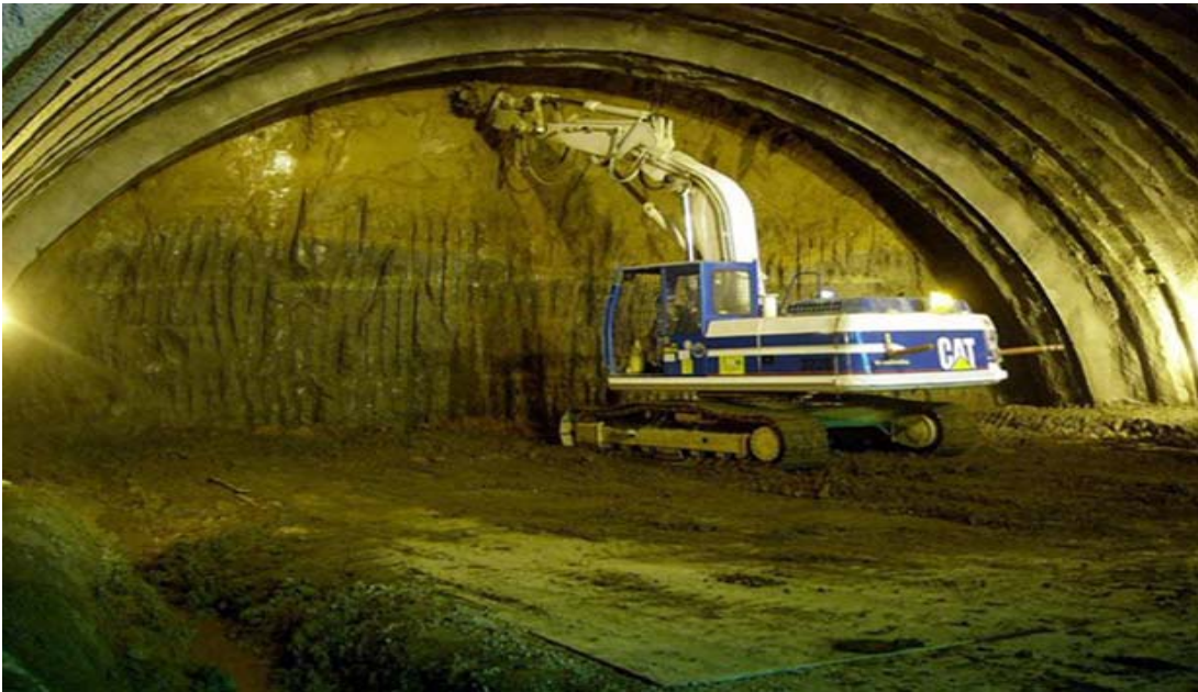
Şekil 2.1 NATM yöntemiyle inşa edilen bir tünel kesiti
