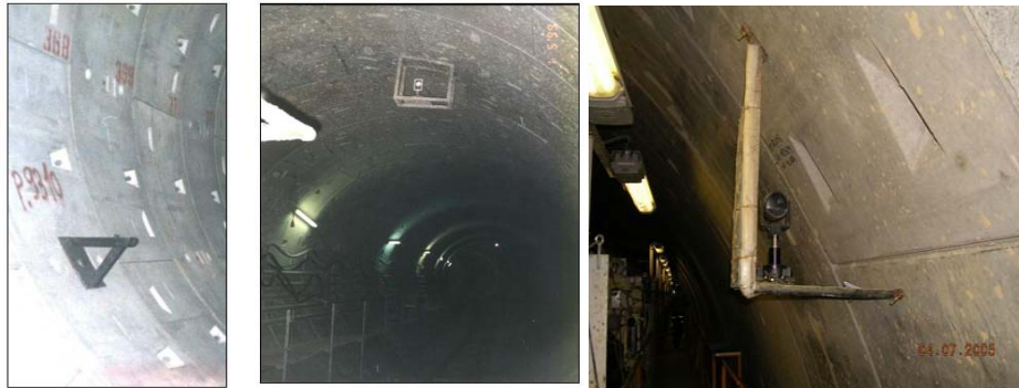
Şekil 3.1 Tünel duvarında değişik yapılarda poligon tesisleri (Ünlütepe, 2005)
