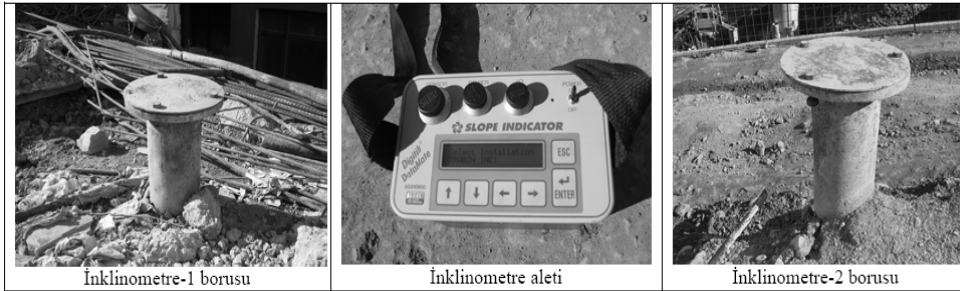
Şekil 4.3 Tünelde tesis edilen inklinometre boruları ve aleti (Yalçınkaya, Satır, 2005)
