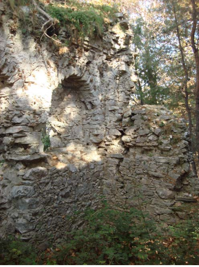
Şekil 120 - Kule, kuzey duvarı, doğu tarafı, içeriden görünüm
