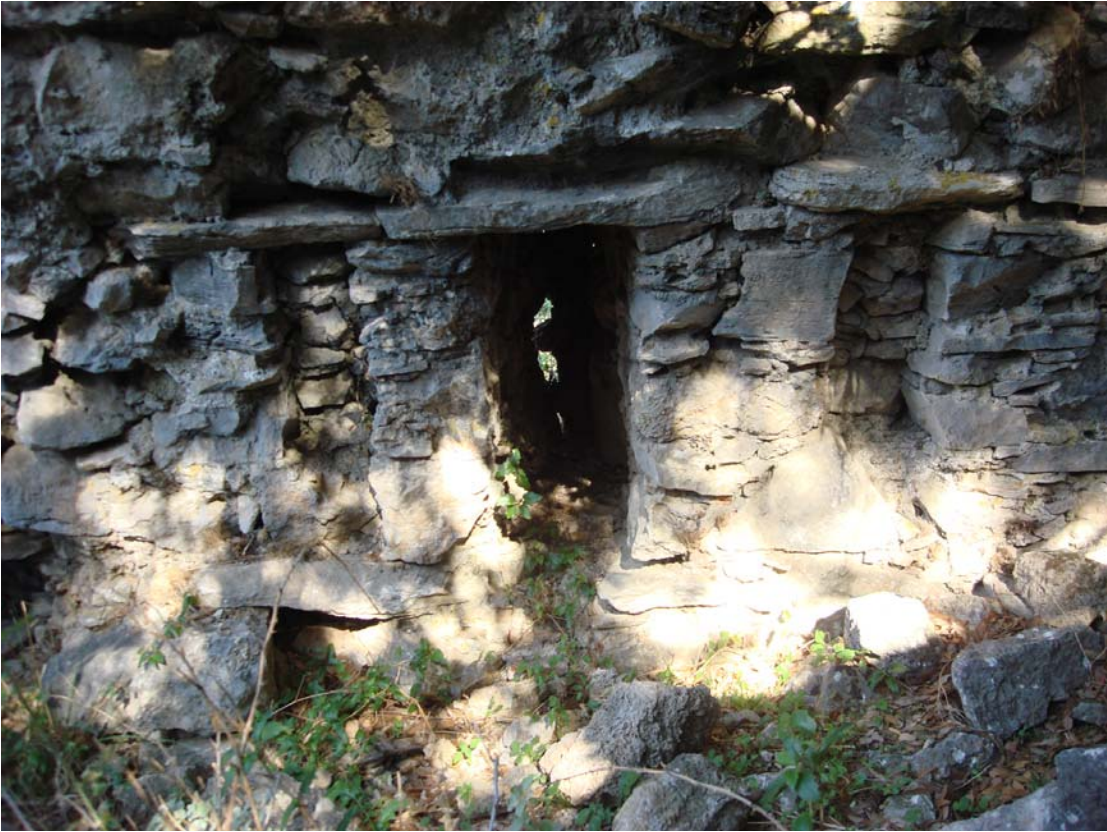
Şekil 135 - Trapeza, kuzey duvarı, pencere ve giriş yuvaları
