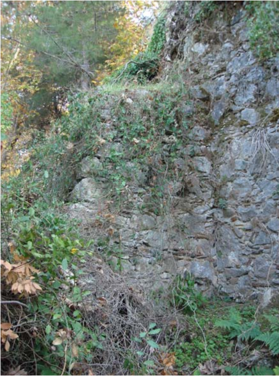
Şekil 21 - Kuzey çevre duvarındaki dördüncü duvar payandası
