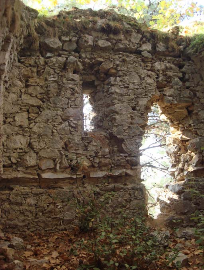
Şekil 124 - Kule, batı duvarı, içeriden görünüm
