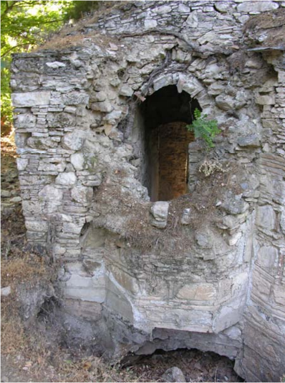
Şekil 67 - Kilise, apsis cephesi, güneydoğu köşesi
