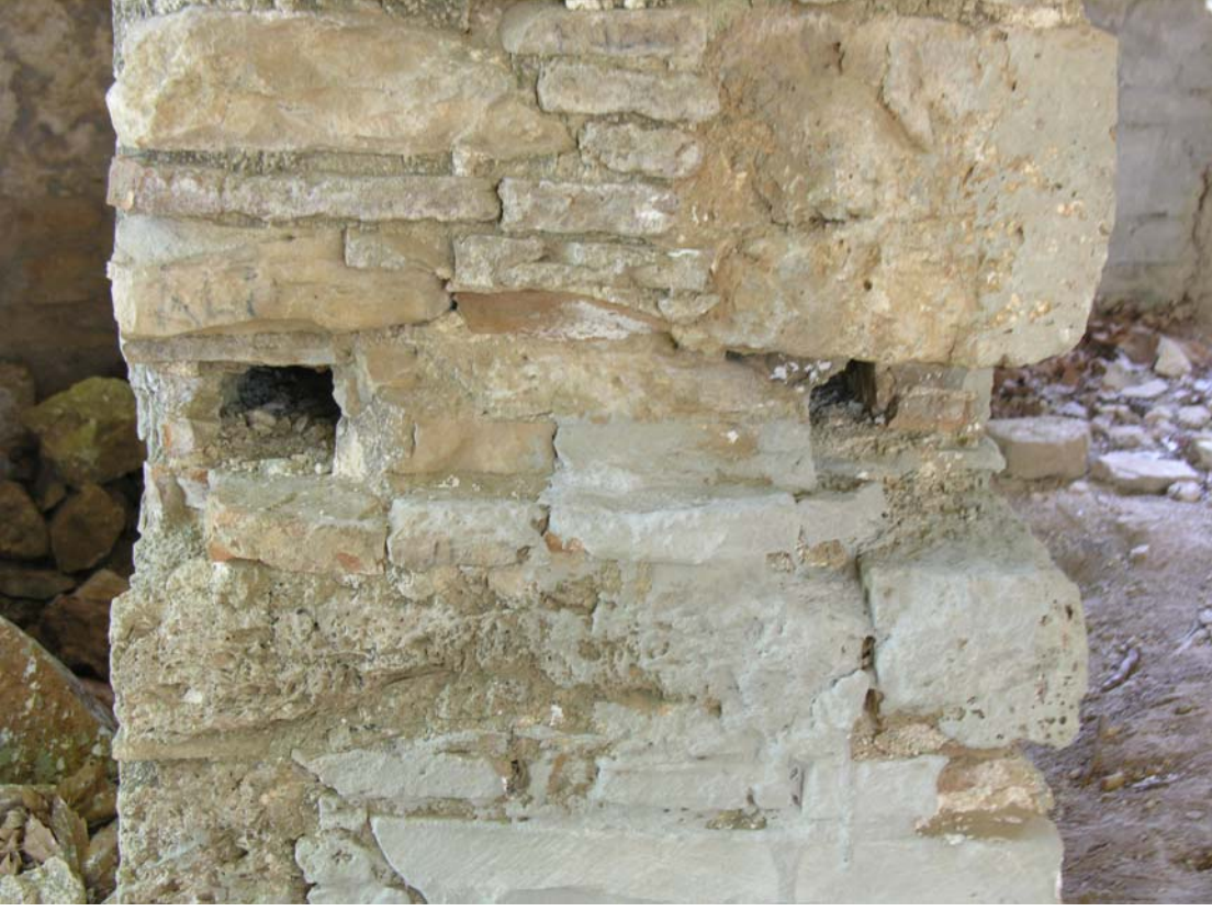
Şekil 58 - Kilise, güneydoğudaki paye, ahşap hatıl yuvaları
