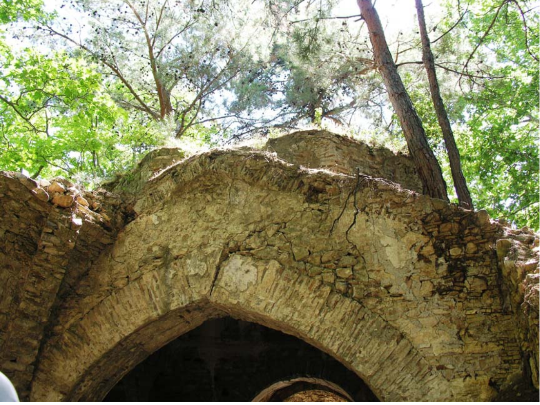
Şekil 96 - Kilise, naosa açılan büyük sivri kemer ve üst yüzeyi
