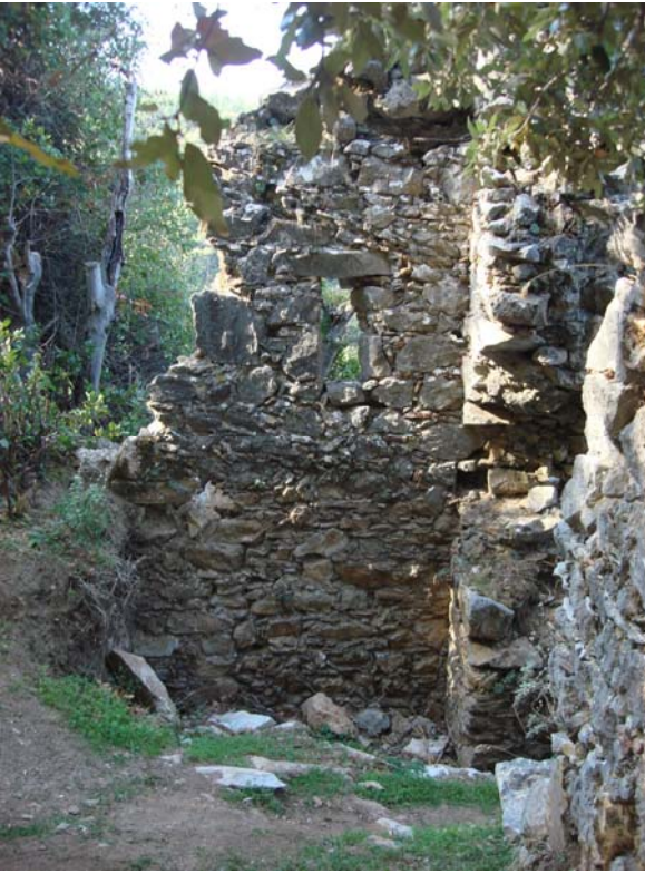
Şekil 141 - Trapeza, girişin önünden devam eden batı duvarı
