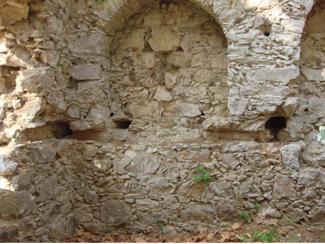
Şekil 126 - Kule, alttaki ahşap hatlı izi
