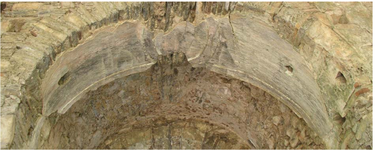
Şekil 57 - Kilise, doğudaki iki payenin üzerine oturan kemer, gergi veahşap hatıl yuvaları
