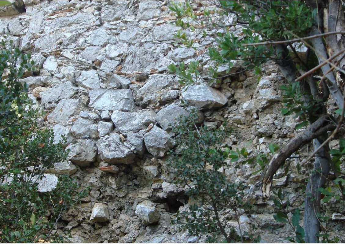
Şekil 31 - Batı çevre duvarı, aynı zamanda yemekhanenin batı duvarı, detay
