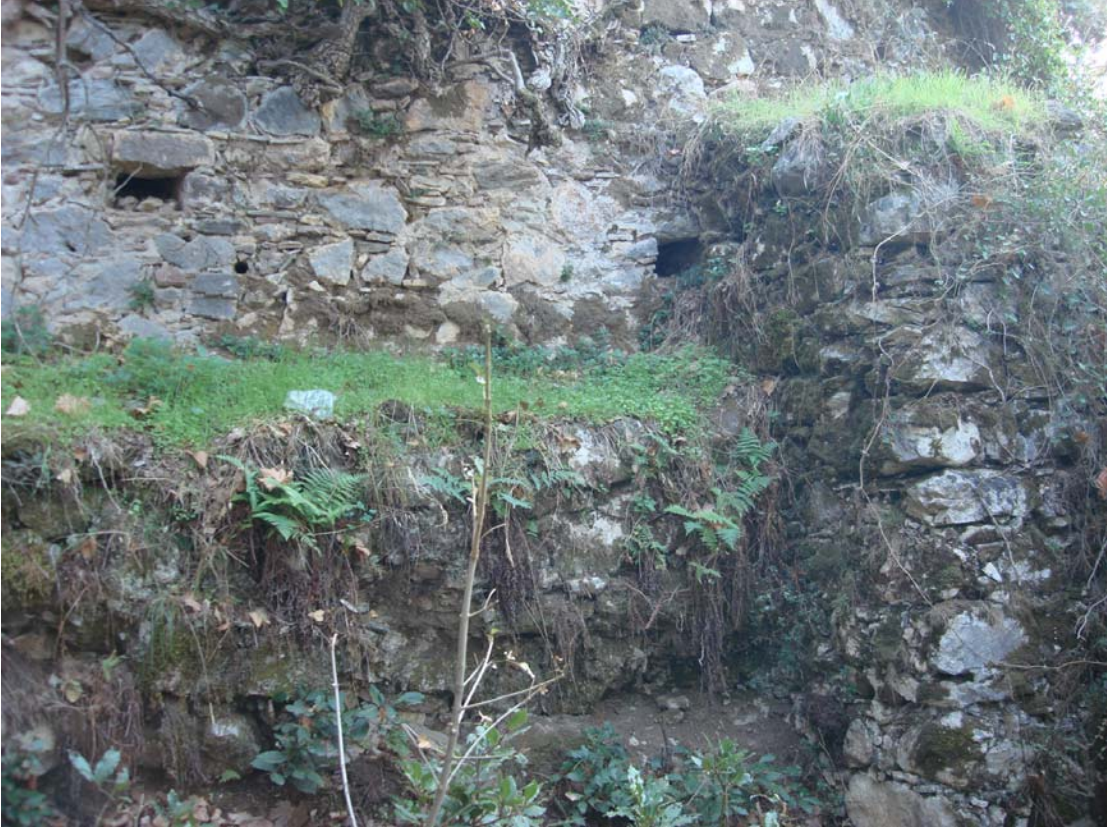
Şekil 22 - Kuzey çevre duvarı önündeki ikinci kademe alçak duvar (set)
