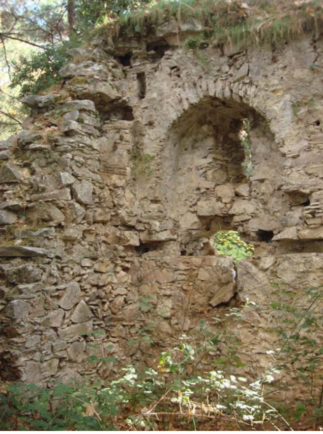
Şekil 118 - Kule, güney duvarı, doğu taraftaki mazgal pencereler
