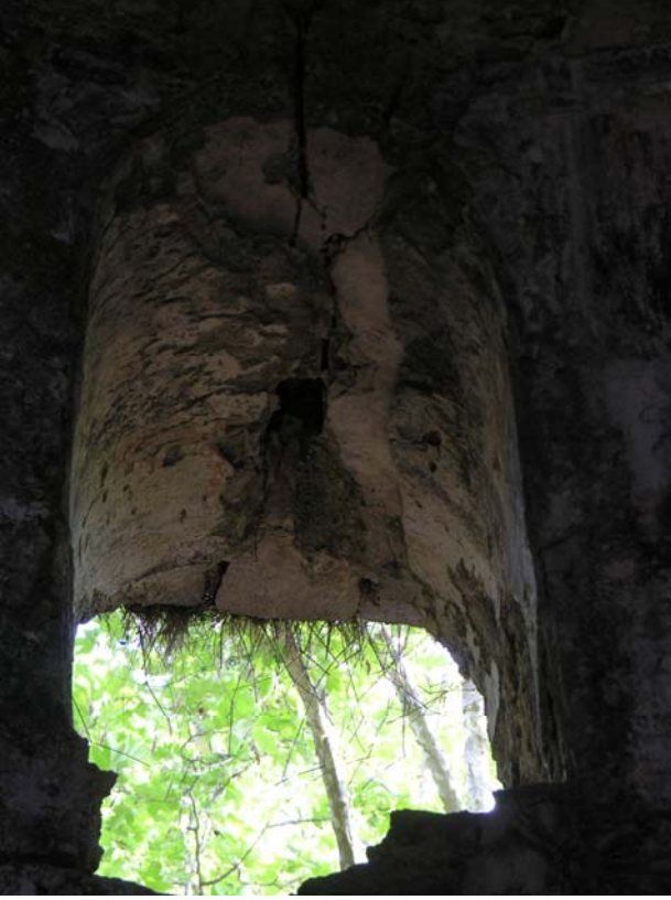
Şekil 78 – Kilise, kubbe kasağı, güneye bakan pencere
