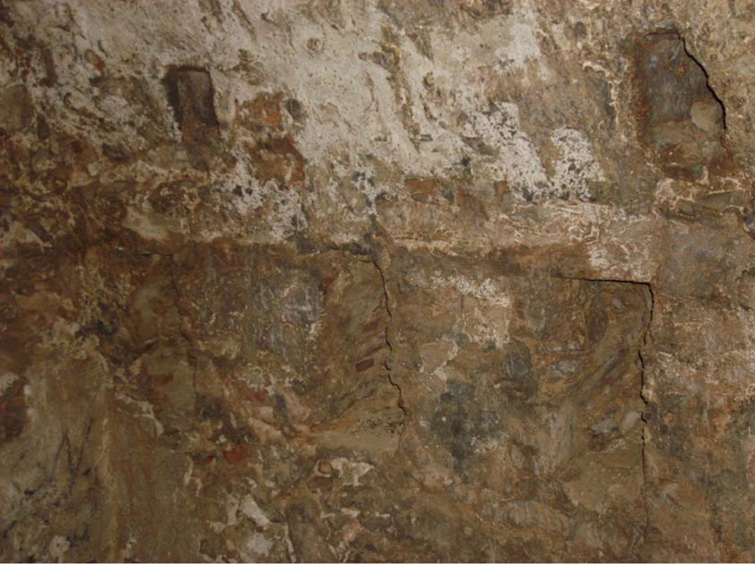
Şekil 112 - Kule, zemin kat, kuzey duvarındaki nişler ve hatıl yuvaları
