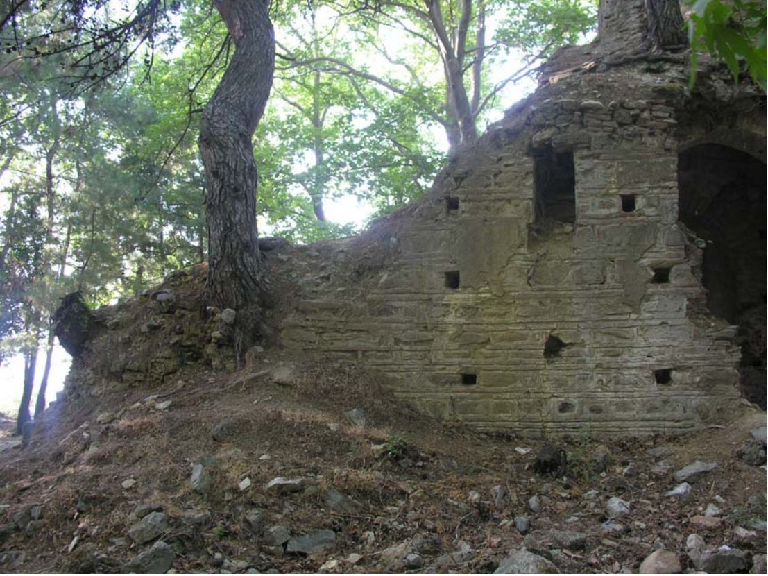
Şekil 73 - Kilise, güney cephesi, batı tarafındaki özgün duvar dokusu
