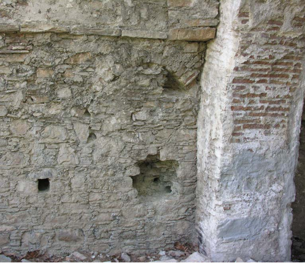
Şekil 49 – Batı giriş mekanı, kuzey duvarı, kapatılan kemerli açıklık
