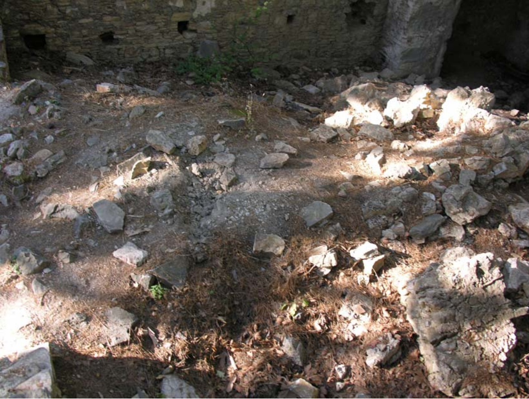
Şekil 93 - Kilise, batı giriş mekanı, zemindeki toprak ve moloz yığı
