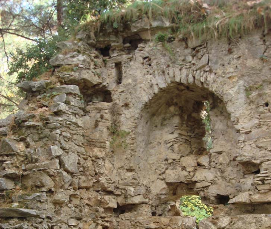
Şekil 129 - Kule, kuzey duvarı, ahşap hatıl yuvaları
