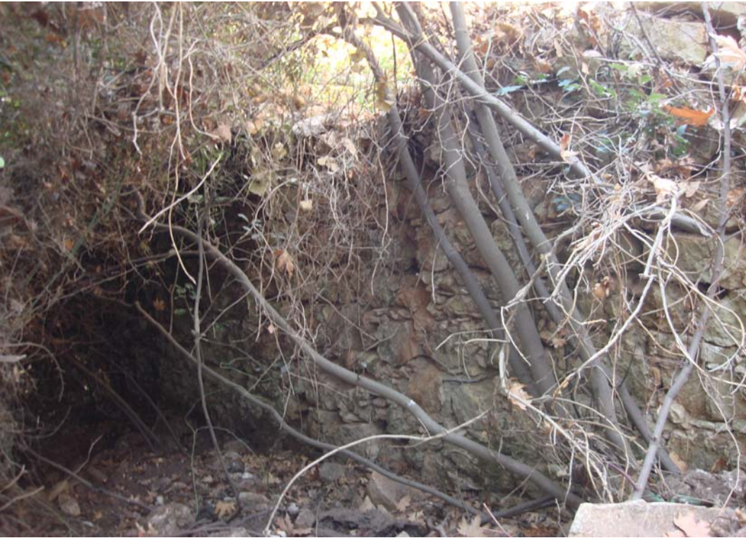
Şekil 5 - Güney çevre duvarı, batı bölümü
