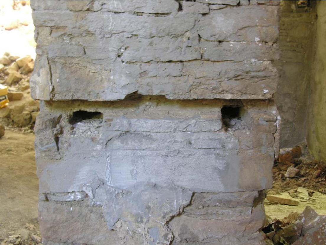
Şekil 59 - Kilise, kuzeydoğudaki paye, ahşap hatıl yuvaları
