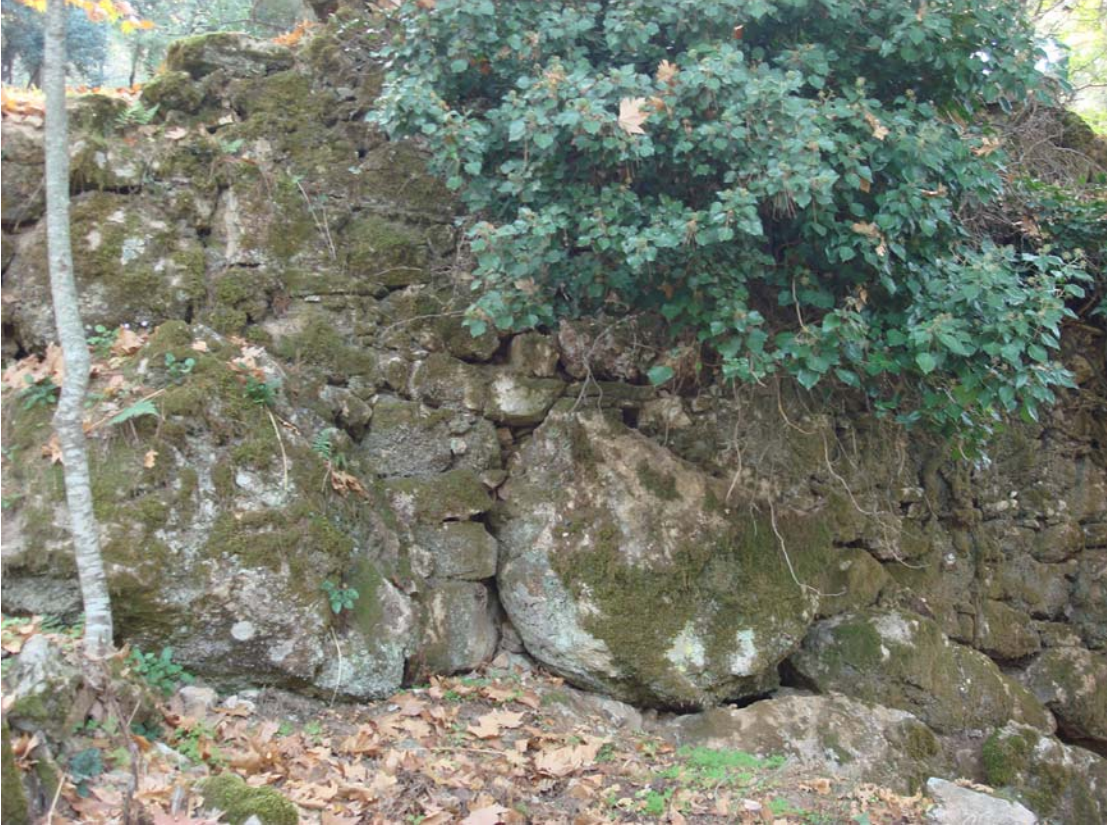
Şekil 30 - Güney çevre duvarı, içten görünüm
