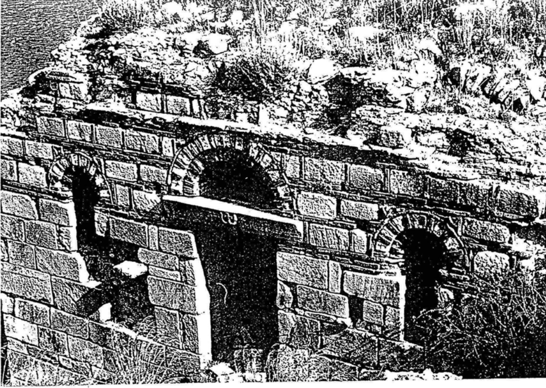
Ek 4 - İkiz Ada, 4 no.lu Kilise, Batı Cephe (Mercangöz, 1985)
