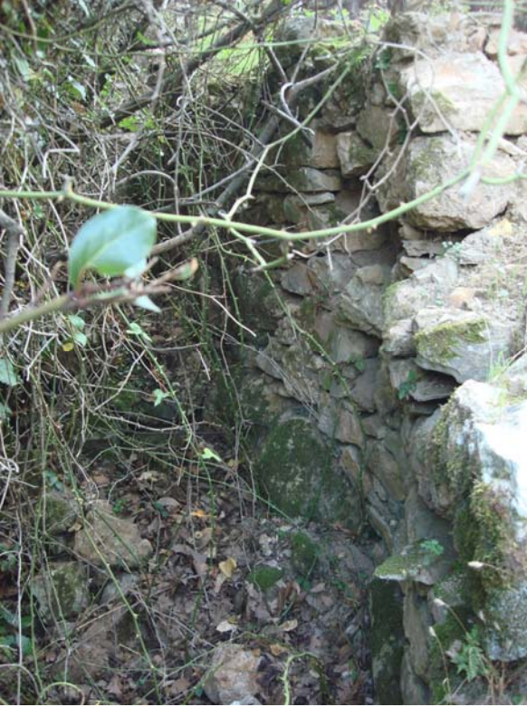
Şekil 9 - Doğu çevre duvarı, dışarıdan görünüm
