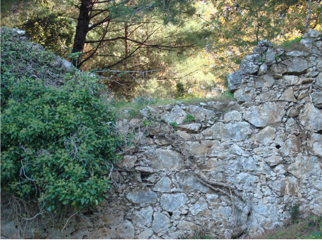
Şekil 164 - 14 no.lu hücre, batı duvarı, batıdan görünüm
