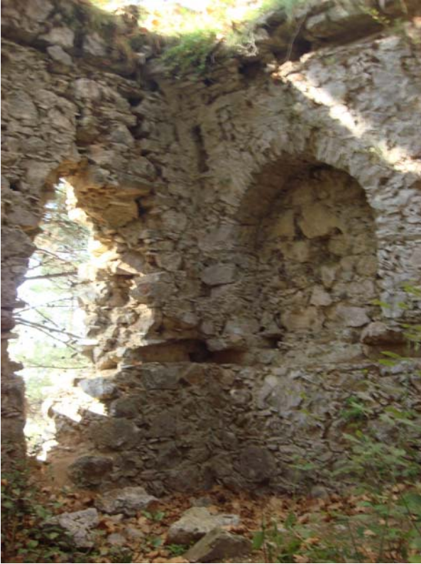
Şekil 121 - Kule, kuzey duvarı, batı tarafı, içeriden görünüm
