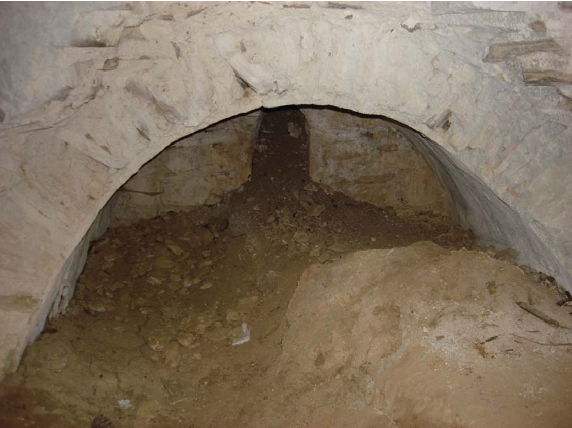
Şekil 183 - Mezar şapeli, alt kat kuzey duvarı, batıdan üçüncü mezar nişi
