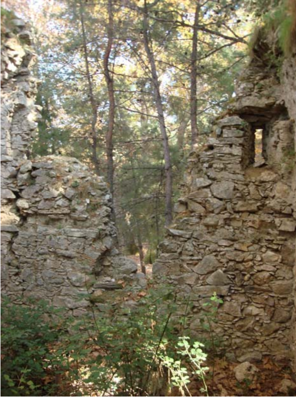
Şekil 119 - Kule, doğu duvarı, içeriden görünüm
