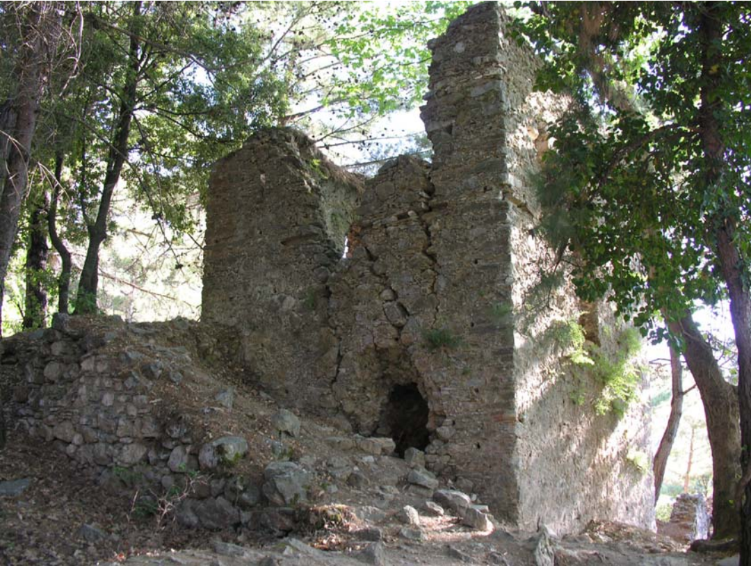
Şekil 109 - Kule, platforma çıkan rampa, kuzeydoğudan görünüm
