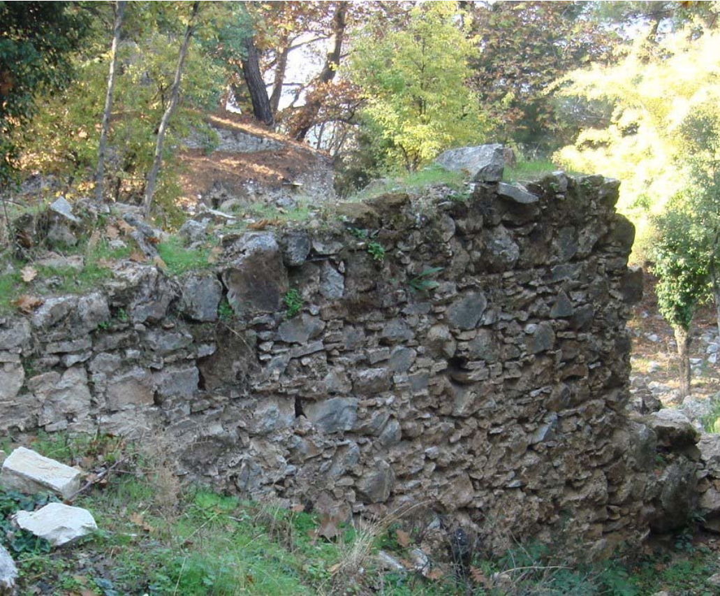
Şekil 27 - Doğu çevre duvarı, detay
