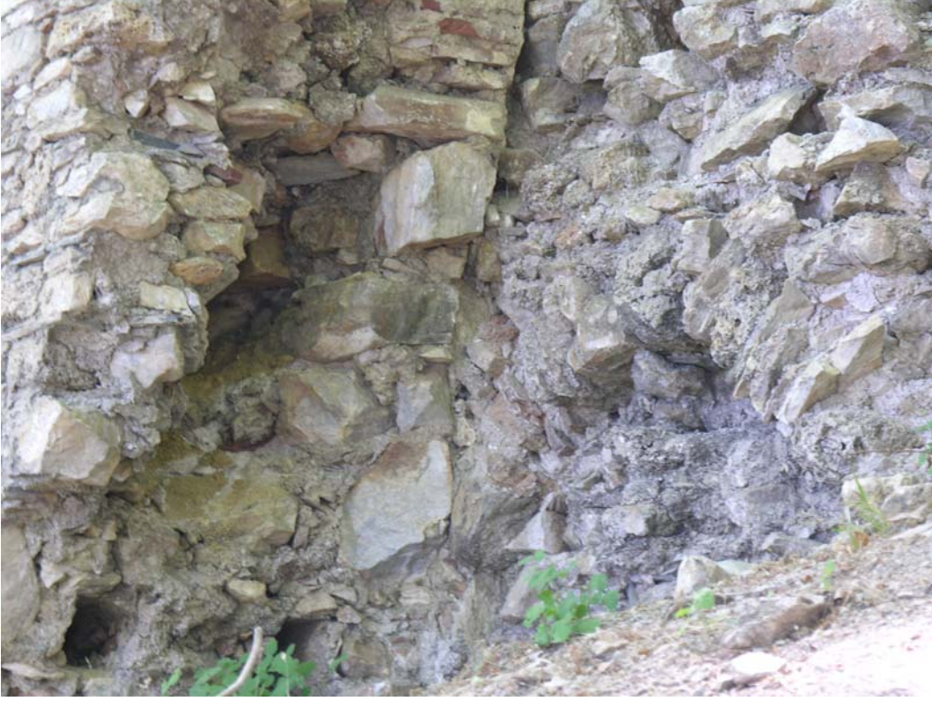
Şekil 48 - Kilise, kuzey duvarı, kapatılan kemerli açıklık
