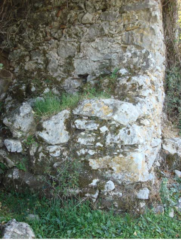
Şekil 18 - Kuzey çevre duvarındaki birinci duvar payandası, detay
