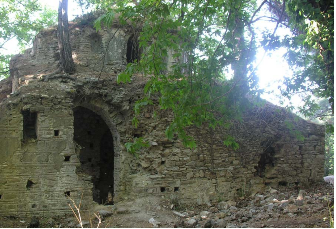
Şekil 72 - Kilise, güney cephesi, özgün duvar dokusu
