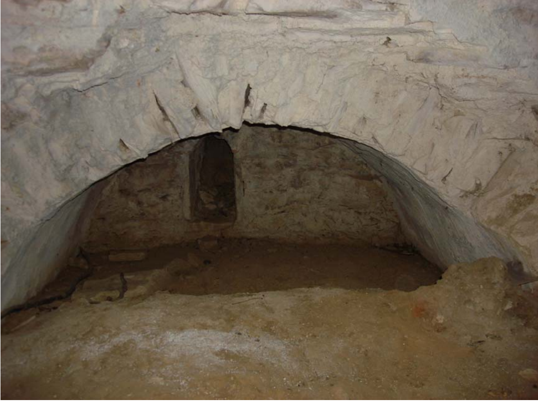
Şekil 188 - Mezar şapeli, alt kat güney duvarı, batıdan üçüncü mezar nişi
