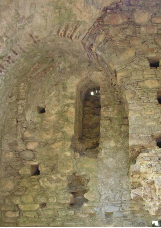
Şekil 39 - Naos, kuzey duvarı, pencere
