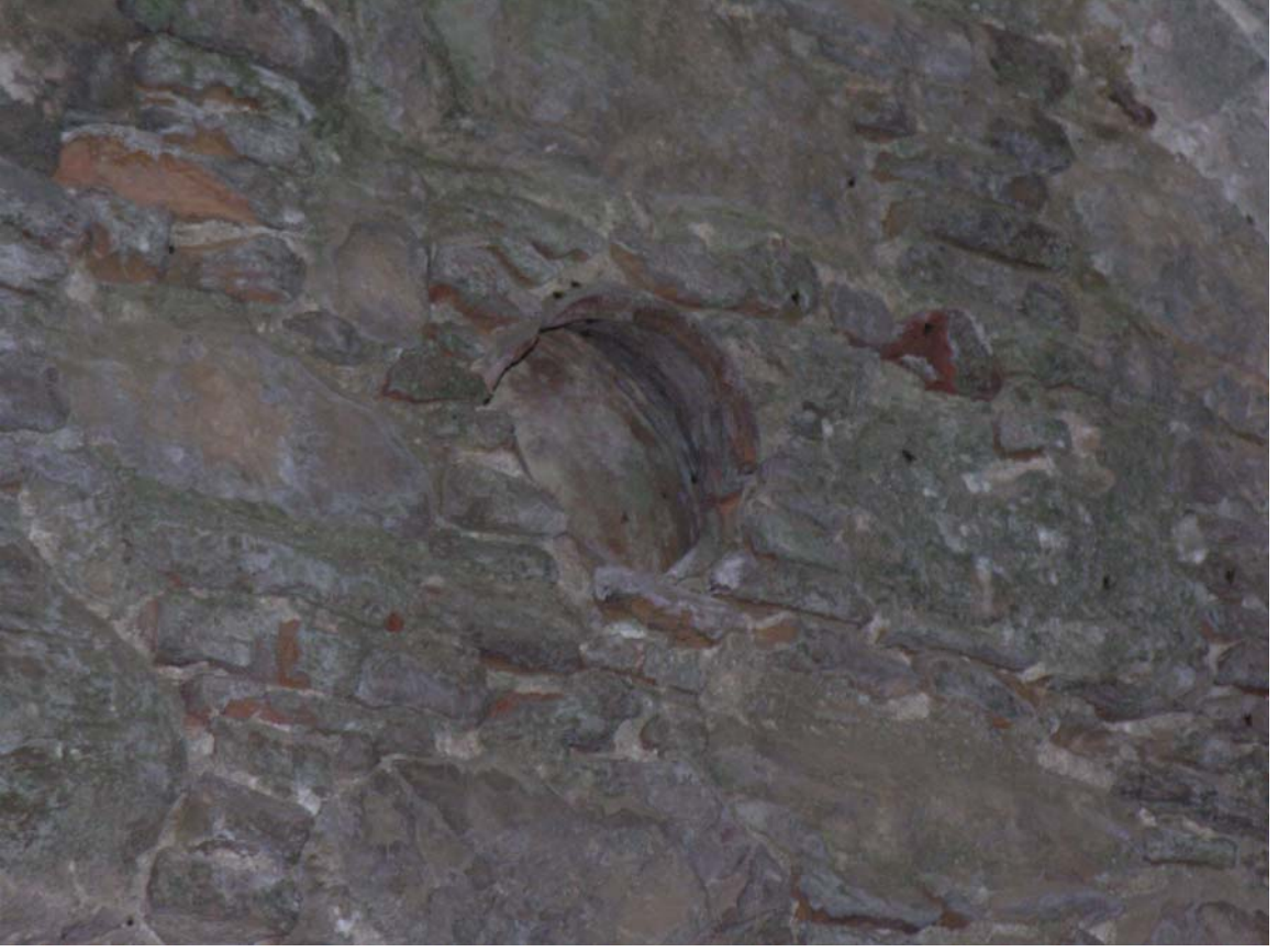
Şekil 42 - Naos, kuzey duvarı, kırık küp
