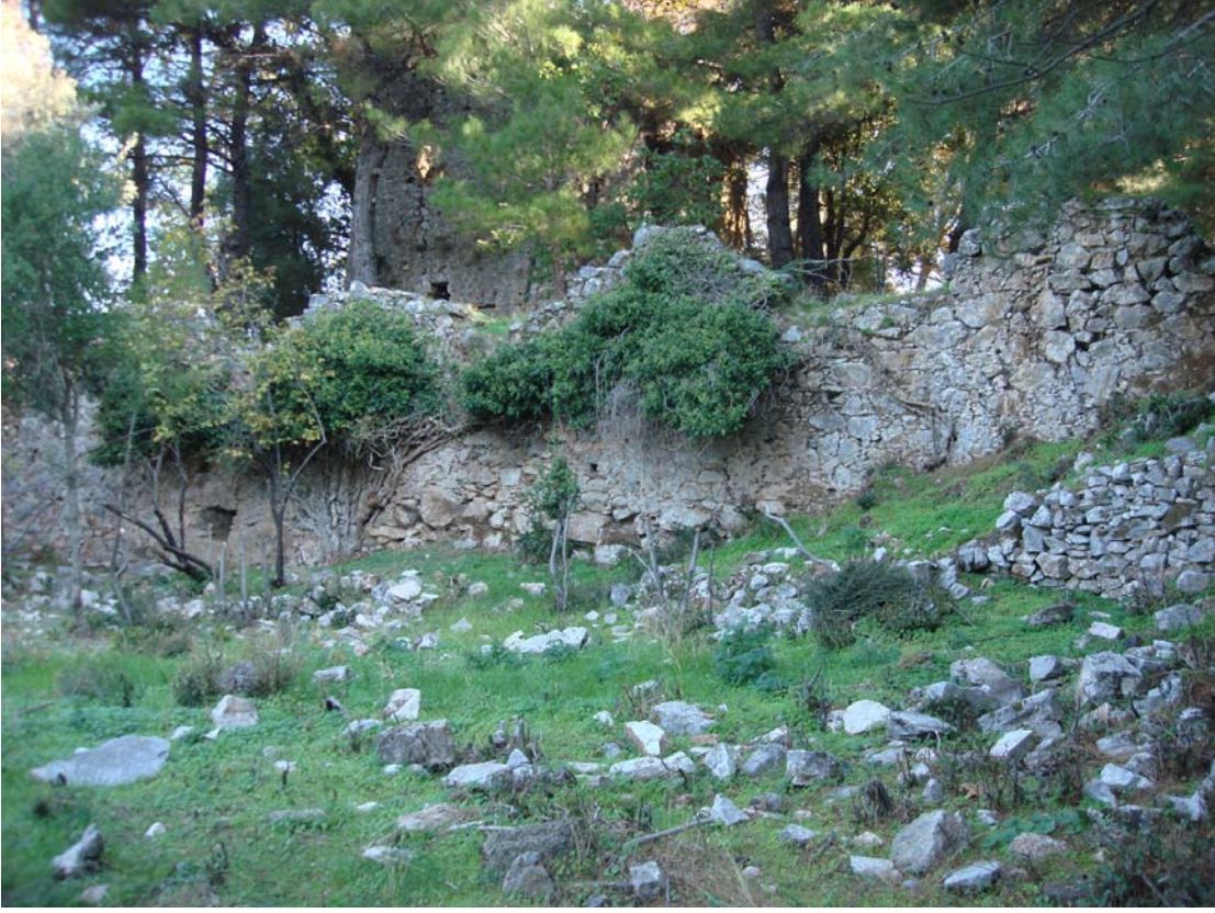
Şekil 158 - Batı hücrelerinin ortak duvarı, batıdan görünüm
