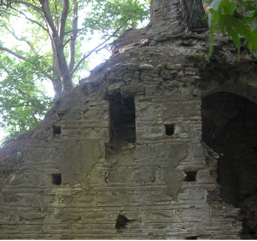
Şekil 74 - Kilise, güney cephesi, batı taraftaki içten kapalı pencere
