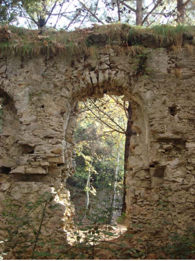
Şekil 116 - Kule, giriş duvarı, içeriden
