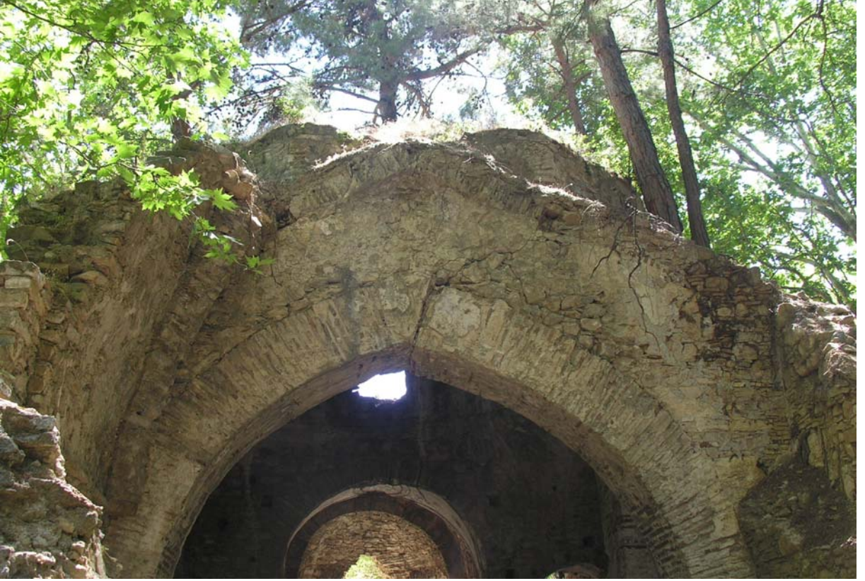
Şekil 70 - Kilise, batı giriş mekanı tonozu
