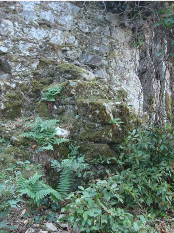
Şekil 19 - Kuzey çevre duvarındaki ikinci duvar payandası
