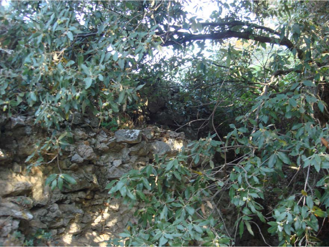
Şekil 133 - Trapeza, kuzey duvarı, kat izi
