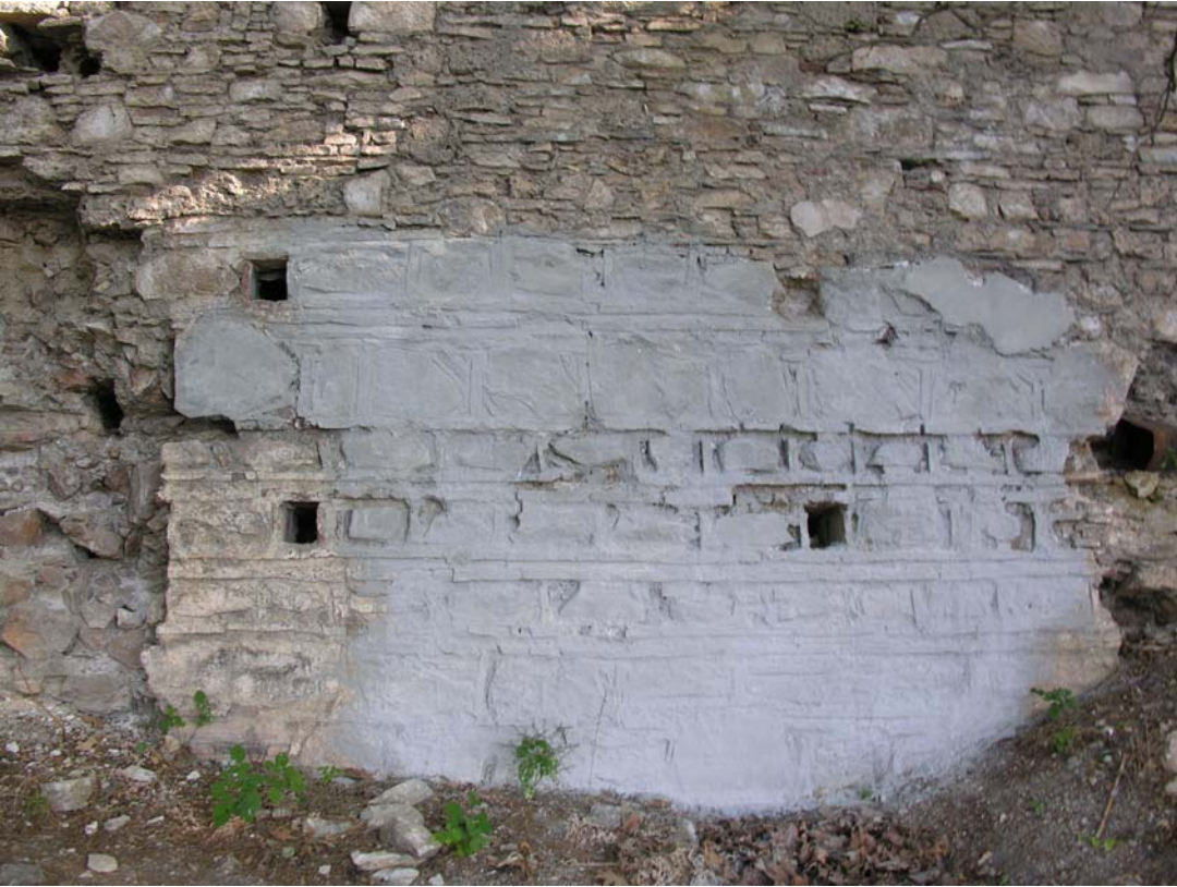
Şekil 45 - Kilise, kuzey duvarı, özgün doku
