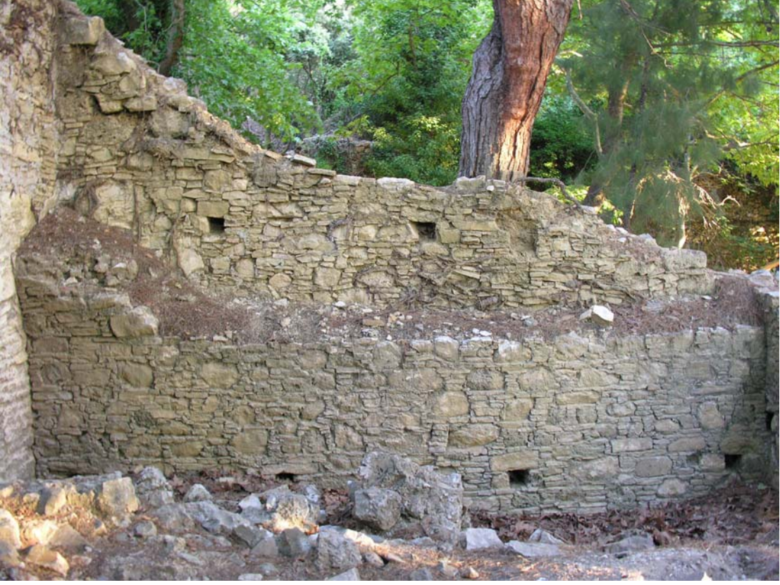
Şekil 98 - Kilise, batı giriş mekanı, güney duvarı
