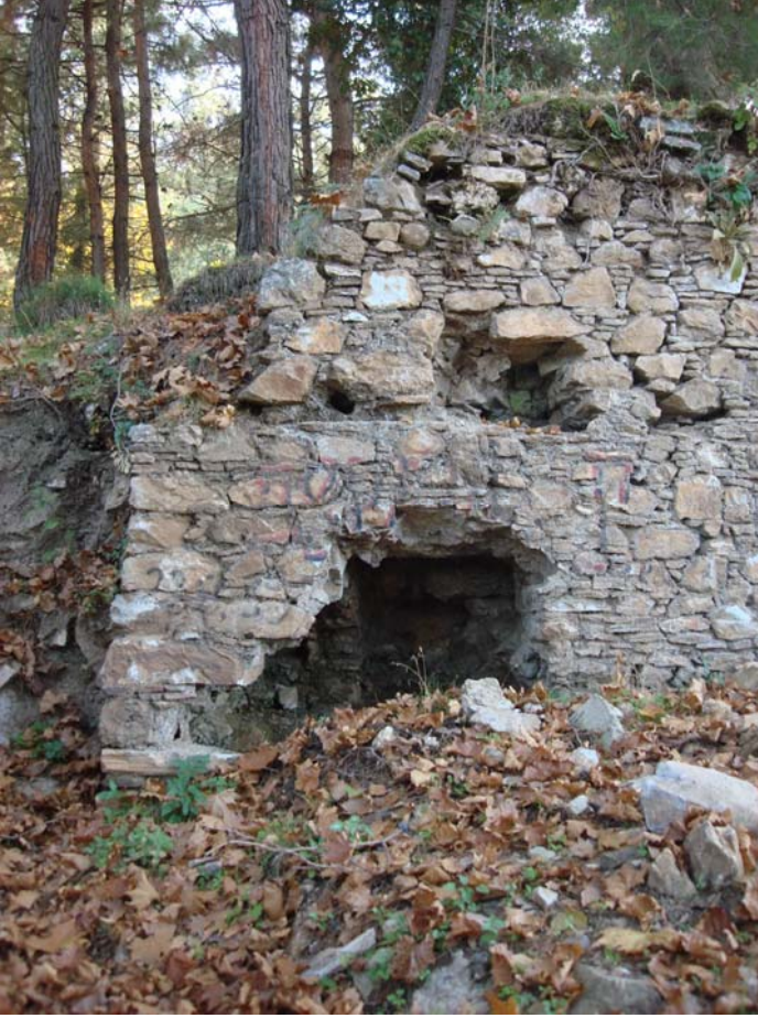
Şekil 24 - 3, 9 ve 10 no.lu mekanların kuzeydeki ortak duvarı
