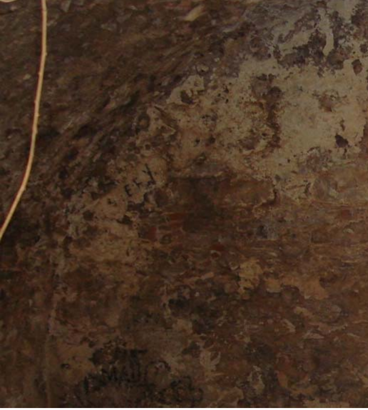
Şekil 114 - Kule, zemin kat, batı duvarındaki niş
