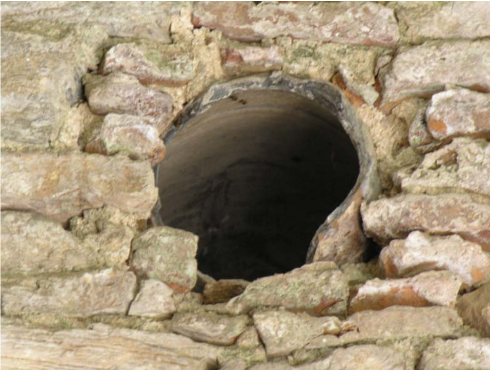
Şekil 41 - Naos, kuzey duvarı, kırık küp
