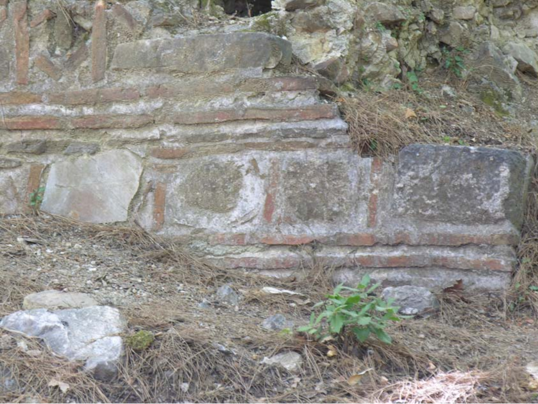
Şekil 103 - Kilise, batı duvarı, özgün duvar dokusu
