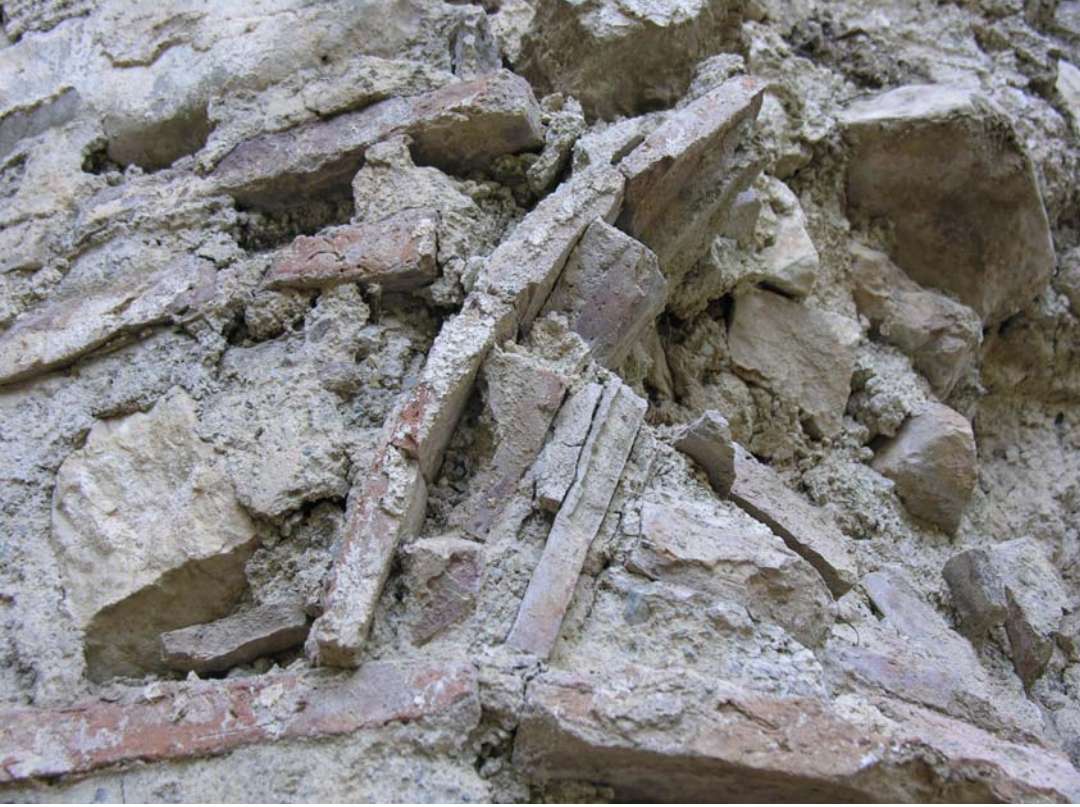
Şekil 64 - Kilise, apsis cephesi, kuzeydeki pencere, detay
