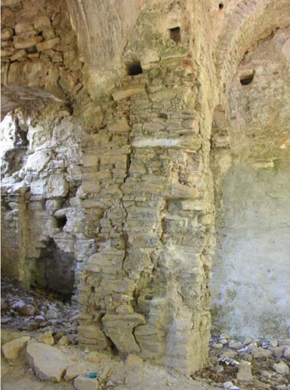
Şekil 55 - Kilise, güneydoğudaki paye
