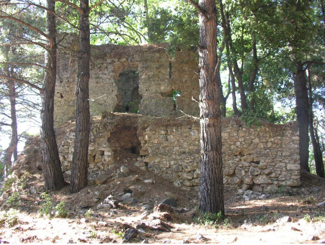
Şekil 108 - Kule, giriş platformu, güneyden görünüm
