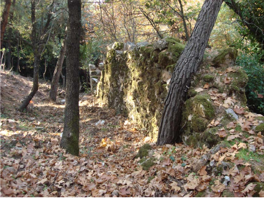
Şekil 4 - Güney çevre duvarı, güneydoğudan görünüm
