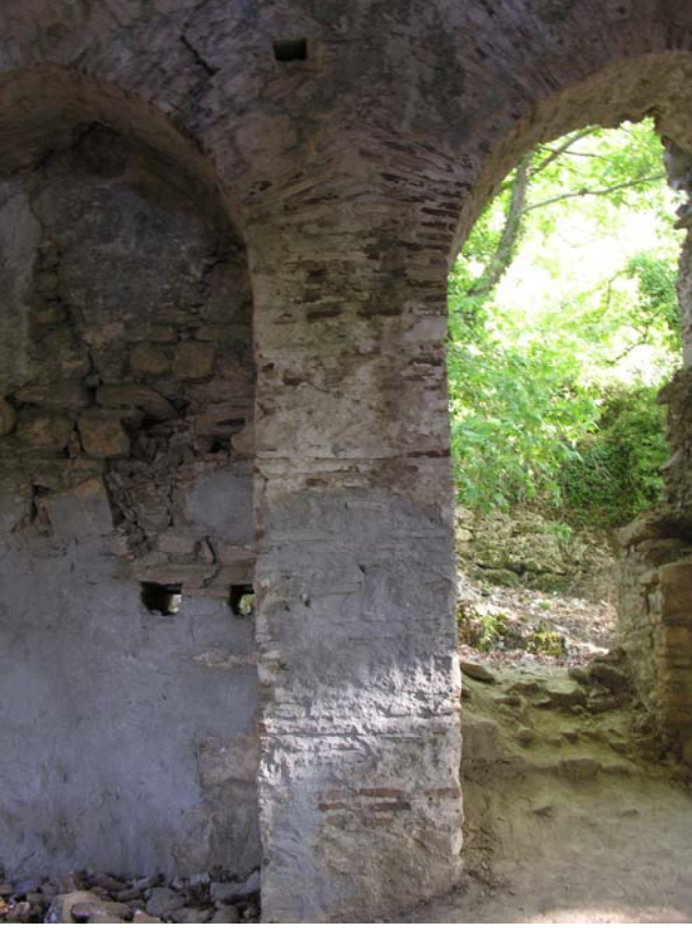
Şekil 106 - Kilise, güney duvar payesi
