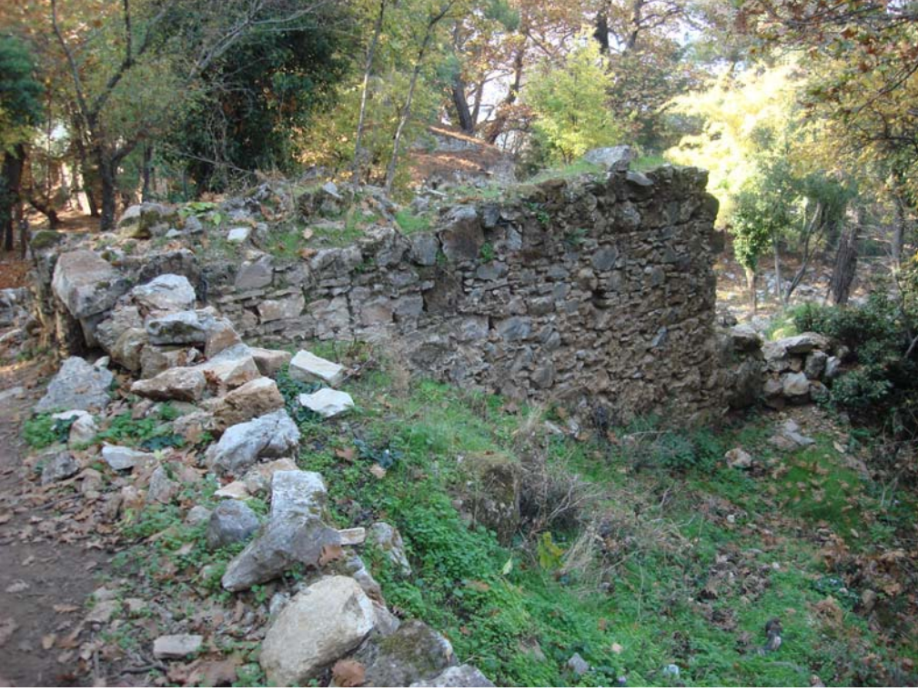
Şekil 10 - Doğu çevre duvarı, dışarıdan görünüm
