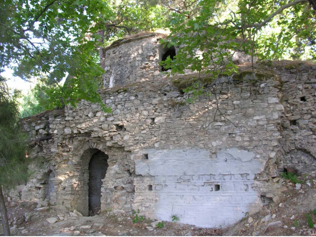
Şekil 44 - Kilise, kuzey duvarı
