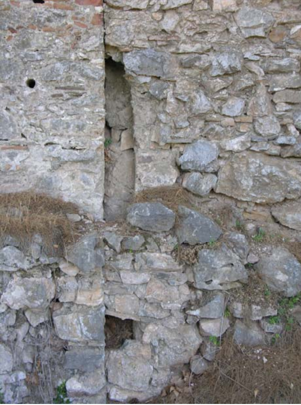
Şekil 125 - Kule, platformla birleştiği yerdeki set ve kanal
