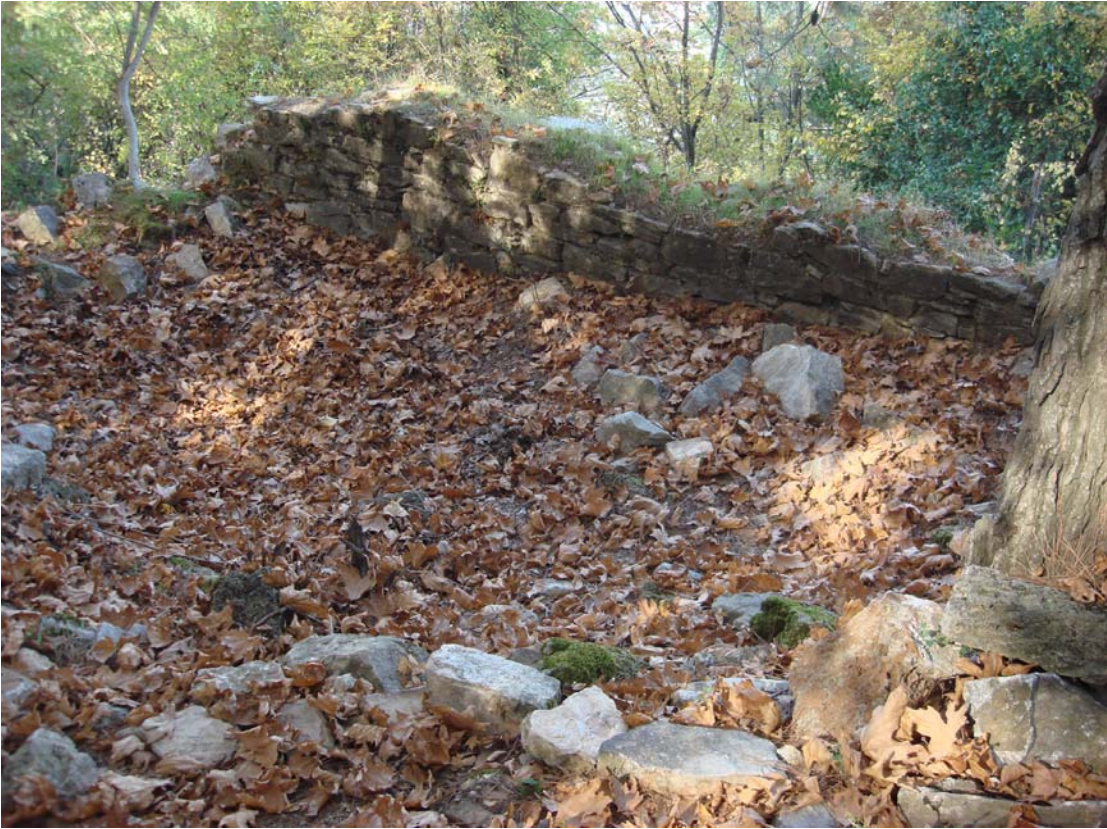
Şekil 151 - 7 no.lu hücre, kuzey duvarı, güneydoğudan görünüm
