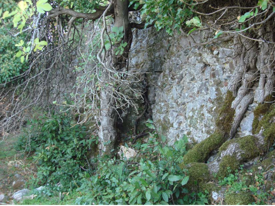
Şekil 16 - Kuzey çevre duvarı, batı bölümü, aynı zamanda yemekhanenin de kuzey duvarı
