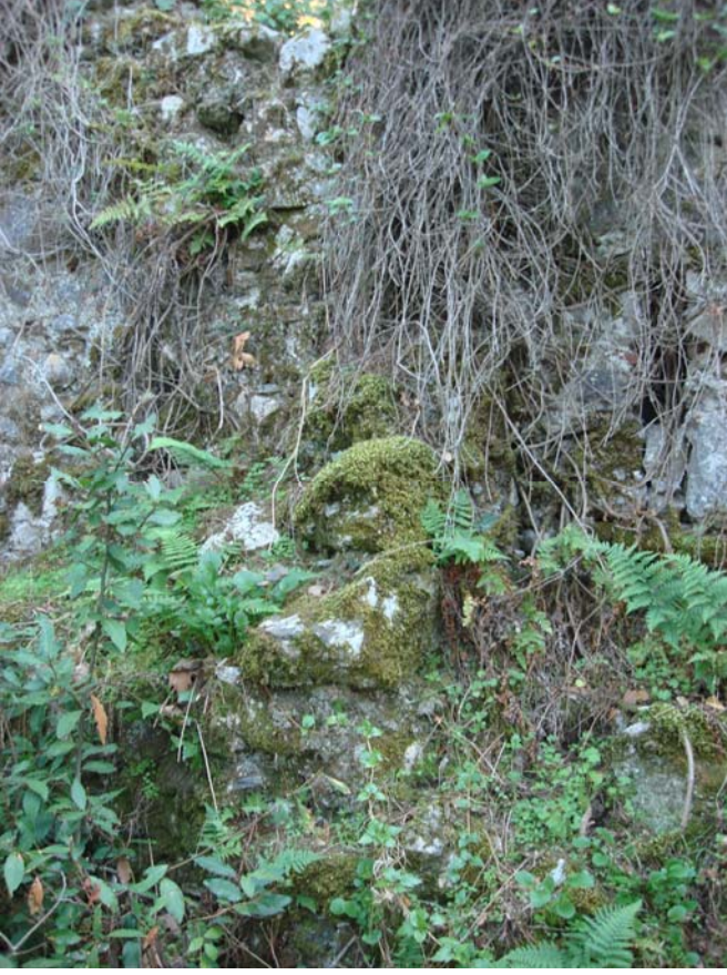
Şekil 20 - Kuzey çevre duvarındaki üçüncü duvar payandası
