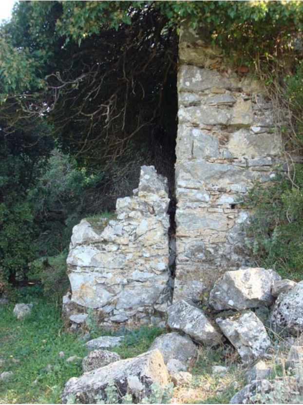
Şekil 17 - Kuzey duvarındaki birinci duvar payandası
