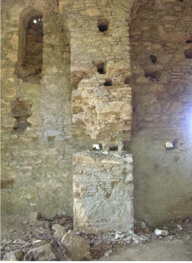
Şekil 38 - Naos, kuzey duvarı, duvar payesinin hatıl yuvaları
