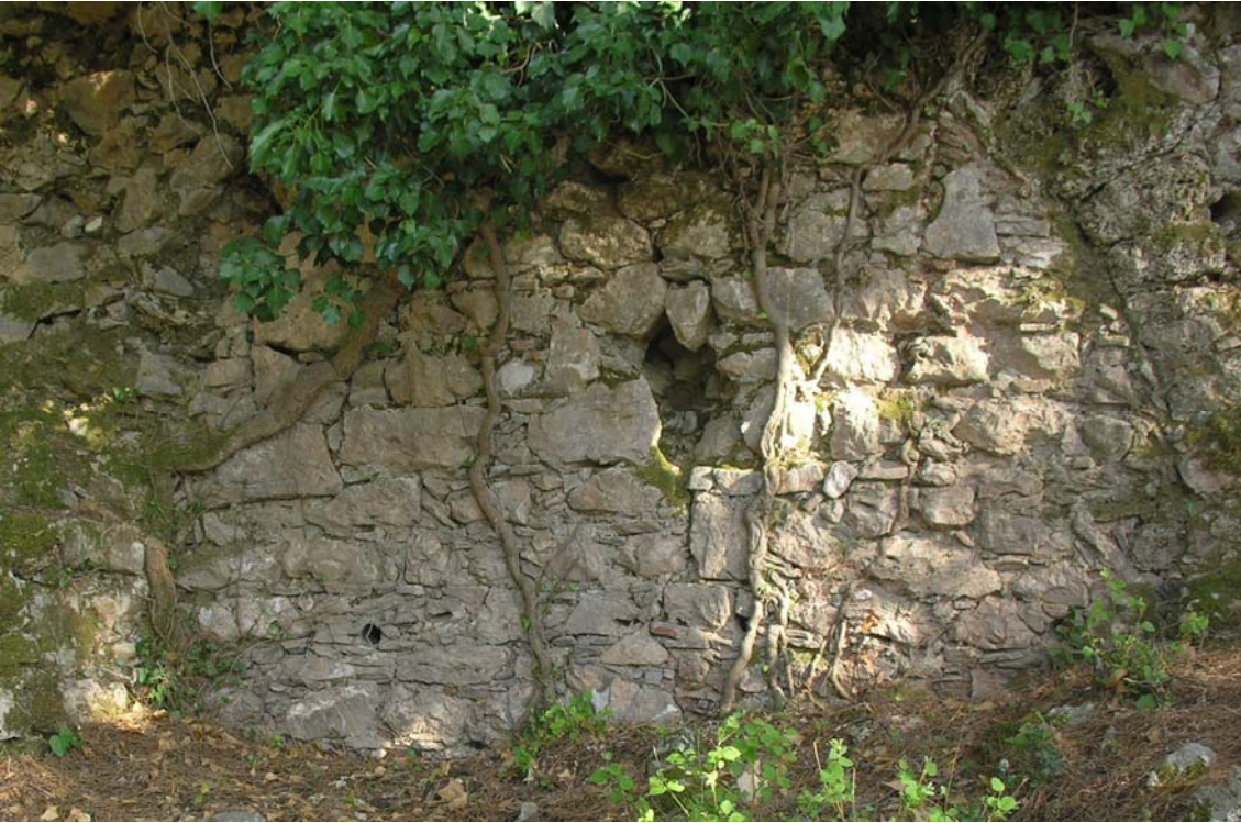
Şekil 29 - Güney çevre duvarı, detay
