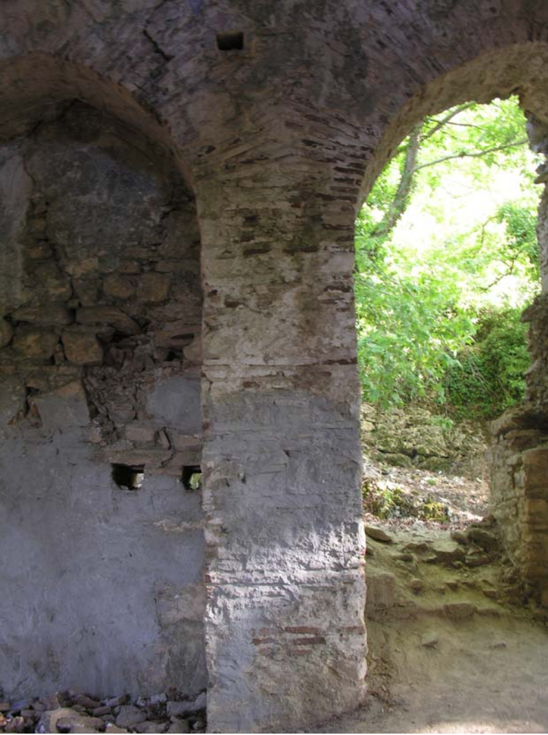
Şekil 69 - Naos, güney duvarı, sivri kemerler ve duvar payesi
