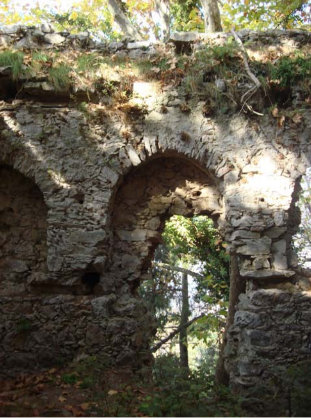
Şekil 122 - Kule, kuzey duvarı, içeriden görünüm
