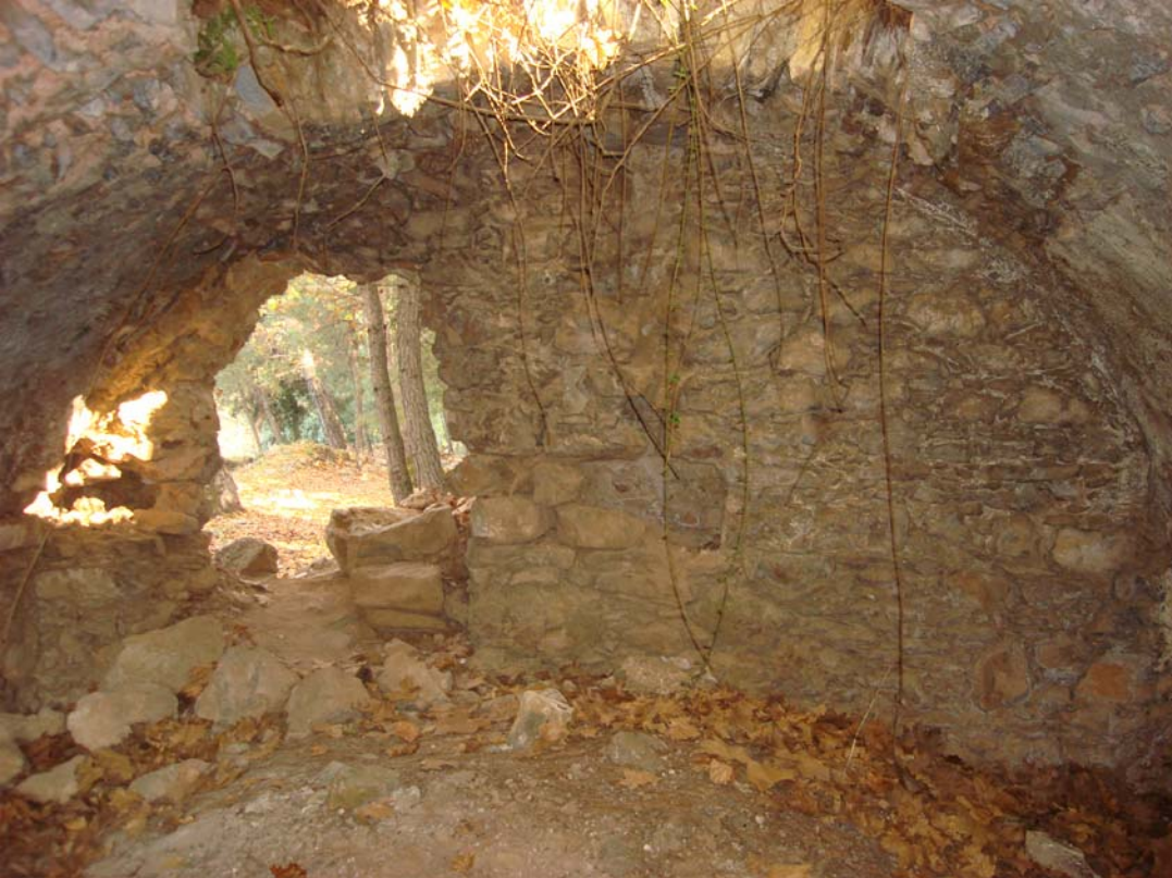
Şekil 115 - Kule, zemin kat, doğu duvarı
