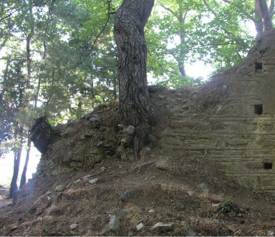
Şekil 75 - Kilise, güney cephesi, batı tarafı
