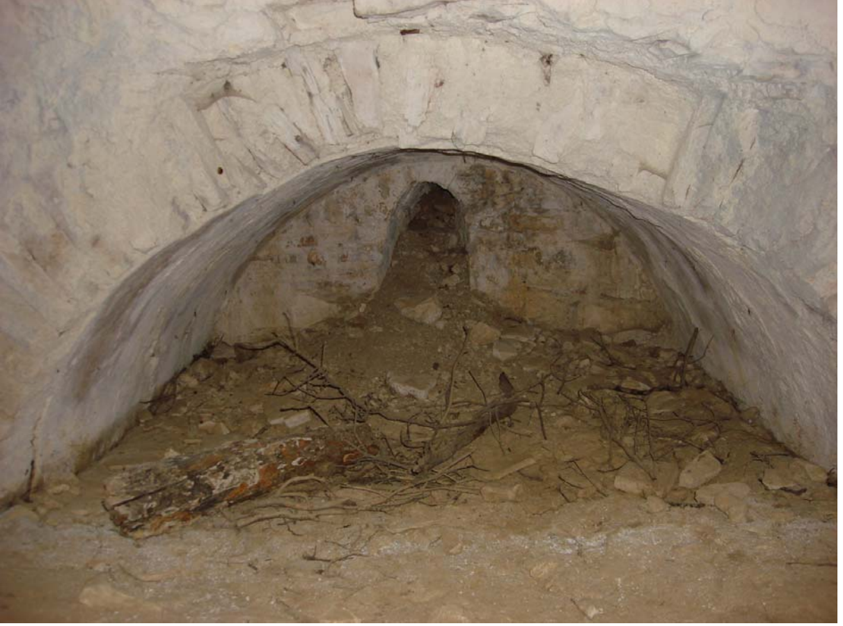
Şekil 184 - Mezar şapeli, alt kat kuzey duvarı, batıdan dördüncü mezar nişi
