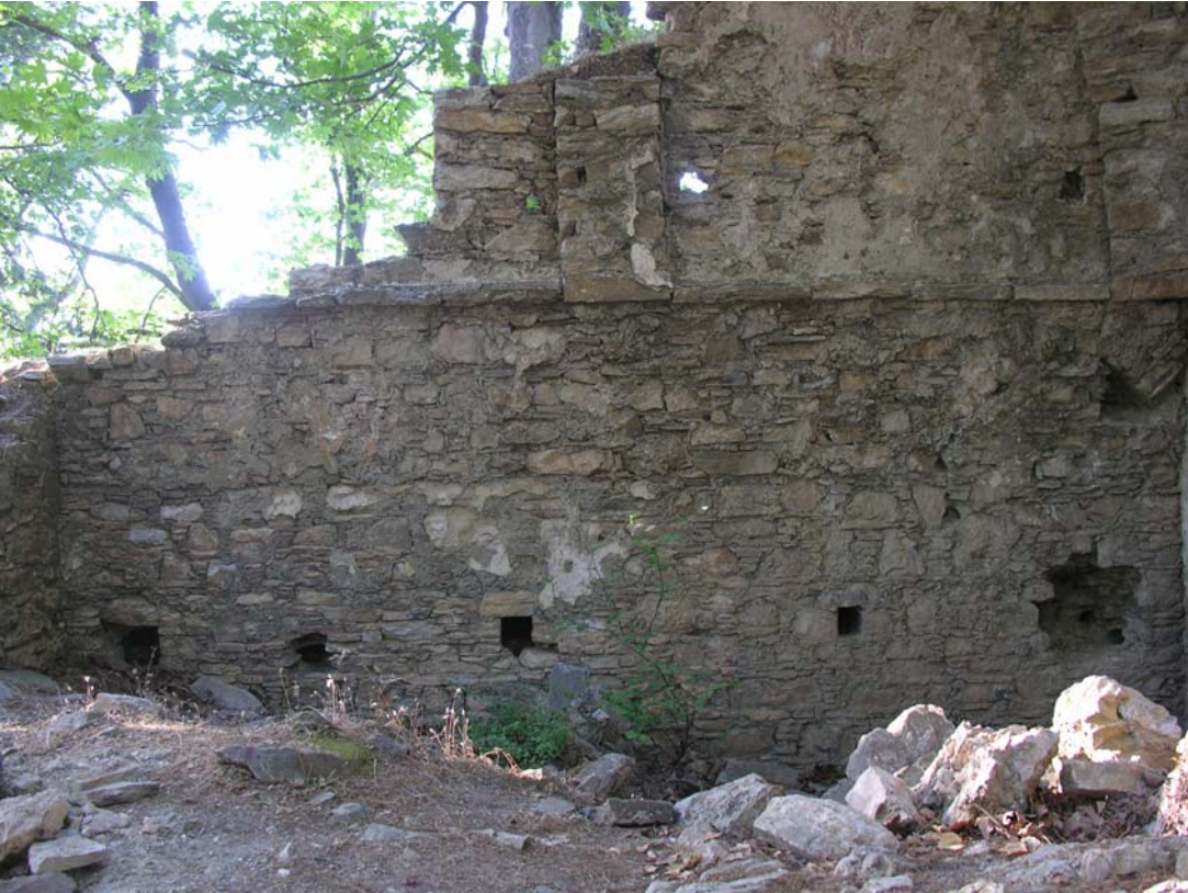
Şekil 97 - Kilise, batı giriş mekanı, kuzey duvarı ve üzerindeki hatıl delikleri
