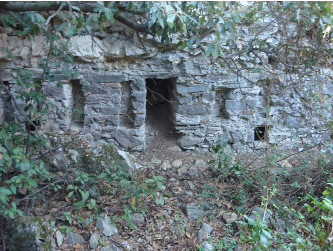
Şekil 137 - Trapeza, güney duvarı, pencere, giriş yuvaları ve hatıl delikleri
