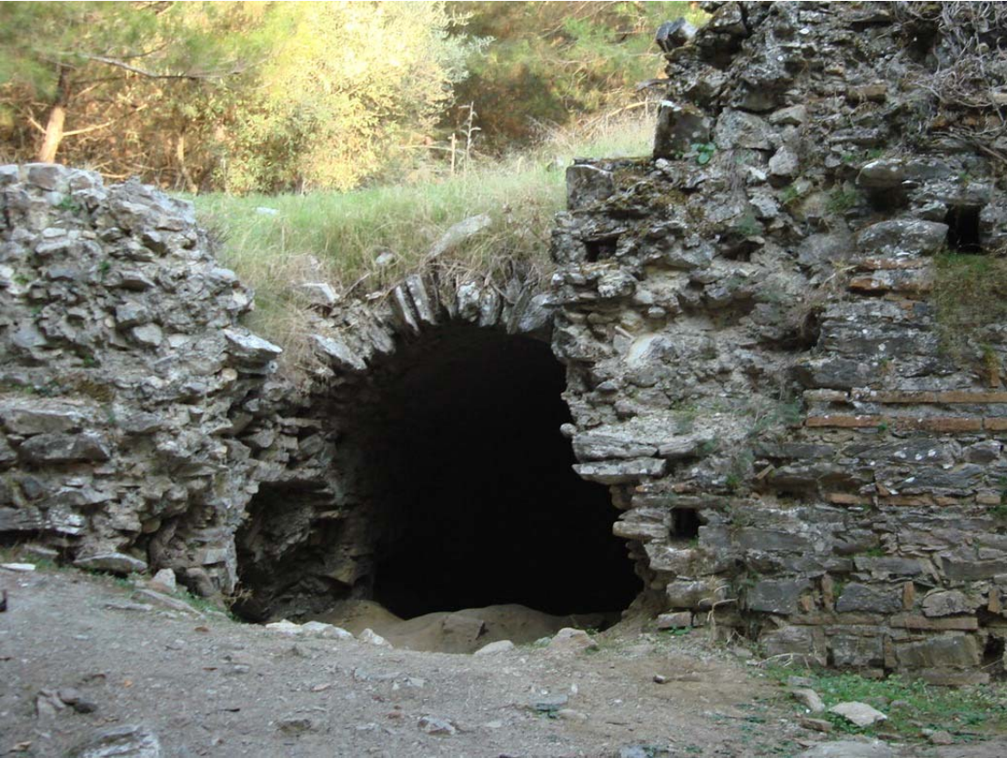
Şekil 179 - Mezar şapeli, batı duvarı, alt kat girişi
