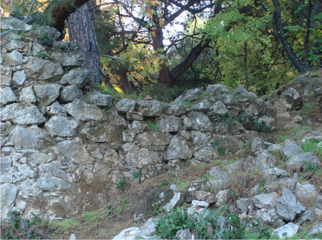
Şekil 165 - 15 no.lu hücre, batı duvarı, batıdan görünüm
