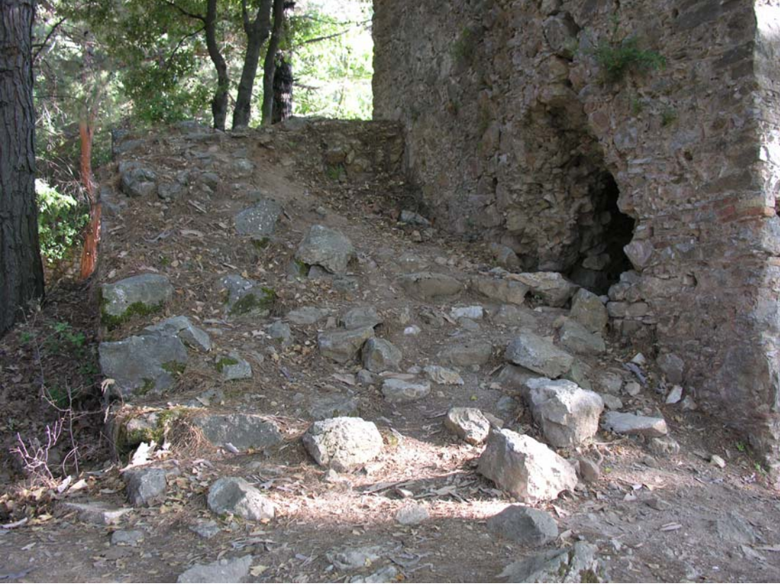
Şekil 110 - Kule, platforma çıkan rampa, kuzeyden görünüm
