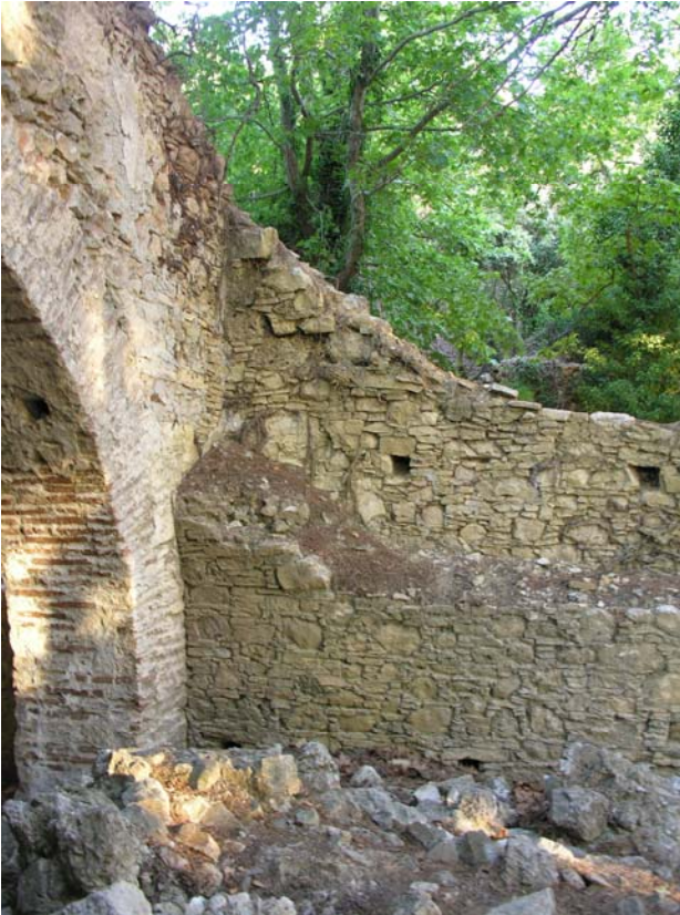
Şekil 99 - Kilise, batı giriş mekanı, güney duvardaki tonoz başlangıcı
