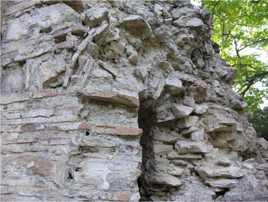
Şekil 63 - Kilise, apsis cephesi, kuzeydeki pencere, üzerinde testere dişli motif
