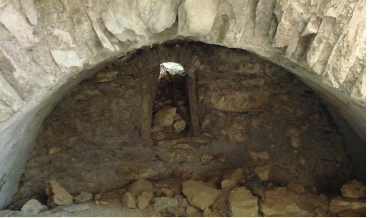
Şekil 185 - Mezar şapeli, alt kat güney duvarı, nişin iç duvarındaki pencere
