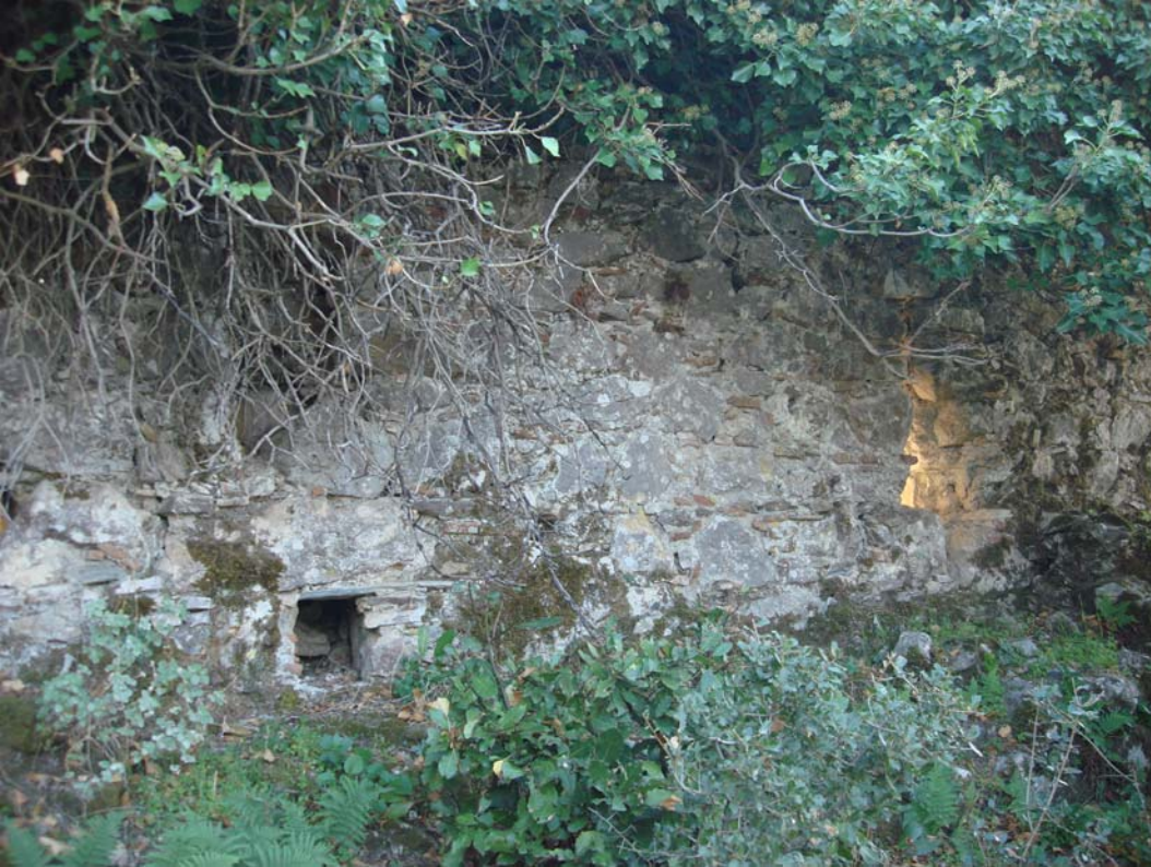
Şekil 7 - Kuzey çevre duvarı, aynı zamanda yemekhane duvarı olan batı bölümü
