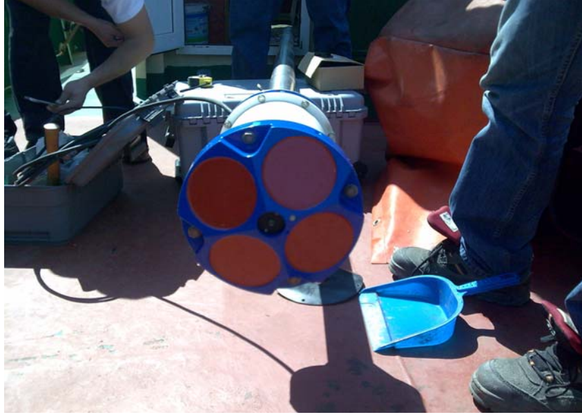
Şekil 6.53 Krom boruya ADCP montajı
