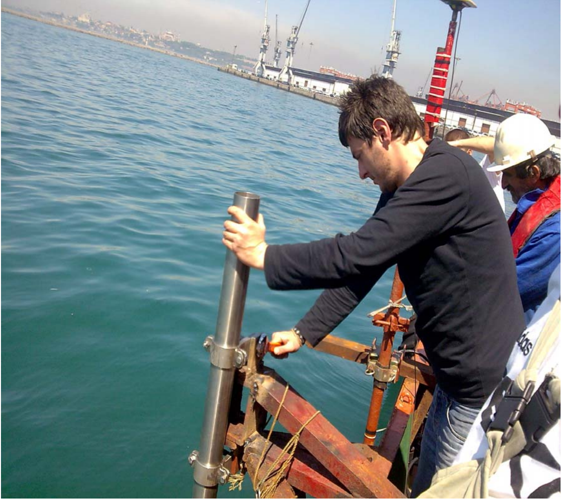
Şekil 6.41 Borunun ölçüm botuna monte edilmesi
