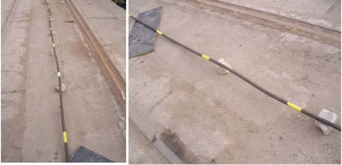
Şekil 6.15 Vinç telinin yükseklik kontrolü için işaretlenmesi
