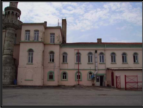
Resim 3.44 Kuzeydoğu cephesi-C bölümü
