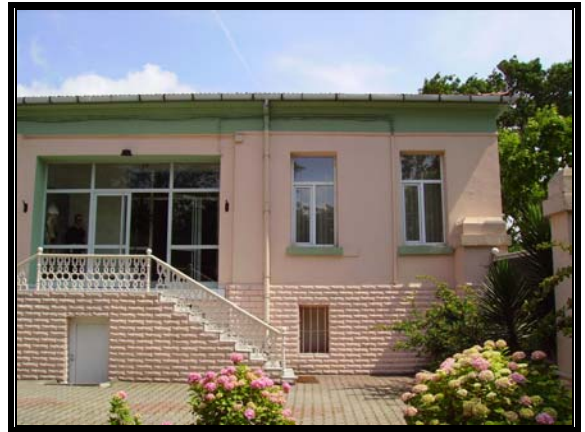
Resim 3.83 Orta avlu kuzeybatı cephesi
