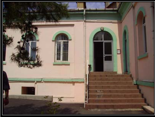
Resim 3.84 Orta avlu güneybatı cephesi-A bölümü
