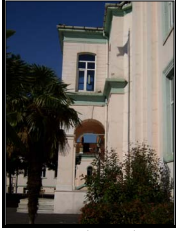
Resim 3.209 Cami güneybatı cephesi
