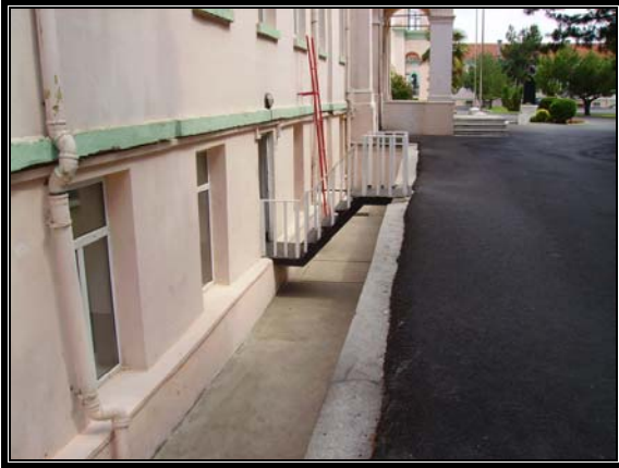
Resim 3.96 Orta avlu güneybatı cephesi- C bölümü
