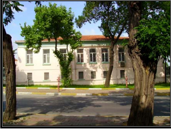
Resim 3.4 Güneybatı cephesi-A bölümü
