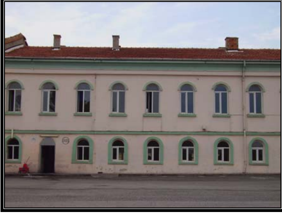
Resim 3.42 Kuzeydoğu cephesi-A bölümü
