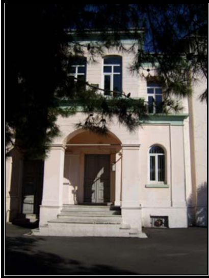
Resim 3.207 Cami güneybatı cephesi
