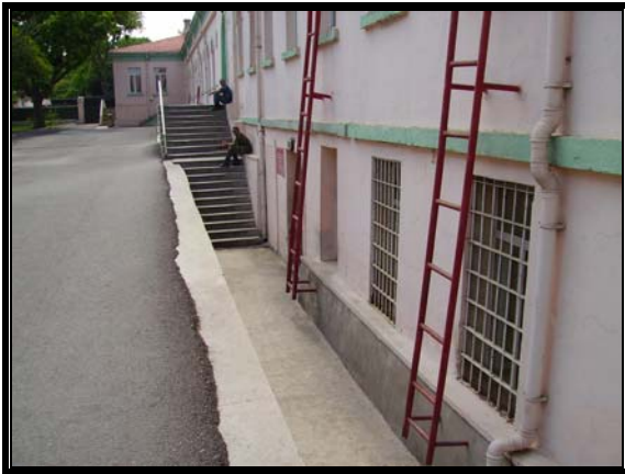
Resim 3.114 Orta avlu güneydoğu cephesi
