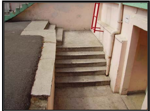
Resim 3.99 Orta avlu güneybatı cephesi- C bölümü
