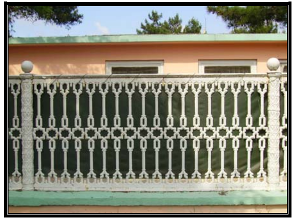
Resim 3.13 Güneybatı cephesi- korkuluk
