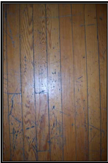
Resim 3.223 ZK 63 OFİS döşemesi
