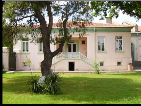
Resim 3.100 Orta avlu güneydoğu cephesi
