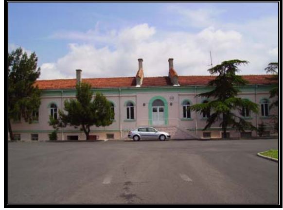
Resim 3.73 Orta avlu kuzeybatı cephesi
