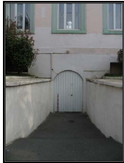
Resim 3.218 Cami kuzeydoğu cephesi-giriş kapısı
