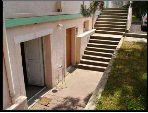
Resim 3.72 Orta avlu kuzeybatı cephesi
