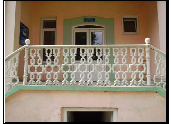
Resim 3.101 Orta avlu güneydoğu cephesi
