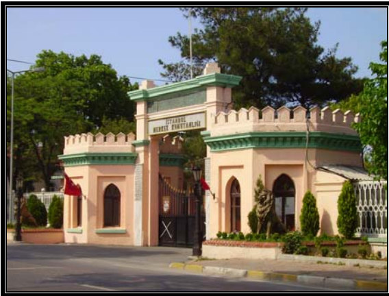
Resim 3.8 Güneybatı cephesi-giriş kapısı
