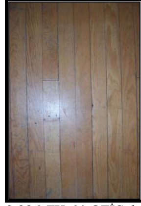
Resim 3.226 ZK 64 OFİS döşemesi
