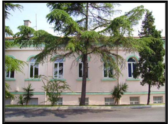
Resim 3.77 Orta avlu kuzeybatı cephesi
