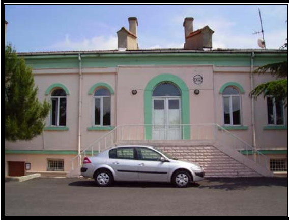
Resim 3.74 Orta avlu kuzeybatı cephesi
