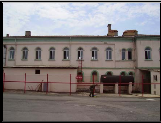
Resim 3.46 Kuzeydoğu cephesi-C bölümü
