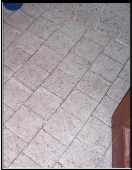
Resim 3.229 ZK 65 WC döşemesi
