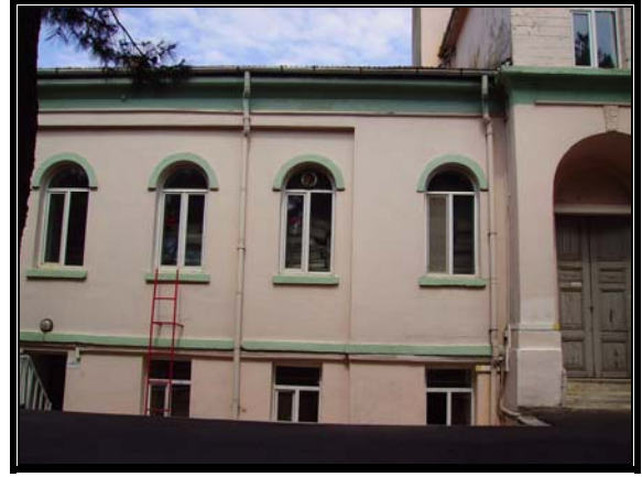
Resim 3.91 Orta avlu güneybatı cephesi- C bölümü
