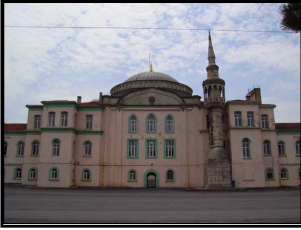
Resim 3.213 Cami kuzeydoğu cephesi
