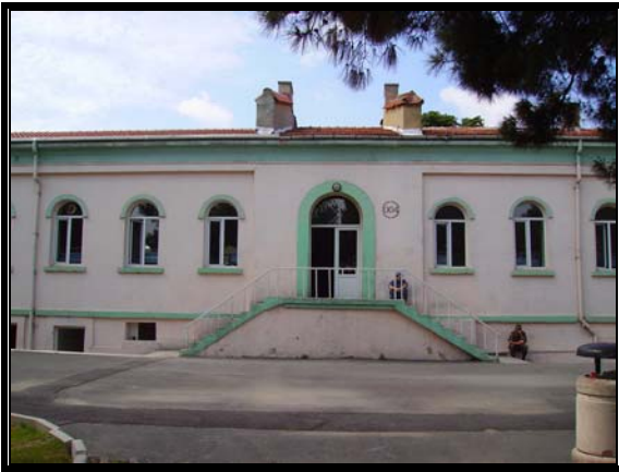
Resim 3.108 Orta avlu güneydoğu cephesi
