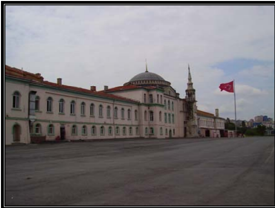
Resim 3.40 Kuzeydoğu cephesi-A bölümü
