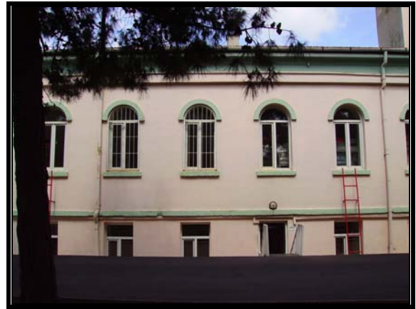
Resim 3.93 Orta avlu güneybatı cephesi- C bölümü
