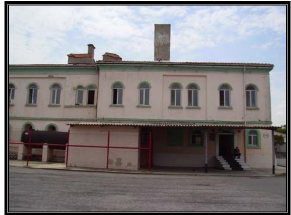
Resim 3.47 Kuzeydoğu cephesi-C bölümü
