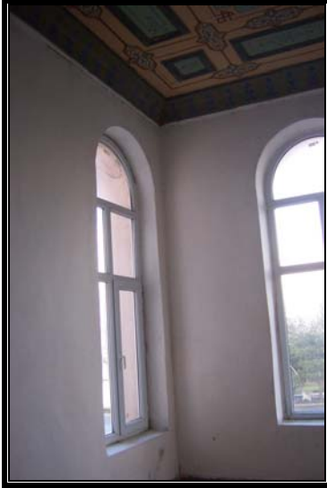
Resim 3.155 ZK 77 MEKANI duvarı
