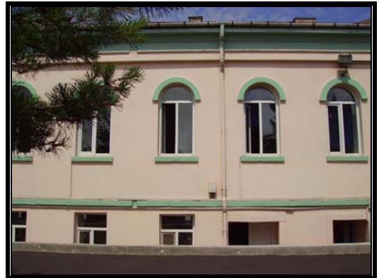
Resim 3.87 Orta avlu güneybatı cephesi-A bölümü
