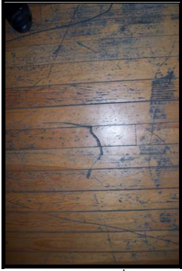
Resim 3.243 1K3 OFİS döşemesi
