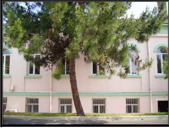
Resim 3.68 Orta avlu kuzeybatı cephesi
