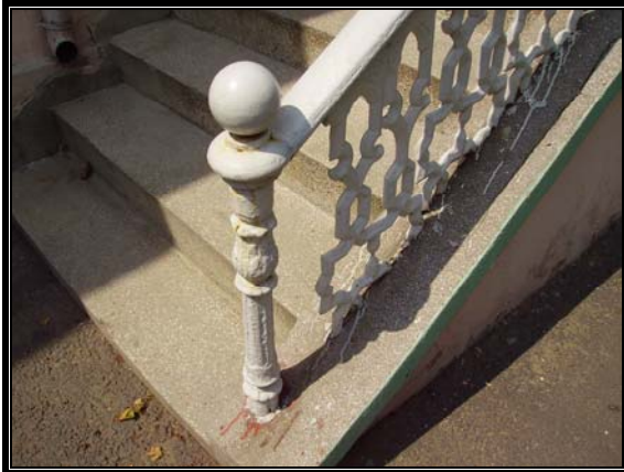
Resim 3.102 Orta avlu güneydoğu cephesi
