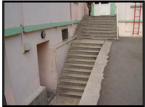
Resim 3.115 Orta avlu güneydoğu cephesi
