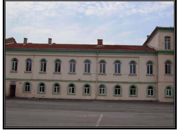
Resim 3.43 Kuzeydoğu cephesi-A bölümü
