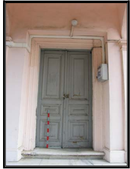
Resim 3.212 Cami güneybatı cephesi- giriş kapısı
