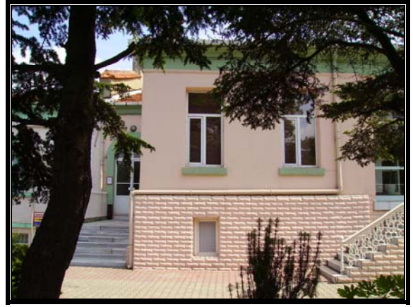
Resim 3.81 Orta avlu kuzeybatı cephesi
