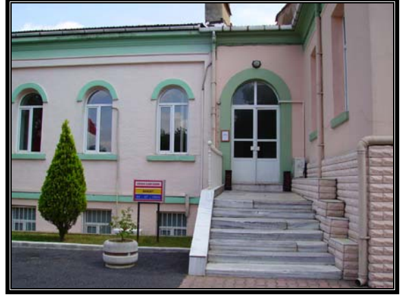
Resim 3.79 Orta avlu kuzeybatı cephesi
