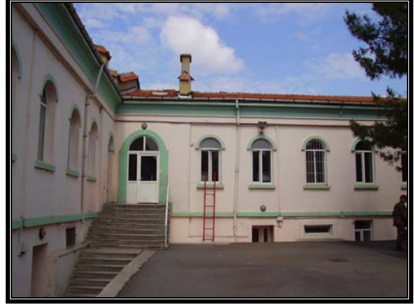
Resim 3.95 Orta avlu güneybatı cephesi- C bölümü
