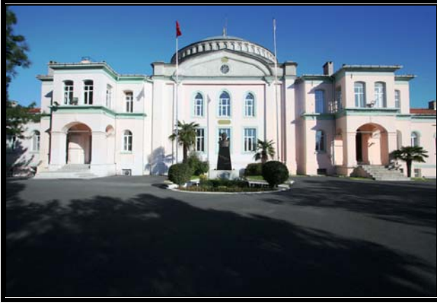
Resim 3.205 Cami güneybatı cephesi
