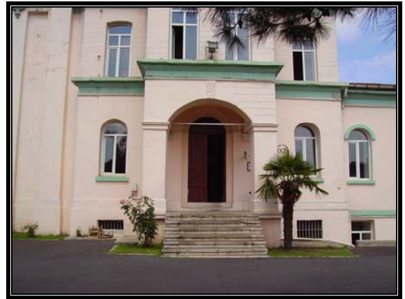
Resim 3.262 Hünkar dairesi güneybatı cephesi
