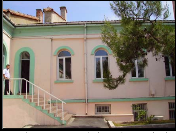
Resim 3.66 Orta avlu kuzeybatı cephesi
