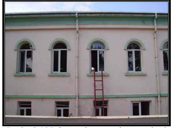
Resim 3.105 Orta avlu güneydoğu cephesi
