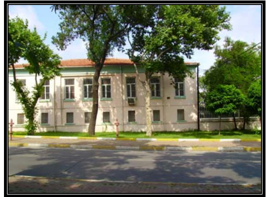
Resim 3.3 Güneybatı cephesi-A bölümü
