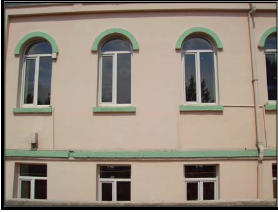
Resim 3.88 Orta avlu güneybatı cephesi- A bölümü
