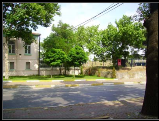
Resim 3.2 Güneybatı cephesi- A bölümü
