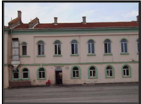
Resim 3.41 Kuzeydoğu cephesi-A bölümü
