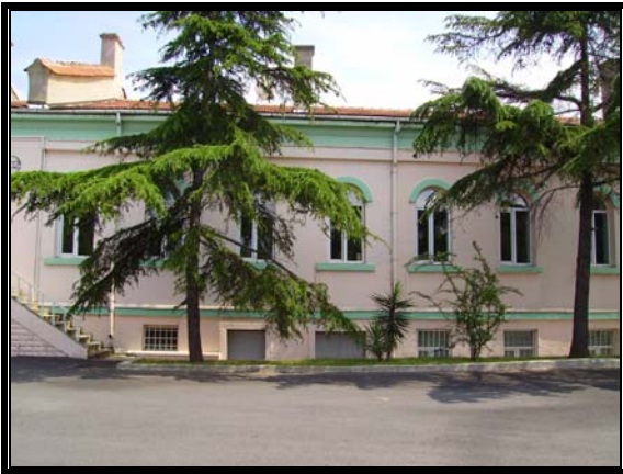
Resim 3.76 Orta avlu kuzeybatı cephesi
