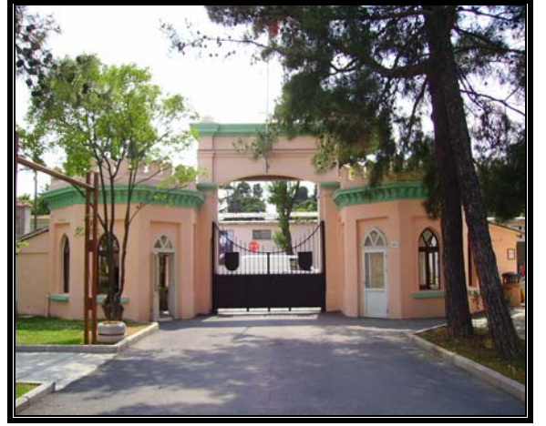
Resim 3.118 Nöbetçi kulübeleri ve giriş kapısı
