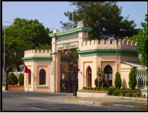
Resim 3.117: Nöbetçi kulübeleri ve giriş kapısı
