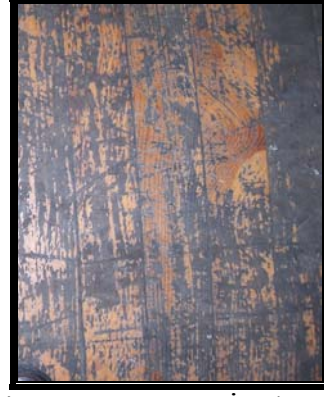
Resim 3.254 1K7 OFİS döşemesi
