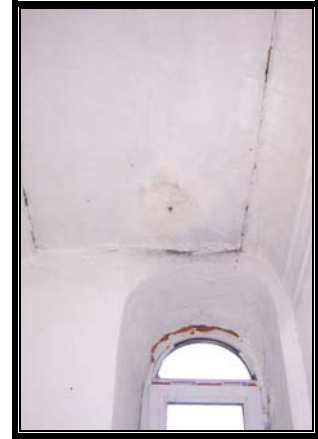
Resim 3.158 ZK 78 WC duvarı
