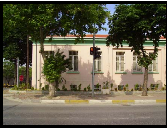
Resim 3.12 Güneybatı cephesi-C bölümü
