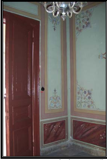
Resim 3.125 ZK 70 GİRİŞ HOLÜ duvarı
