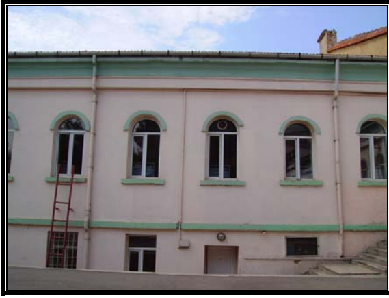
Resim 3.112 Orta avlu güneydoğu cephesi
