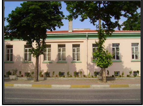
Resim 3.11 Güneybatı cephesi-C bölümü
