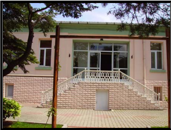
Resim 3.82 Orta avlu kuzeybatı cephesi
