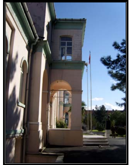
Resim 3.208 Cami güneybatı cephesi
