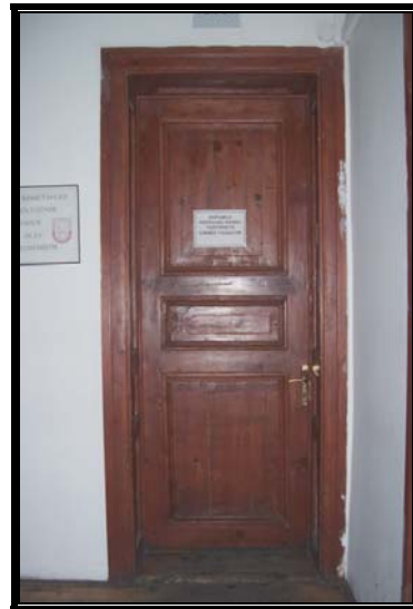
Resim 3.252 1K6 DEPO kapısı
