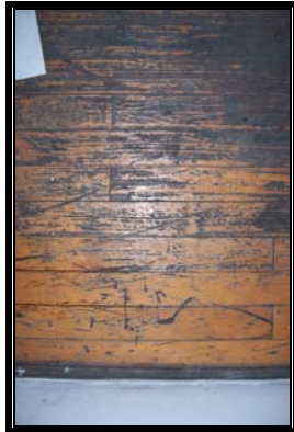
Resim 3.257 1K8 OFİS döşemesi
