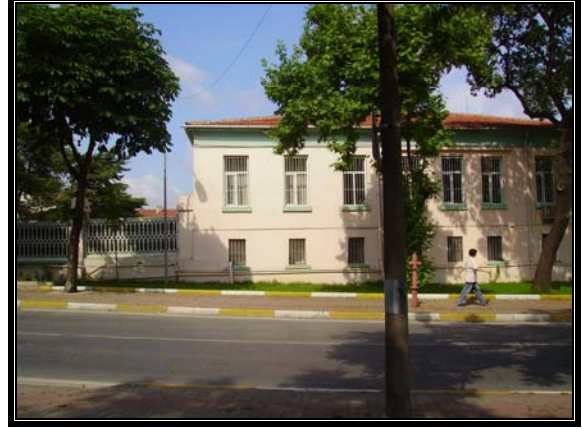
Resim 3.5 Güneybatı cephesi-A bölümü
