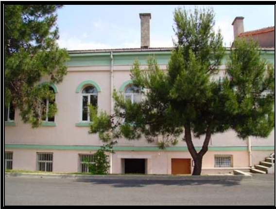
Resim 3.70 Orta avlu kuzeybatı cephesi
