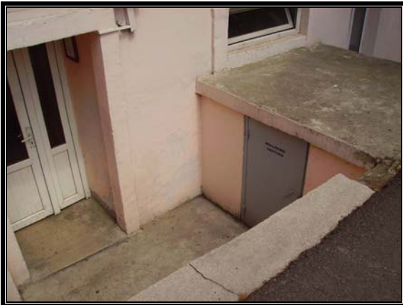
Resim 3.98 Orta avlu güneybatı cephesi- C bölümü
