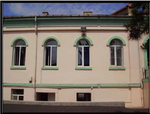
Resim 3.86 Orta avlu güneybatı cephesi-A bölümü
