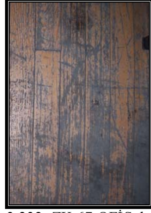
Resim 3.232 ZK 67 OFİS döşemesi
