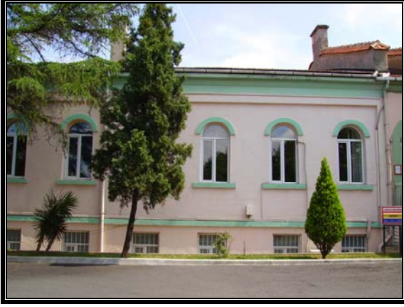
Resim 3.78 Orta avlu kuzeybatı cephesi
