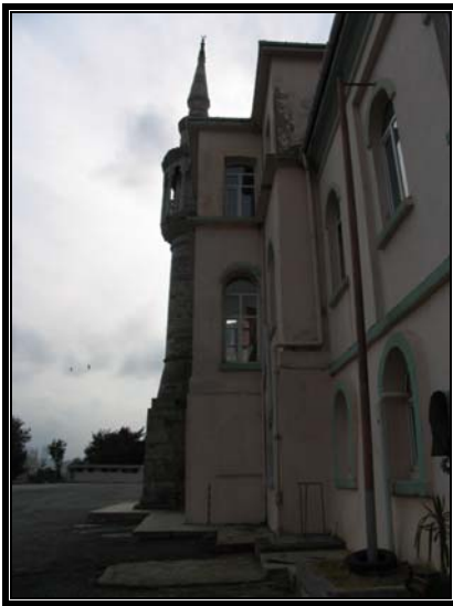
Resim 3.217 Cami kuzeydoğu cephesi
