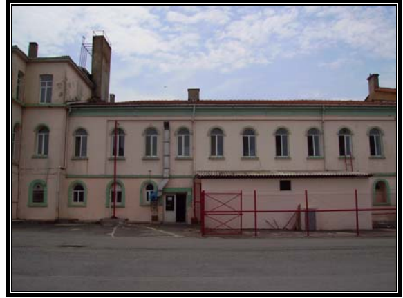
Resim 3.45 Kuzeydoğu cephesi-C bölümü
