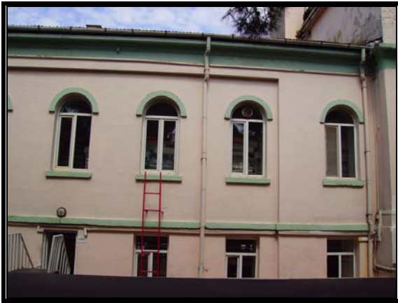
Resim 3.92 Orta avlu güneybatı cephesi- C bölümü
