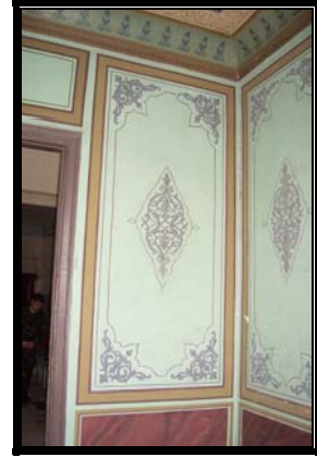
Resim 3.152 ZK 76 MEKANI duvarı
