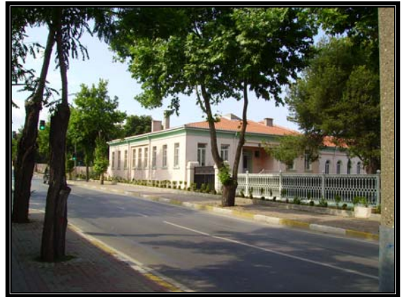
Resim 3.9 Güneybatı cephesi-C bölümü
