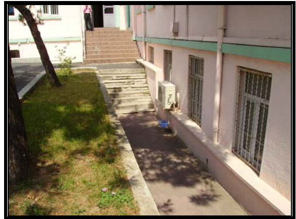
Resim 3.71 Orta avlu kuzeybatı cephesi
