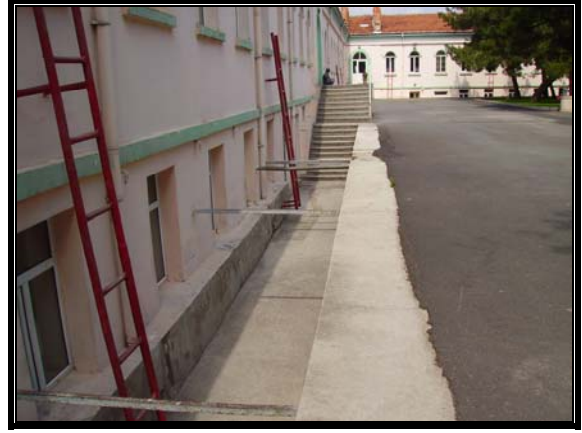
Resim 3.107 Orta avlu güneydoğu cephesi
