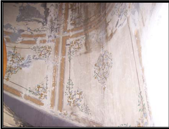
Resim 3.199 M2 MERDİVENİ duvarı
