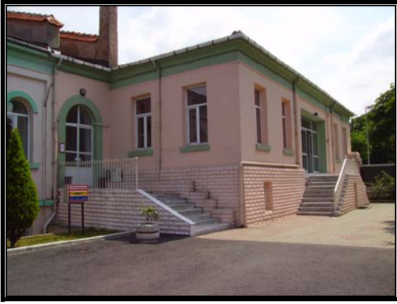
Resim 3.80 Orta avlu kuzeybatı cephesi
