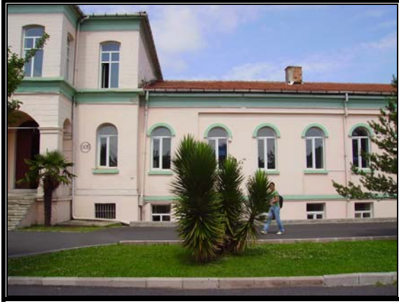
Resim 3.90 Orta avlu güneybatı cephesi- A bölümü
