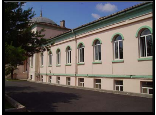
Resim 3.85 Orta avlu güneybatı cephesi-A bölümü
