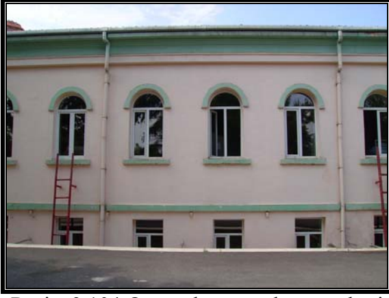
Resim 3.104 Orta avlu güneydoğu cephesi
