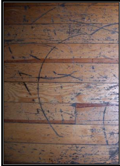
Resim 3.235 ZK 68 OFİS döşemesi
