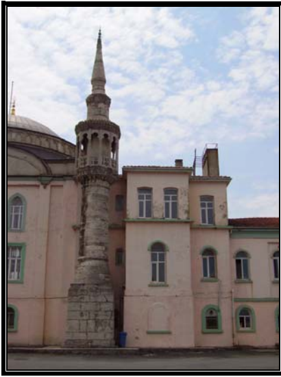
Resim 3.215 Cami kuzeydoğu cephesi
