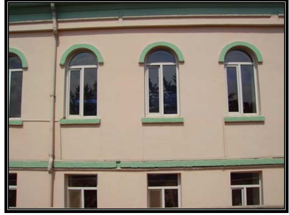
Resim 3.89 Orta avlu güneybatı cephesi- A bölümü
