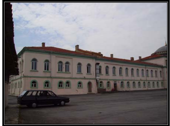
Resim 3.39 Kuzeydoğu cephesi-A bölümü
