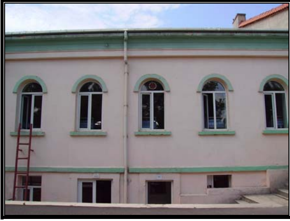
Resim 3.106 Orta avlu güneydoğu cephesi
