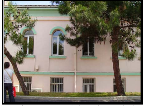
Resim 3.67 Orta avlu kuzeybatı cephesi
