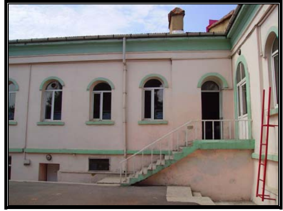
Resim 3.113 Orta avlu güneydoğu cephesi
