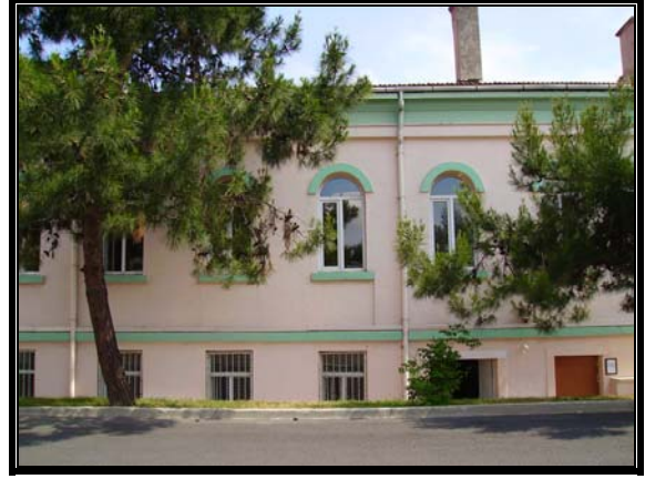
Resim 3.69 Orta avlu kuzeybatı cephesi
