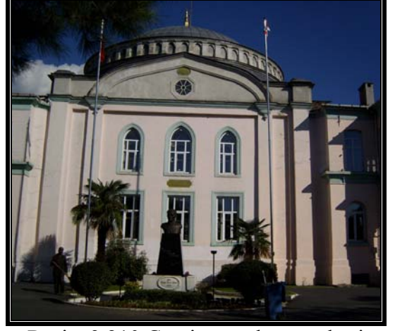
Resim 3.210 Cami güneybatı cephesi
