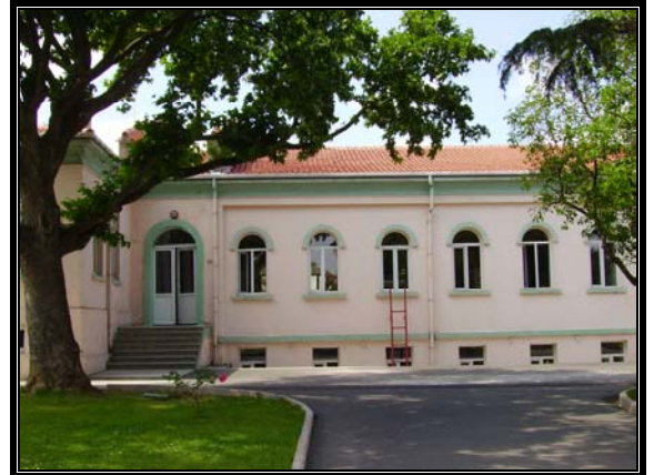
Resim 3.103 Orta avlu güneydoğu cephesi
