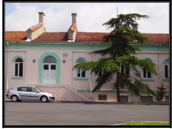
Resim 3.75 Orta avlu kuzeybatı cephesi
