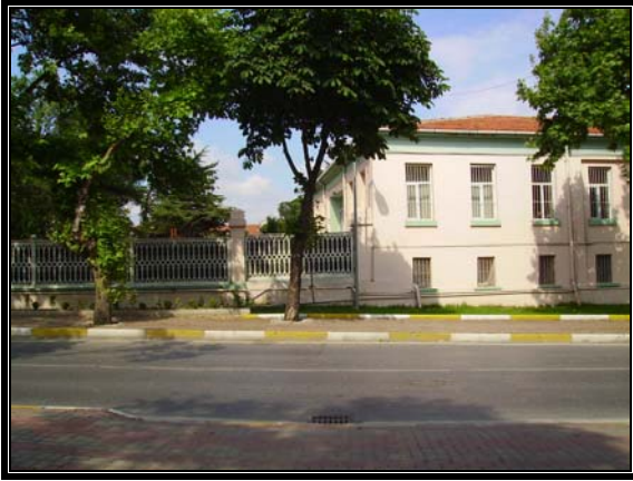
Resim 3.6 Güneybatı cephesi-A bölümü
