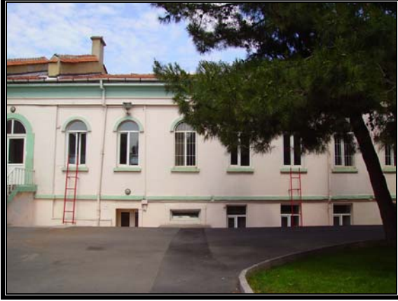
Resim 3.94 Orta avlu güneybatı cephesi- C bölümü
