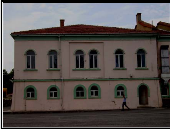
Resim 3.38 Kuzeydoğu cephesi-A bölümü
