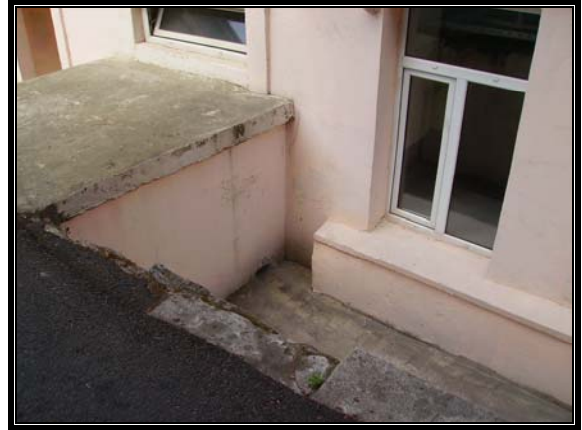
Resim 3.97 Orta avlu güneybatı cephesi- C bölümü
