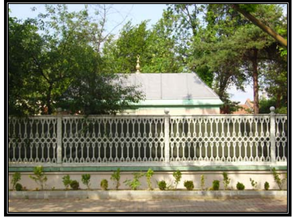
Resim 3.7 Güneybatı cephesi-bahçe duvarı
