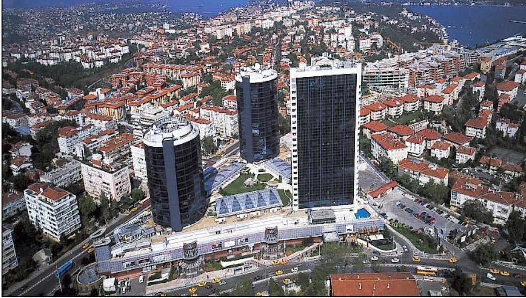
Şekil 2.1.3 Akmerkez'in havadan görüntüsü [57].
