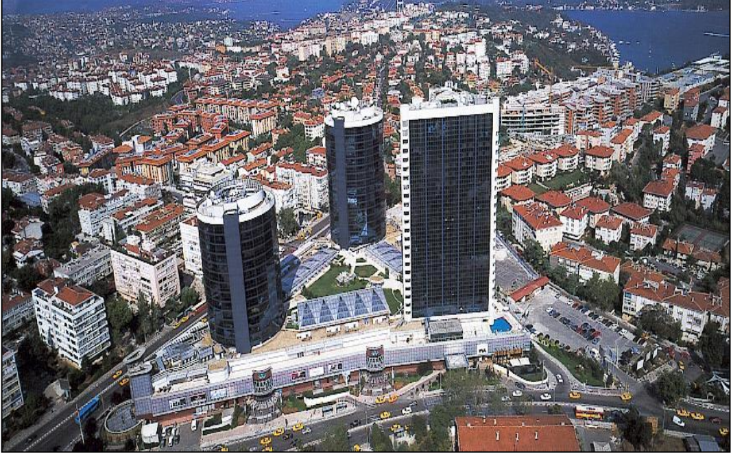
Şekil 4.1.8 Akmerkez hava fotoğrafı [52].
