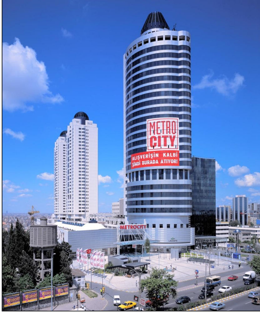
Şekil 4.1.9 Metrocity genel görünüş [51].
