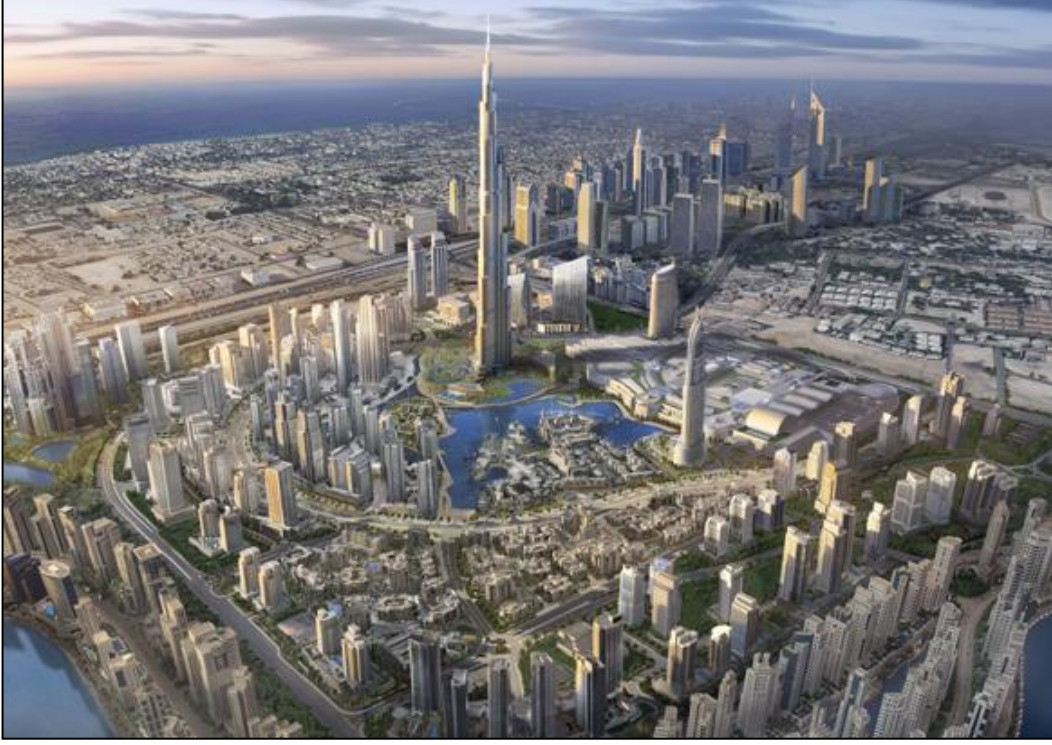
Şekil 3.1.21 Dubai Mall hava fotoğrafı [35].
