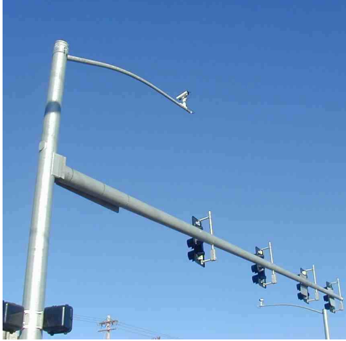
Şekil 2.8 Kameranın farklı bir şekilde yerleştirilmesi (Missouri – ABD, modot.mo.gov/stlouis/links/signalcameras.htm ).
