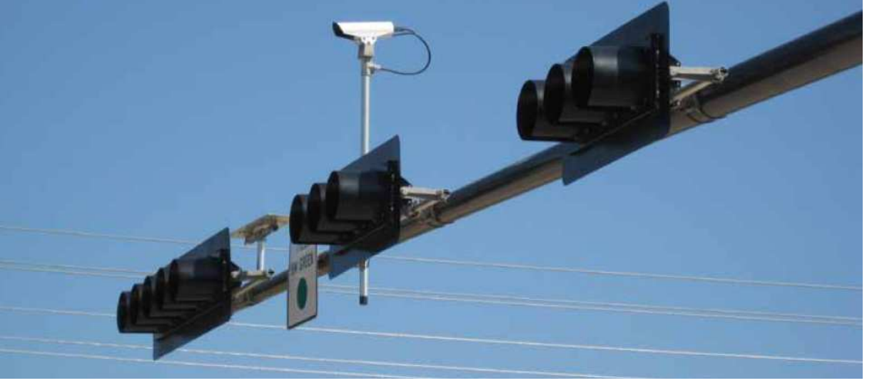
Şekil 2.7 Kameranın trafik ışıklarının yanına yerleştirilmesi (Teksas - ABD , modot.mo.gov/stlouis/links/signalcameras.htm ).
