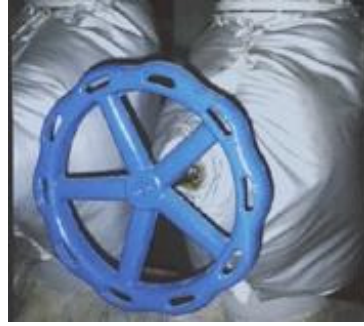
Şekil 7.14 Prefabrik vana izolasyon ceketi
