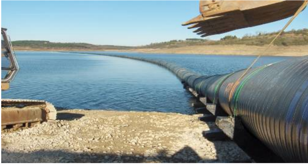
Şekil 1.7 İçmesuyu iletim hattı deniz deşarjı
