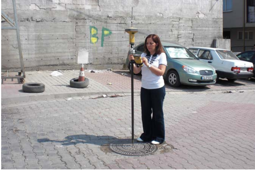
Şekil 4.7 Atıksu hatlarının GNSS alıcısı ile ölçümleri
