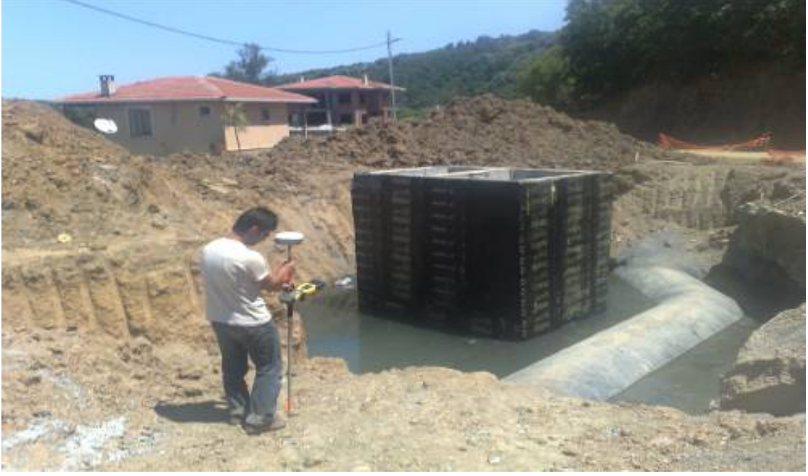
Şekil 5.8 UKBS'den faydalanarak içmesuyu tesisinin tranşe açıkken ölçümü
