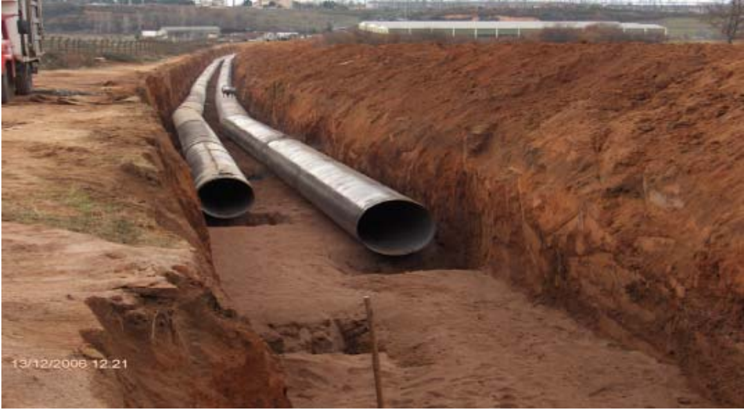
Şekil 1.9 Çelik boru imalatı
