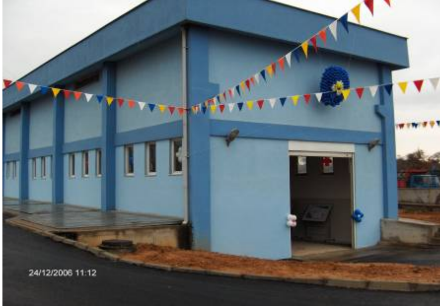
Şekil 1.6 İçmesuyu arıtma tesisi
