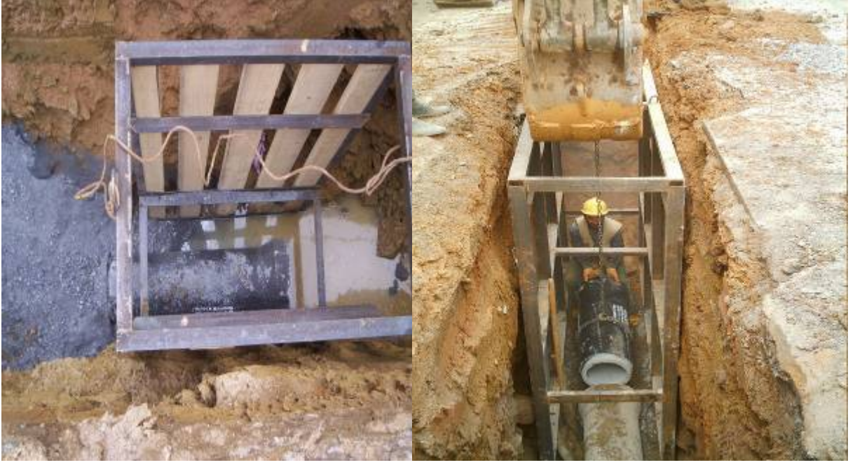
Şekil1.3 İksalı atıksu şebeke imalatı
