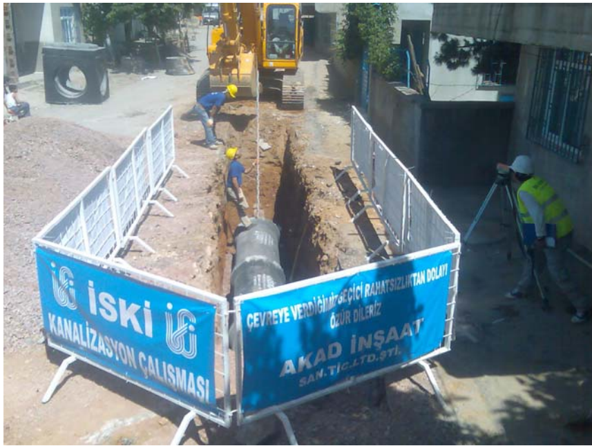
Şekil 3.3 Atıksu imalatının eğim kontrolü
