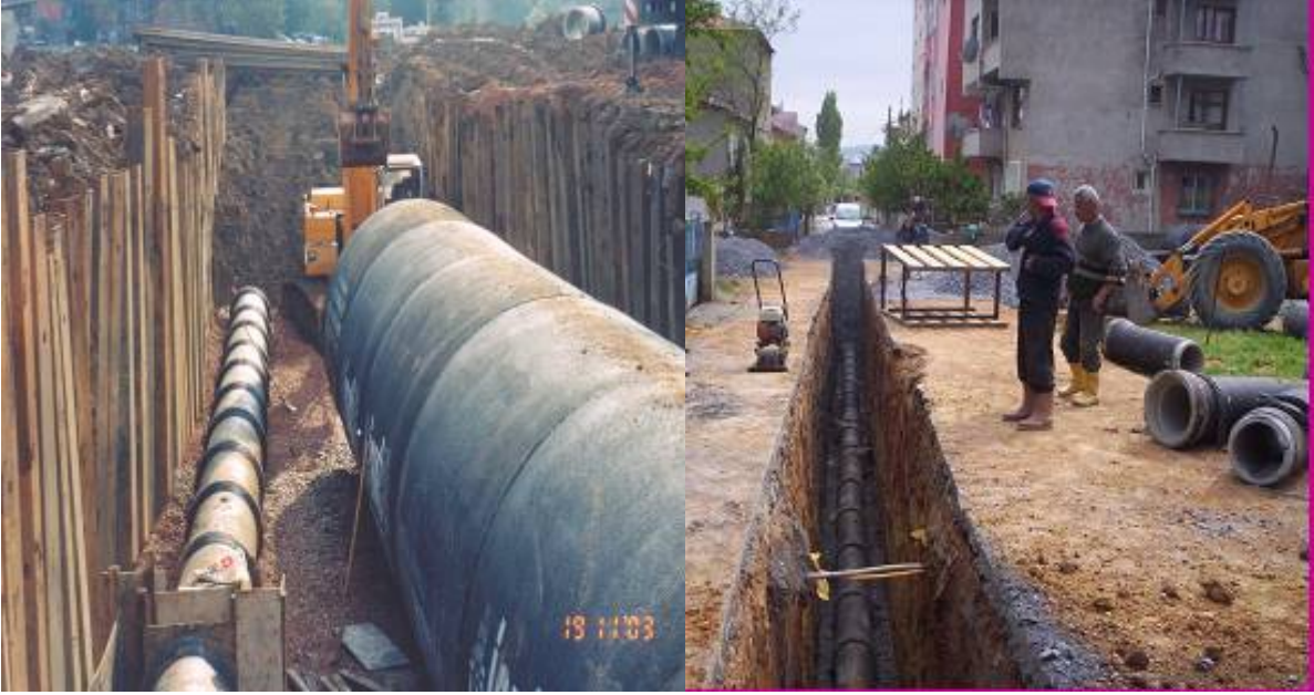
Şekil 1.1 Atıksu kuşaklama kollektörü ve şebeke imalatı
