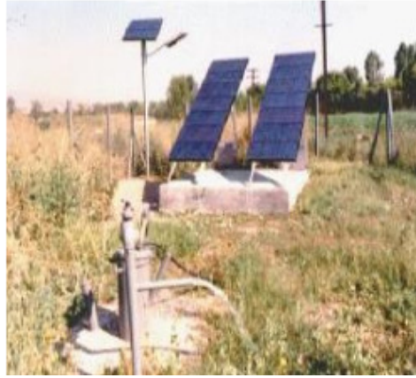
Şekil 2.7 Güneş pili su pompalama sistemi
